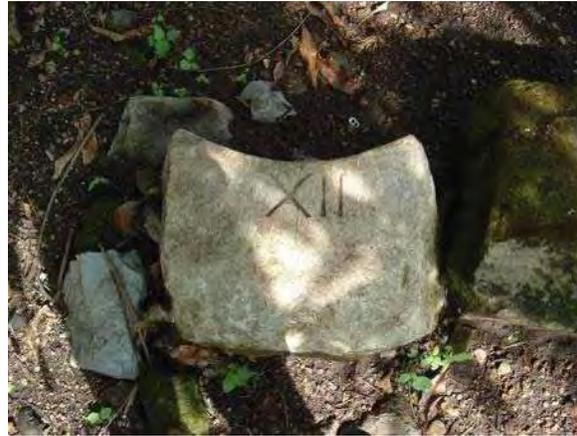
*Imagen 102. Detalle numerado de una de las piezas del empedrado circular del pavimento. El correcto corte de la piedra habla de un conocimiento razonable de estereotomía.*
