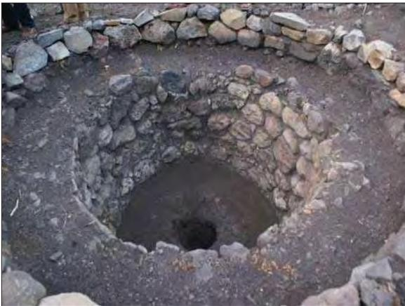
Imagen 6. Parte interna del pozo para cocimiento de agave del Tecuane con la sangría inferior para recoger las mieles excedentes.
