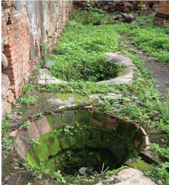
*Imagen 214. Los asientos de alambique en San Antonio están recubiertos con losetas de barro para permitir una mejor distribución del fuego que era avivado desde los fogones inferiores. La falta de tanques de resfrío junto a los asientos de alambique permite inferir que se trataba de destiladores de montera, de ascendencia filipina que no requieren de serpentín.*
