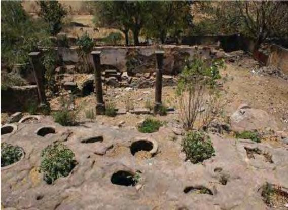
*Imagen 140. Aspecto general del espacio de fermentación de la taberna de Santa María. Al fondo se ven las columnas que soportaban la cubierta del área de destilación y el acueducto para alimentar las tinas de resfrío.*
