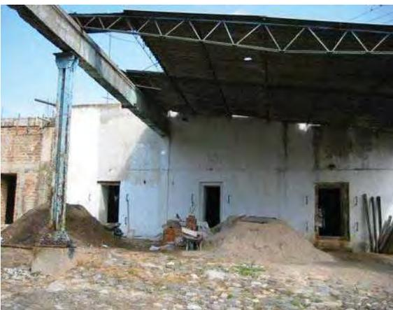
*Imagen 74. Batería de hornos de La Martineña, destilería ubicada en Tequila. En este caso los hornos se llenan desde el patio de descarga y se vacían con el mezcal cocido hacia al espacio de molienda.*
