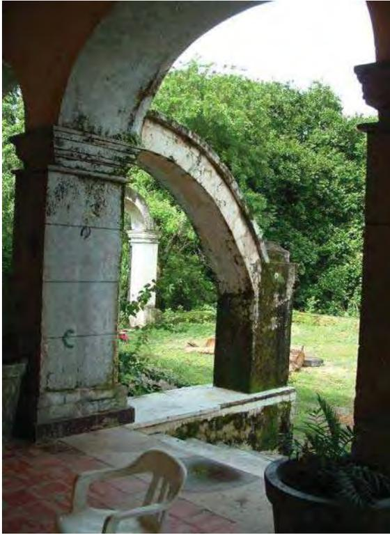
Imagen 26. Contrafuertes para contrarrestar los esfuerzos provocados por la pesada bóveda de cañón que cubre las dependencias de la casa grande.
