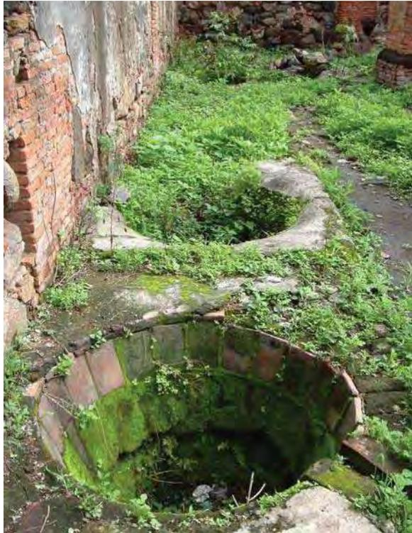
Imagen 41. Los asientos de alambique están recubiertos con losetas de barro para permitir una mejor distribución del fuego que era avivado desde los fogones inferiores.
