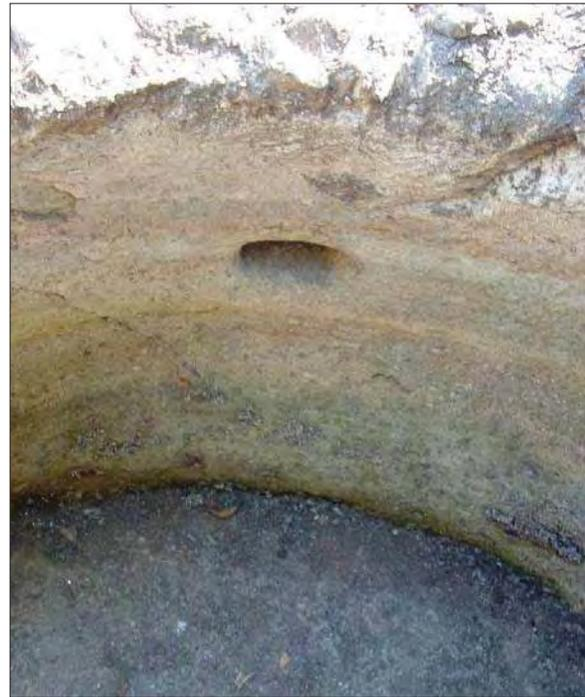
Imagen 14. Otra de las muescas labradas para el ascenso y descenso de los operarios.
