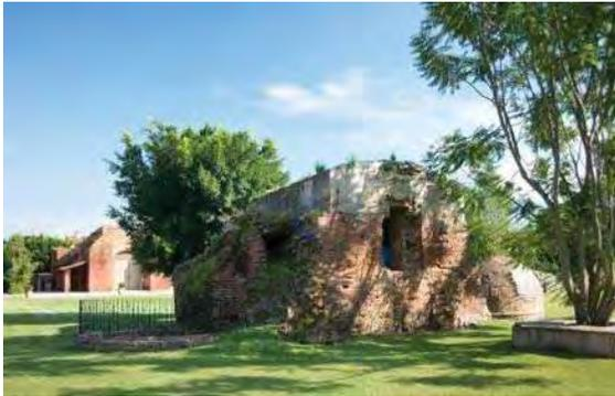
*Imagen 56. Gran horno de mampostería de la taberna de El Carmen. La boca alta de este ingenio era utilizada para llenar desde arriba con cabezas de agave el horno previamente calentado con leña.*
