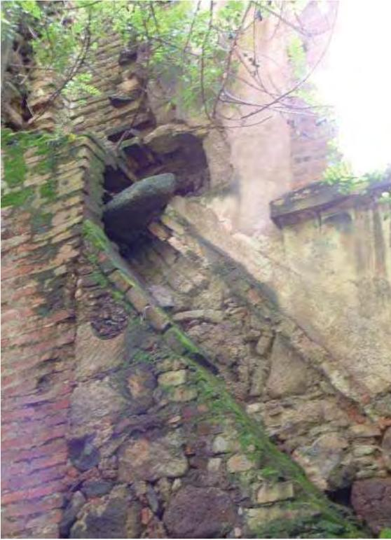
*Imagen 44. Ducto de conducción de humos hacia el chacuaco. La utilización del principio de que el aire caliente tiende a elevarse se utiliza ingeniosamente para avivar el fuego, permitiendo una mejor destilación.*
