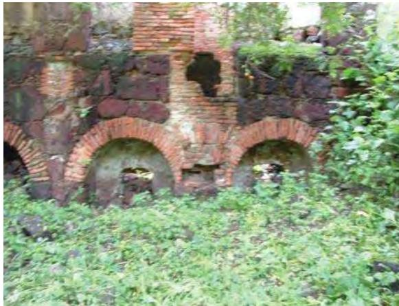
Imagen 43. Arcos de refuerzo de las bocas de fogón desde donde se introducía la leña para el calentamiento de los alambiques. Los asientos se comunicaban por un ducto hacia los chacuacos.
