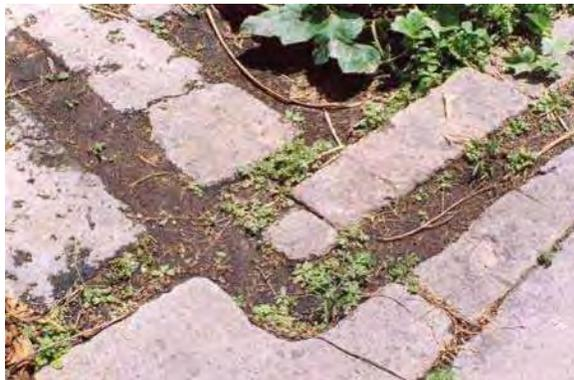
Imagen 147. Canallillos para la conducción de mosto desde las tabonas hacia los pozos de fermentación en San Andrés.
