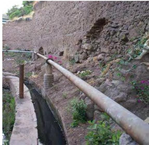
*Imagen 52. Sistema de conducción de aguas del río Atizcua hacia las destilerías de Tequila.*
