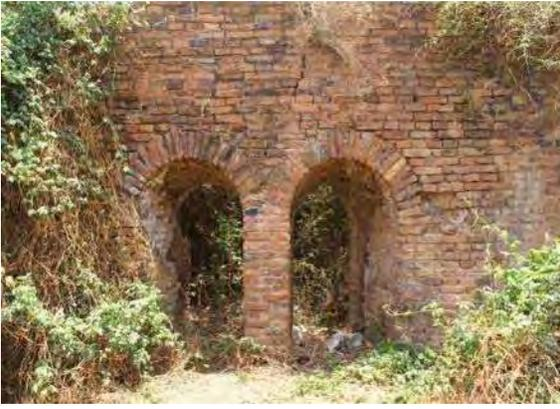
*Imagen 66. Detalle de los accesos gemelos a los hornos en la hacienda de La Providencia. Sus muros son sumamente anchos a fin de preservar el calor de la leña con que se calentaban antes de introducir el agave.*
