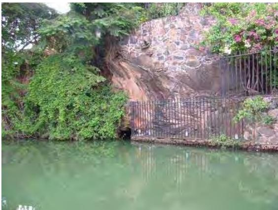
*Imagen 69. Depósito o alberca excavada en piedra contigua a la plaza principal de Amatitán donde se continúa recogiendo el agua captada por las galerías filtrantes. De esta fuente de agua se alimentó la taberna de El Veinte, ubicada calle de por medio.*
