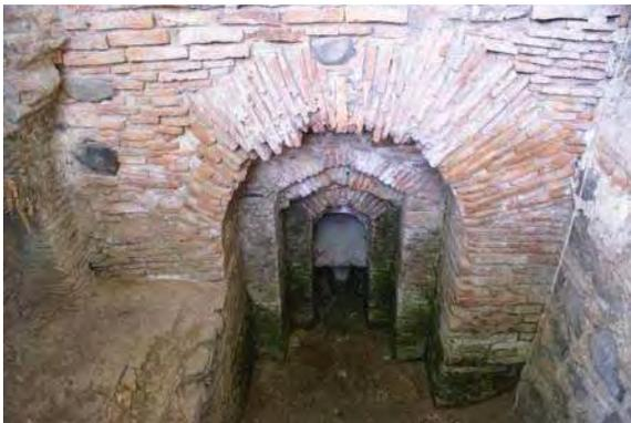
Imagen 46. Para llegar al hogar de alimentación del fuego a leña, se construyó un espacio inferior excavado en el suelo al que se accede a través de una escalera.
