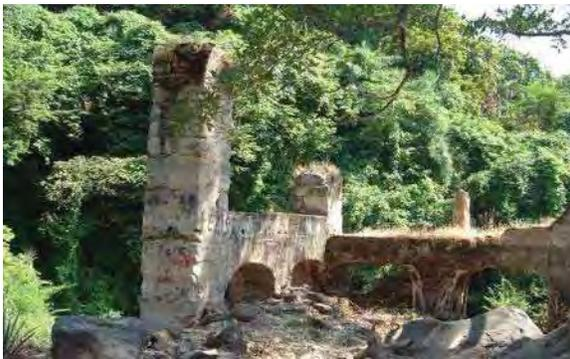
Imagen 189. Aspecto del acueducto y las pilastras que soportaron una cubierta de teja sobre el espacio de alambiques de El Tecuane.
