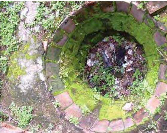
Imagen 42. Vista de uno de los pozos. Su parte inferior se comunica con los fogones que eran alimentados desde una plataforma exterior, más baja.
