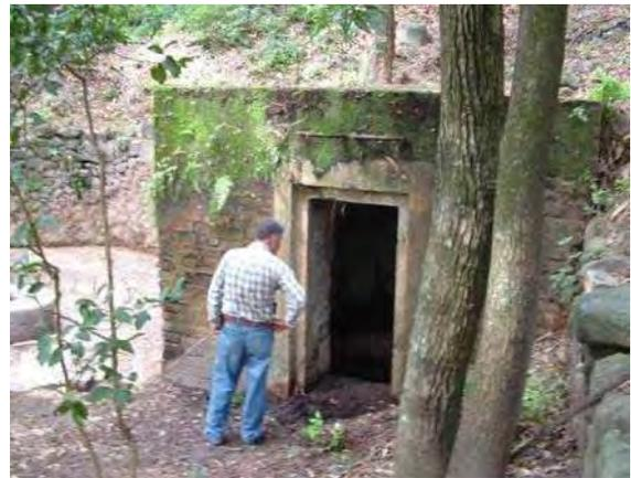
*Imagen 69. Horno de mampostería de La Miniatura. Era calentado a leña para posteriormente ser llenado con agave desde la parte superior.*
