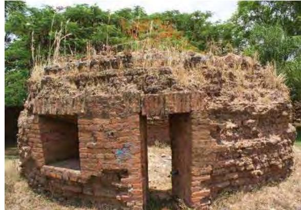
*Imagen 67. El inusual horno circular para cocimiento de mezcal en La Gavilana esta conformado por muros de adobe y tuvo una bóveda semiesférica.*
