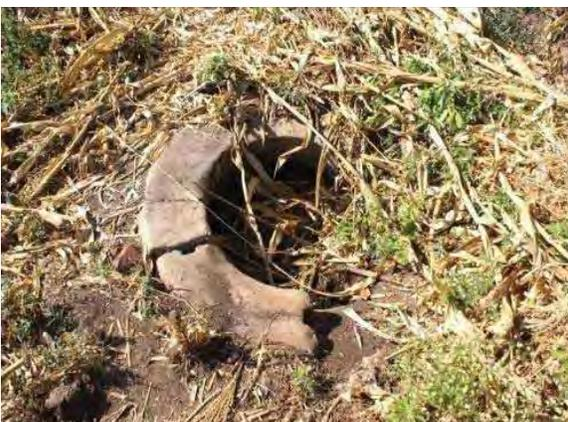
*Imagen 142. Brocal de piedra labrada en una de las bocas de las pilas.*
