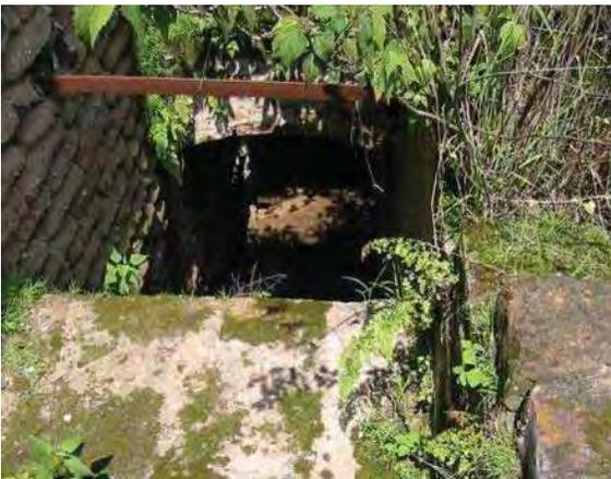
Imagen 64. Puentes de acceso a los hornos de mampostería de la hacienda de El Careño en El Arenal. Por la parte inferior estaba la boca de fogón.
