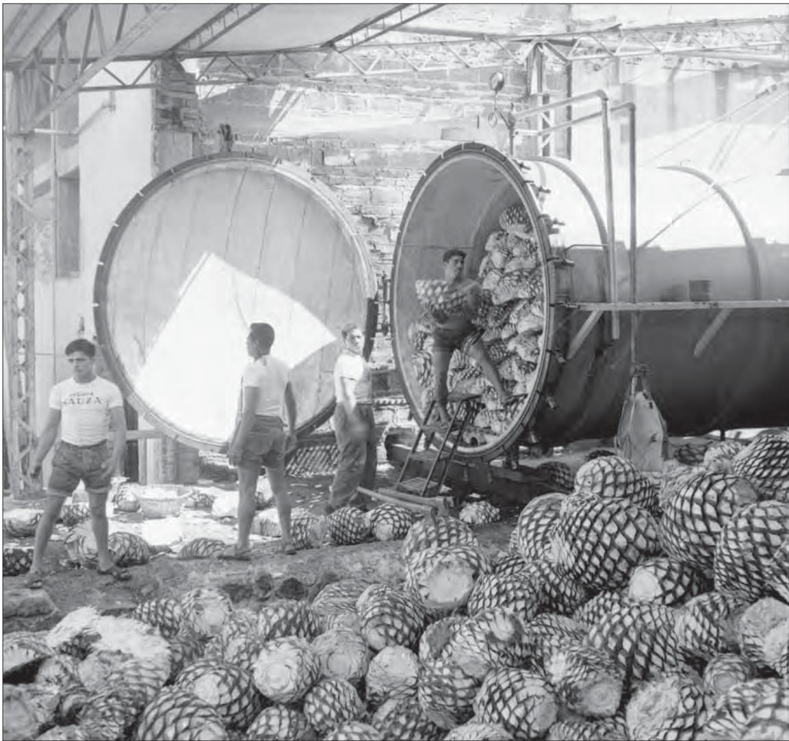
*Imagen 33. Un activo uso del espacio habitable lo constituye el llenado por parte de los borneros de carga de un horno de autoclave en la destilería industrial de La Perseverancia elaboradora de tequila Sauza. Fotografía tomada hacia 1960. Archivo Sauza Rosales.*
