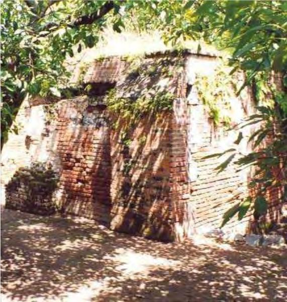
Imagen 62. En primer término, la recia presencia del borno de mampostería alimentado por un gran fogón ubicado en un nivel inferior en la hacienda de Santo Tomás en Hostotipaquillo.
