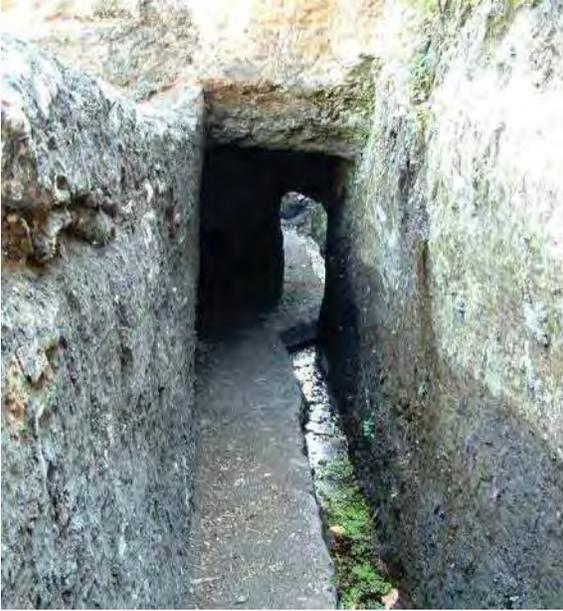
*Imagen 49. Estrecho canal excavado en el tepetate para recoger el agua freática en la taberna de El Tecuane.*
