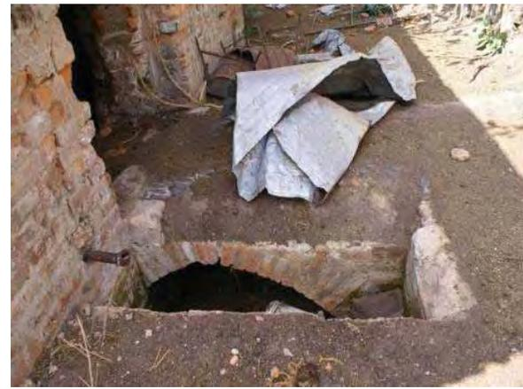
Imagen 65. Puentes para el acceso a los hornos desde el interior de la taberna de la hacienda de San Sebastián. En la parte inferior se localizaba la boca del fogón para la alimentación de leña que permitía el control del calor.
