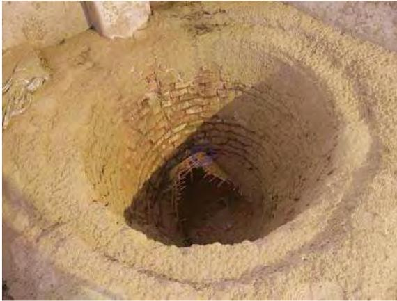
Imagen 45. Horno de pozo en la antigua taberna de la hacienda de La Labor de Rivera, Teuchitlán. La hornilla inferior para el fuego manifiesta una innovación respecto a los antiguos hornos de leña directa puesto que al separar los humos de la cámara de cocción permitía una mayor limpieza en el proceso al no abumar el mezcal.
