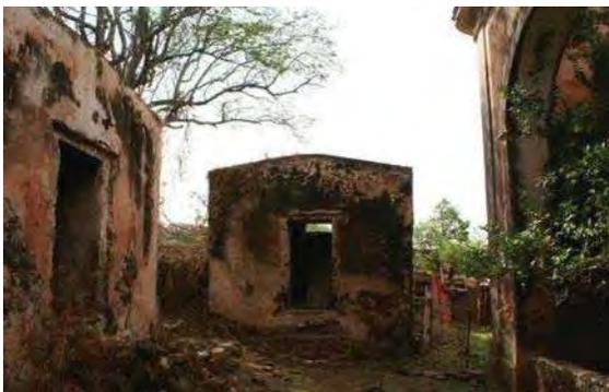
*Imagen 60. El par de hornos de la hacienda de San José Chapulimita tiene su ventana posterior para aventar las piñas de mezcal al interior y la boca de descarga a nivel para el retiro del agave cocido.*
