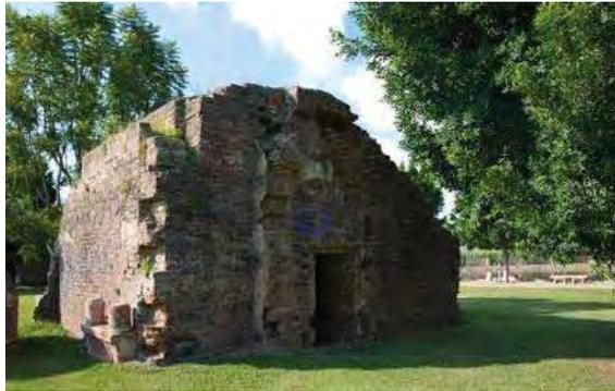
*Imagen 57. Otro aspecto del horno mezclero de la hacienda de El Carmen que muestra la puerta principal por la que se extraía a nivel el agave cocido.*
