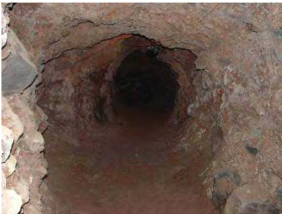
*Imagen 67. Túnel excavado en la piedra viva para acceder a los mantos freáticos de las laderas del cerro de Amatitán.*
