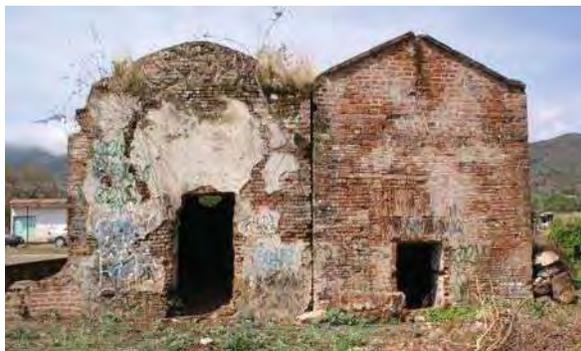
*Imagen 59. Al otro extremo del conjunto de hornos se ubican las bocas de descarga de agave cocido ubicados al nivel del suelo para facilitar el movimiento hacia la tabona de molienda.*
