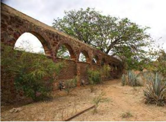
*Imagen 53. Acueducto para alimentación de agua a algunas destilerías ubicadas en las afueras de Amatitán.*
