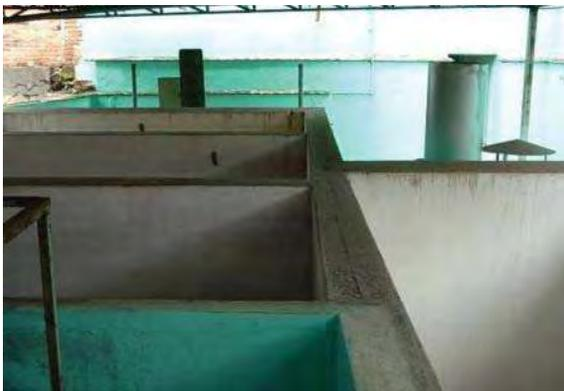
Imagen 166. Tinas de fermentación de mampostería en la destilería La Guarreña de Tequila.
