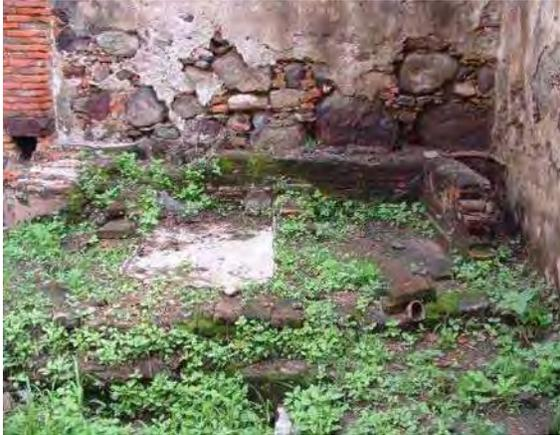
Imagen 38. Pilas de mampostería para captar el mosto que era llevado a las pipas de madera para la fermentación que se ubicaban en la nave.
