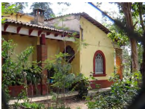
Figura 98. Detalle de fachada norte de la quinta San Ángel. Fotografía del autor (2016).
