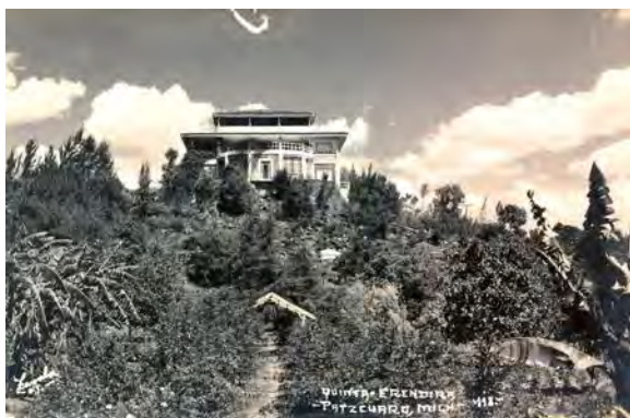
Figura 55. La quinta Eréndira en una de sus primeras etapas, de un lenguaje más moderno, fachada poniente. Zavala (ca.1930). Fuente: Colección privada Pablo Chico.
