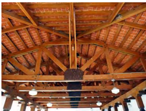
Figura 70. Parte de la estructura de la cubierta en madera del casino en Tres Reyes. Fotografía del autor (2016).
