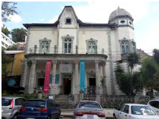
Figura 42. Ejemplo de casa de descanso en paseo de la Presa, Guanajuato. Fotografía del autor (2017).
