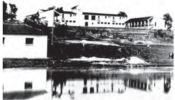
Figura 26. La inclusión de las cubiertas inclinadas de teja brindan al edificio una integración a su entorno a pesar de los claros lenguajes modernos en su diseño. Fuente: Alberto Le Duc, op.cit. , p. 18.
