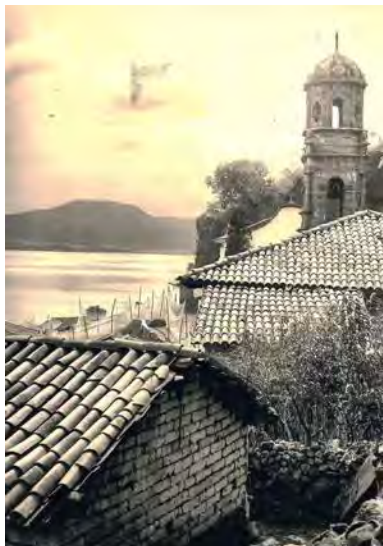
Figura 40. La utilización de cubiertas inclinadas de estructura de madera y teja de barro. Autor desconocido (ca.1930). Fuente: Colección privada Gerardo Díaz Chávez.
