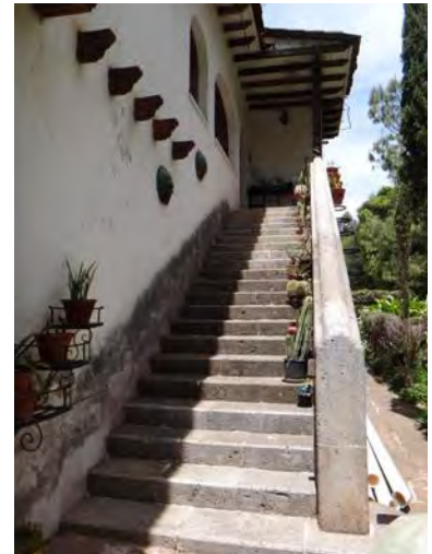
Figura 77. Vista de la escalera exterior de la vivienda. Fotografía del autor (2016).
