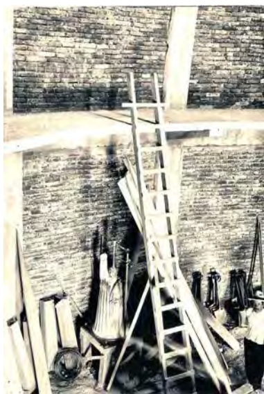
Figura 37. Interior del monumento a Morelos donde se observa la estructura de la construcción. Autor desconocido (ca.1934). Fuente: Colección fotográfica del Archivo Histórico de Pátzcuaro.
