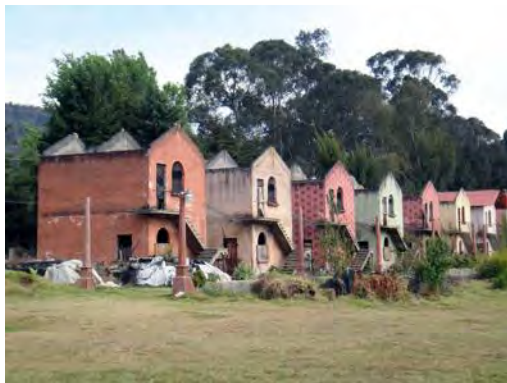
Figura 51. Viviendas dúplex en serie que fueron utilizadas para albergar a los militares que participaron en la construcción del monumento a Morelos en Janitzio. Fotografía del autor (2016).
