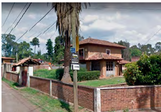
Figura 96. Vista suroeste de la quinta Rosa Elena, donde se observa una conservación óptima de la morfología original y reminiscencias de las típicas palmeras de las quintas. Google (2012), Fuente: Google Street View.
