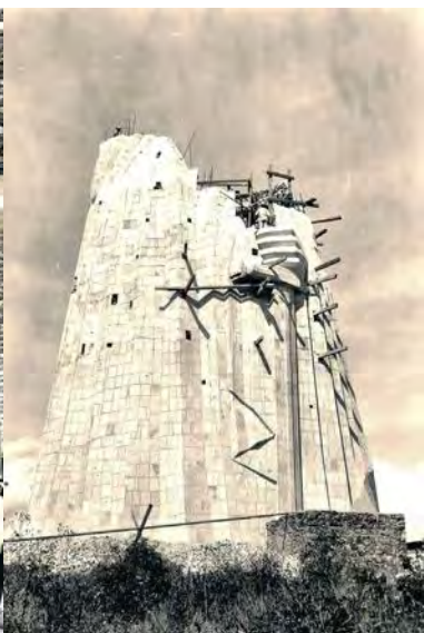
Figura 38. Avance en la construcción del monumento a Morelos en Janitzio. Autor desconocido (ca.1934). Fuente: Colección fotográfica del Archivo Histórico de Pátzcuaro.
