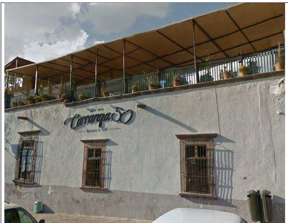
Imagen no. 11. Venustiano Carranza no. 50, barrio de la Santa Cruz, construcción de terraza sin contar con las autorizaciones correspondientes. Fotografía: Tania Padilla.
