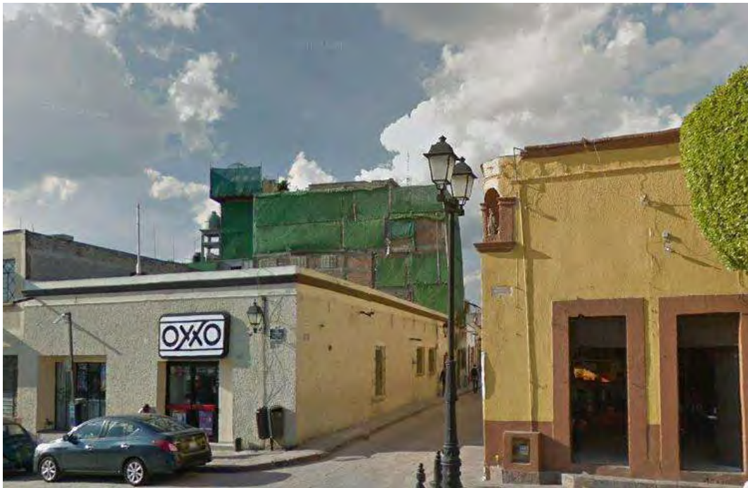
Imagen no. 12. Manuel Gutiérrez Nájera Sur no. 26, barrio de la Santa Cruz, construcción de departamentos suspendida por autoridades federales y municipales. Fotografía: Tania Padilla.
