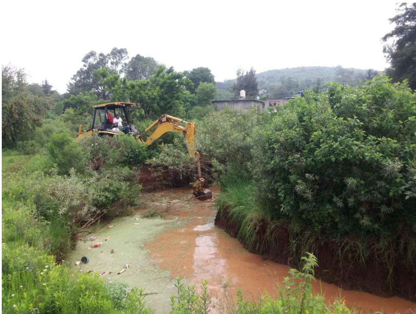
▲ Fotografía 147: Primera etapa de limpieza de las riveras y el cieno del arroyo mediante la Acción “Limpiando el arroyo Cuanajo” por parte del ayuntamiento de Lagunillas. Tomada el 28 de agosto del 2020. Fuente: Jorge Alberto Reyes Domínguez.
