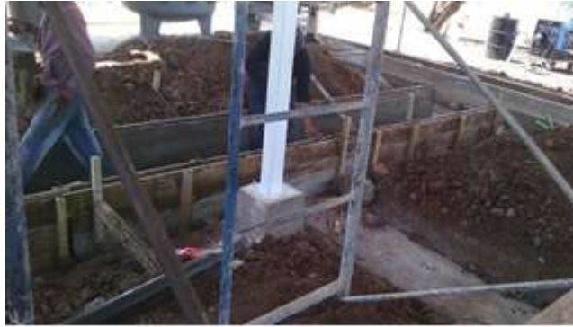
Figura 4.22: Trabajos de adecuación de la planta de poligeneración I (Proyecto Cemie-Geo P16).
