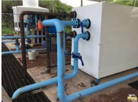
Figura 4.33: Acoplamiento de ORC con el circuito de agua de enfriamiento y agua caliente (Proyecto Cemie-Geo P16).
