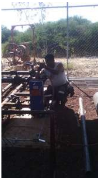
Figura 4.71: Adaptación de los medidores de temperatura y presión (Proyecto Cemie-Geo P16).
