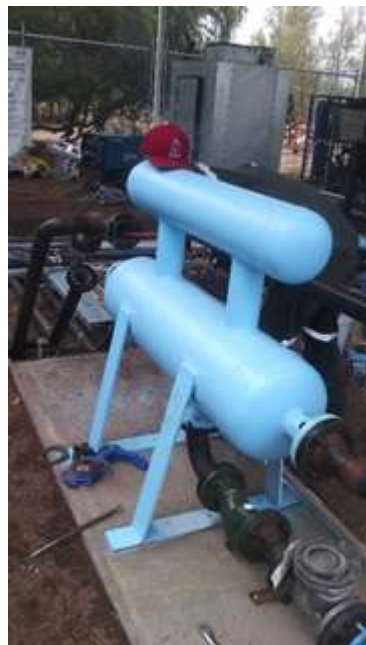
Figura 4.45: Cámara de mezclado en planta de poligeneración (Proyecto Cemie-Geo P16).
