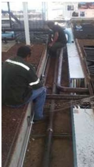
Figura 4.63: Interconexión de los registradores de presión y el módulo de control II (Proyecto Cemie-Geo P 16).
