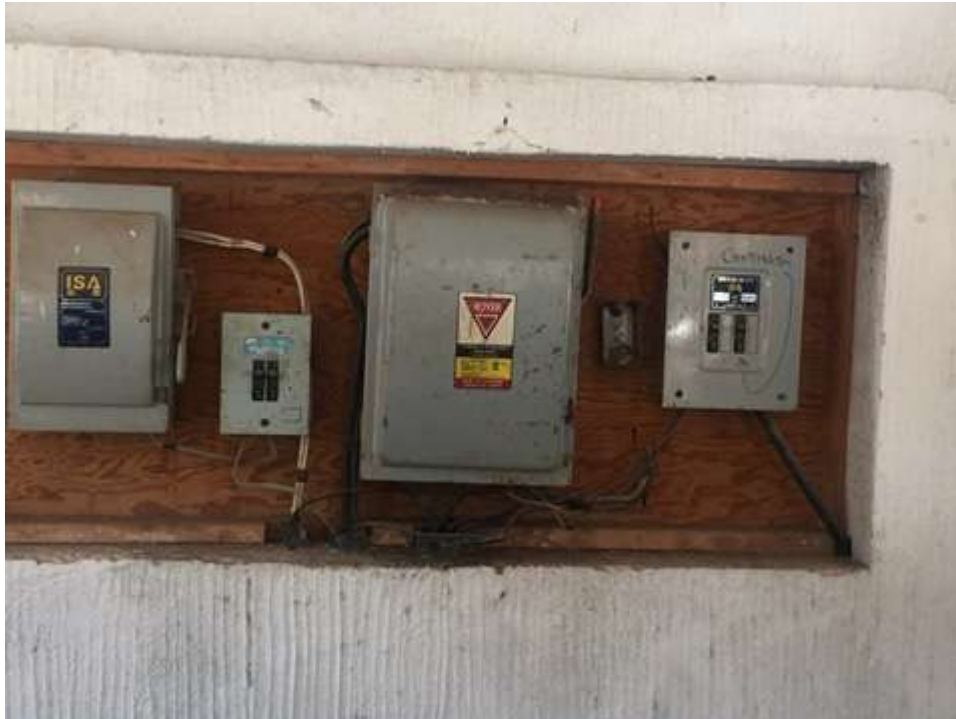
Figura 4.28: Centros de carga del suministro eléctrico al balneario de Ixtlán de los Hervores.
