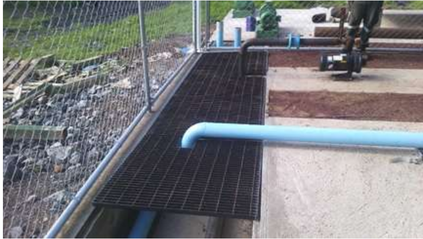
Figura 4.55: Acoplamiento de la bomba de alta temperatura (Proyecto Cemie-Geo P16).
