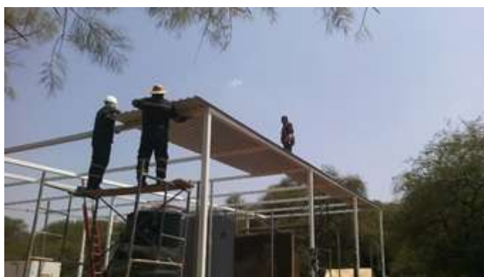
Figura 4.26: Trabajos de adecuación de la planta de poligeneración V (Proyecto Cemie-Geo P16).
