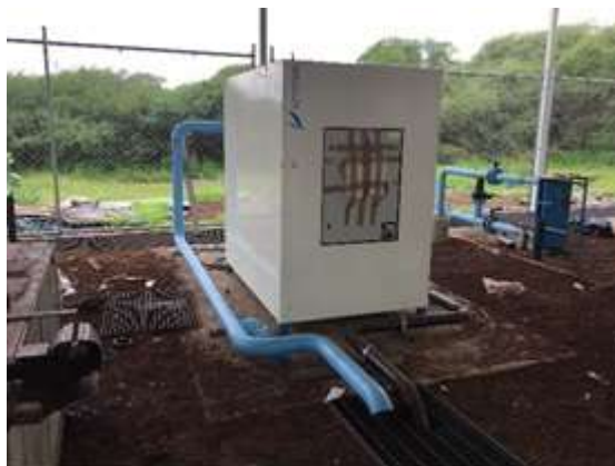
Figura 4.31: Montaje del ORC en cimentación (Proyecto Cemie-Geo P16).
