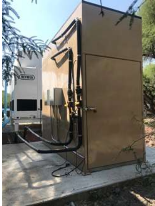
Figura 4.41: Montaje de deshidratador en planta de poligeneración (Proyecto Cemie-Geo P16).
