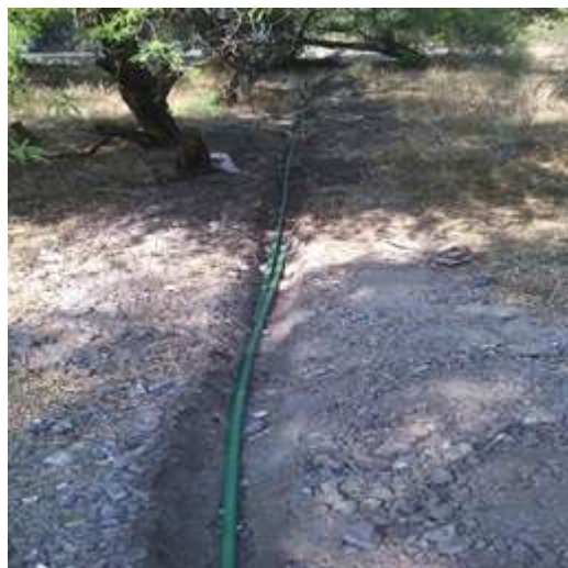
Figura 4.51: Suministro de agua de reposición en torre de refrigeración (Proyecto Cemie-Geo P16).
