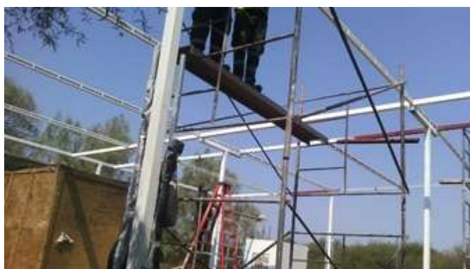
Figura 4.25: Trabajos de adecuación de la planta de poligeneración IV (Proyecto Cemie-Geo P16).
