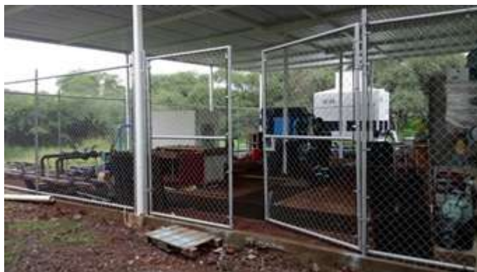
Figura 4.76: Montaje final de la planta de poligeneración I (Proyecto Cemie-Geo P16).
