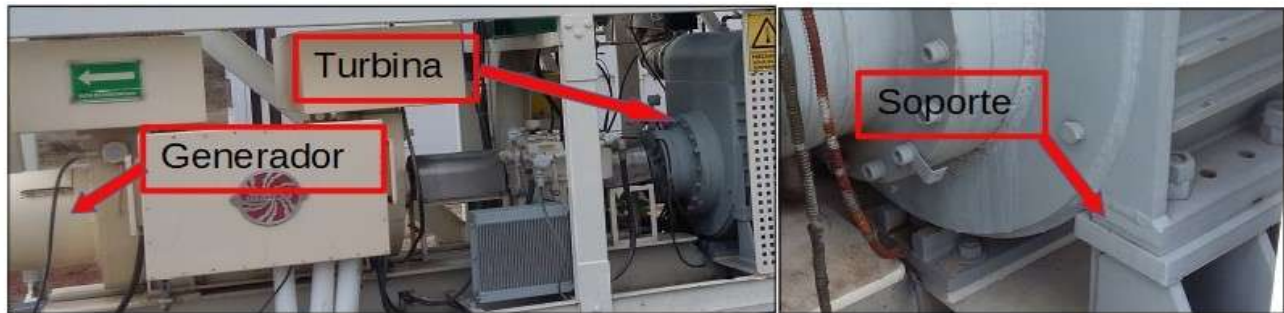
Figura 4.5 Conjunto de máquinas giratorias de 300Kw ancladas a cimentación rígida. Proyecto P29 en SIMIRAO Michoacán.
