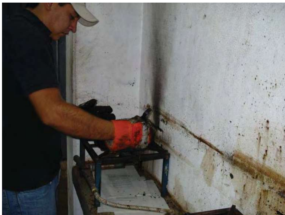
Mezclado en caliente de los materiales
