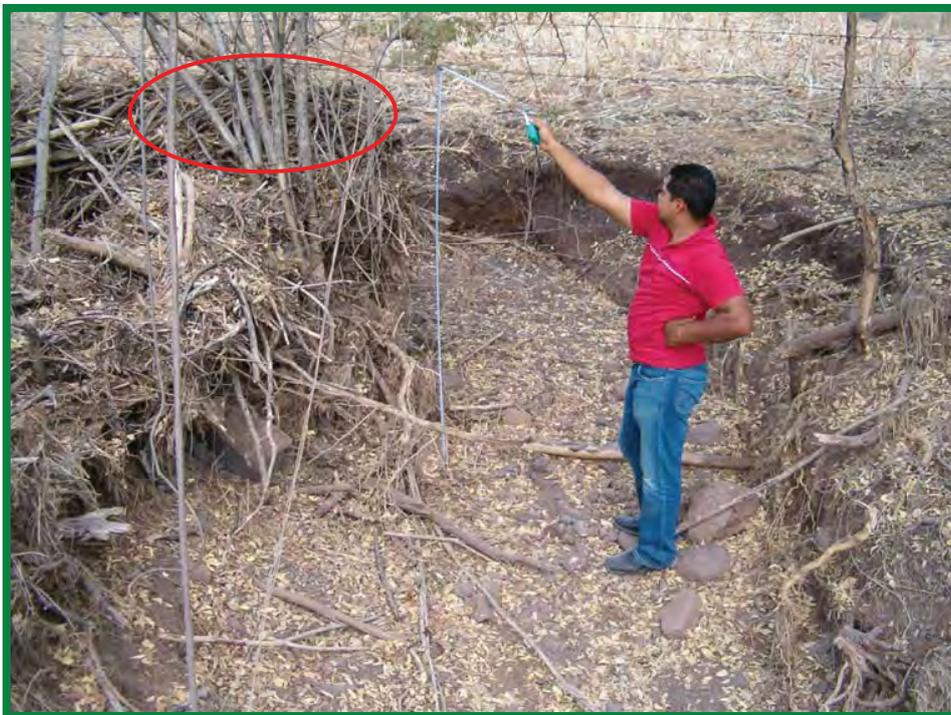
**Foto 5.4.1** Cruce hidráulico en donde se aprecia la cantidad de escombros arrastrados hacia el camino.
