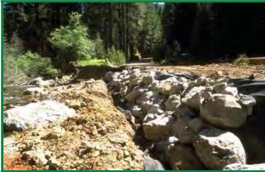
**Foto 4.4.8.1** *Enrocamiento de protección con respaldo de un filtro geotextil (Ingeniería de caminos rurales por Keller y Sherar, 2004).*
