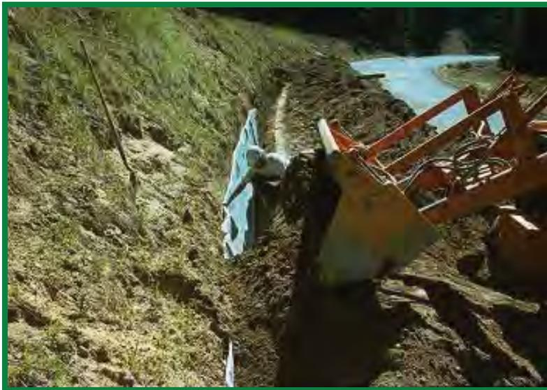
**Foto 4.4.7.1** *Uso de geotextiles colocados encima de suelos finos para proporcionar una filtración adecuada a un subdren. (Ingeniería de Caminos Rurales por Keller y Sherar, 2004).*
