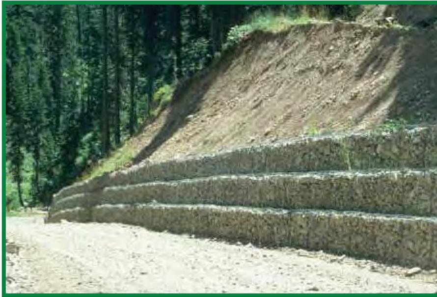
*Foto 4.5.2 Gaviones como estructuras de contención de baja altura tipo “de gravedad”. (Ingeniería de Caminos Rurales por Keller y Sherar, 2004).*
