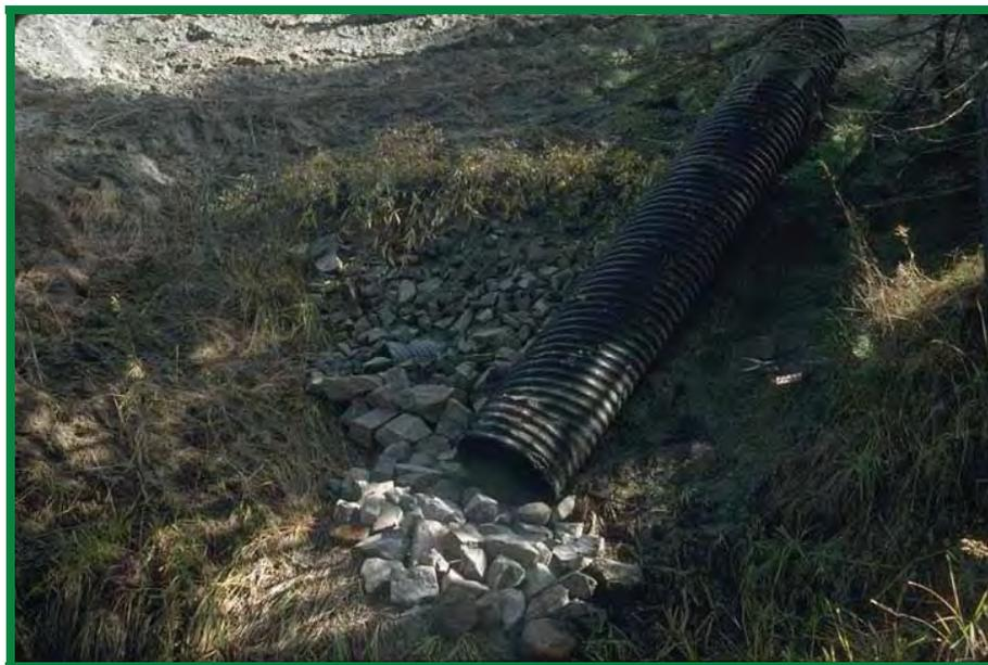
**Foto 4.4.3.2** Enrocamiento de protección contra la socavación (Ingeniería de Caminos Rurales por Keller y Sherar, 2004).
