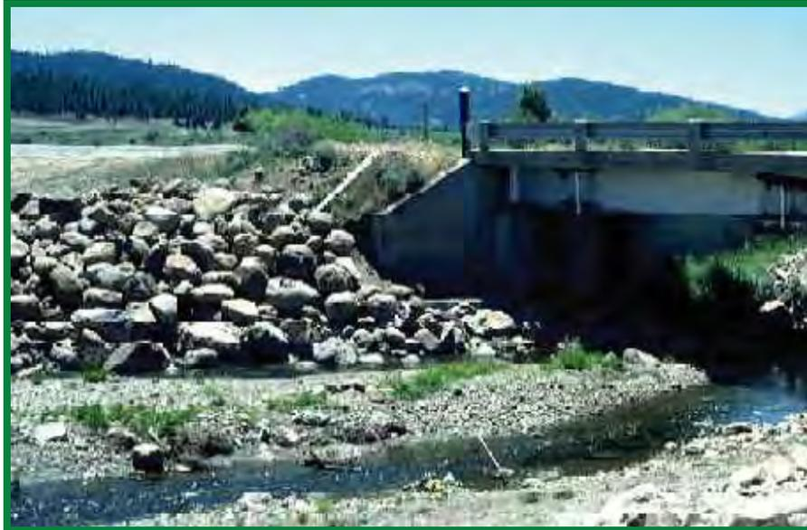
**Foto 4.4.6.1** *Enrocamiento de protección en estructura de concreto. (Ingeniería de Caminos Rurales por Keller y Sherar, 2004).*
