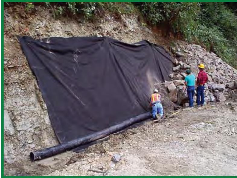
***Foto 4.4.7.2 Geotextil en un talud, hecho con roca suelta que se usa para proporcionar filtración, permitir la infiltración y evitar el desplazamiento del suelo fino hacia la roca (Foto de Richard Van Dyke).***
