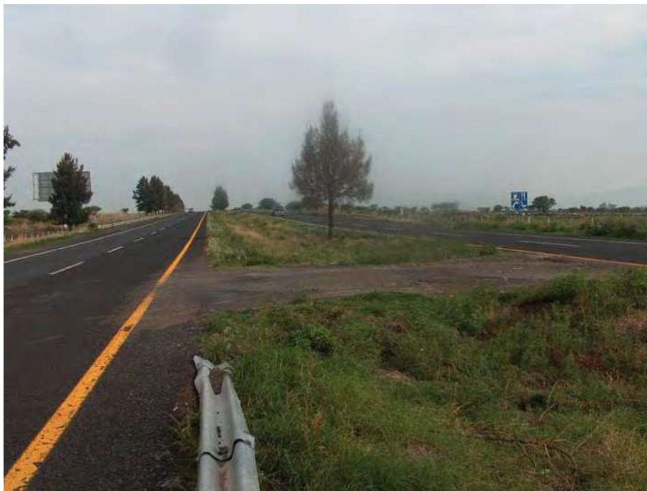
Figura 4.23 Vista hacia el km. 390+000 del retorno clandestino ubicado en el km. 390+900.
