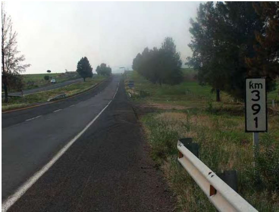
Figura 4.24 Vista del km. 391+000 hacia el km. 390+000
