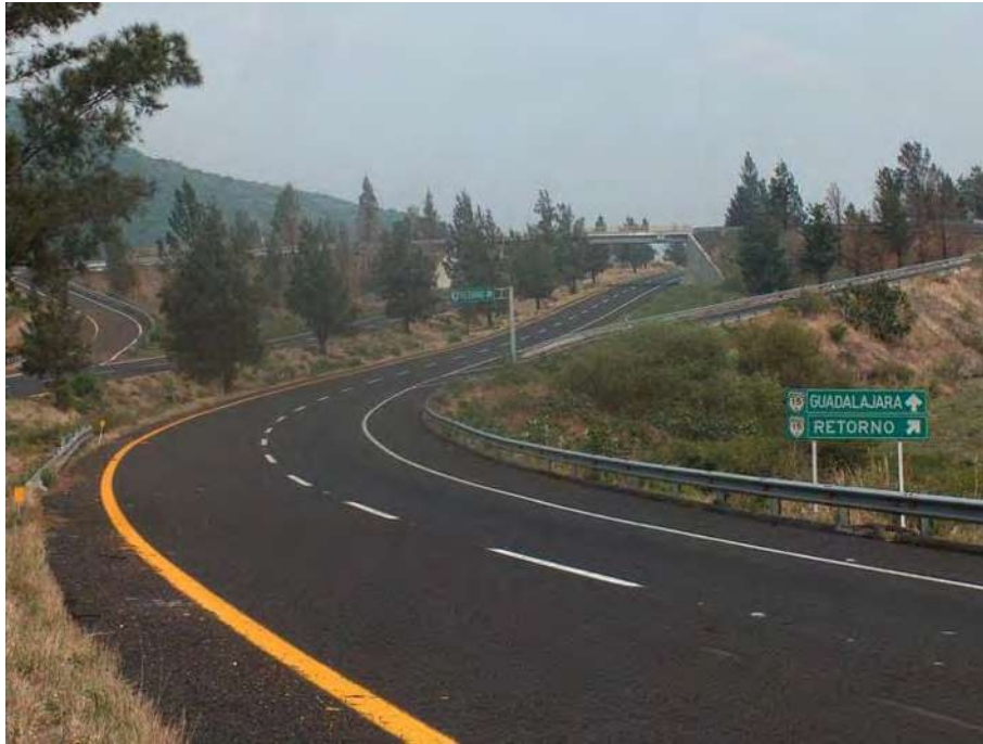
Figura 4.12 Vista del centro de la curva.
