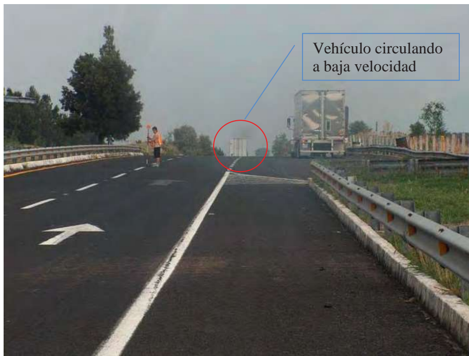
Figura 4.21 Vista del km. 390+100 hacia el km. 391+000, se observa la curva vertical.
