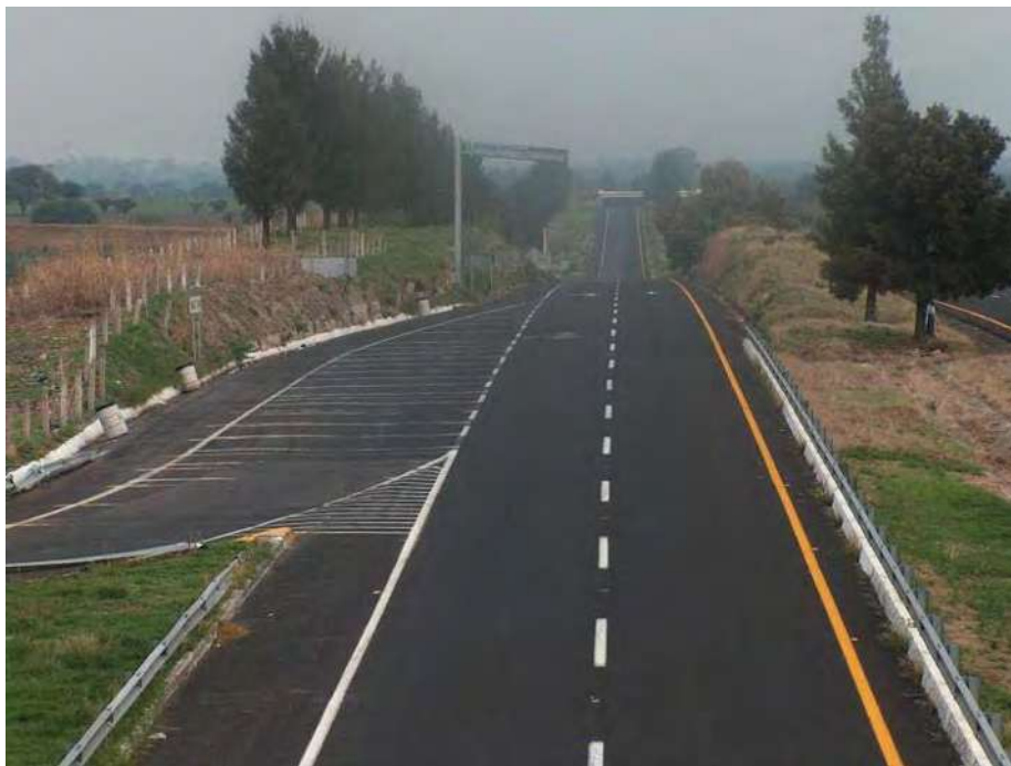
Figura 4.19 Vista del cuerpo izquierdo desde el PIV ubicado en el km. 390+000
