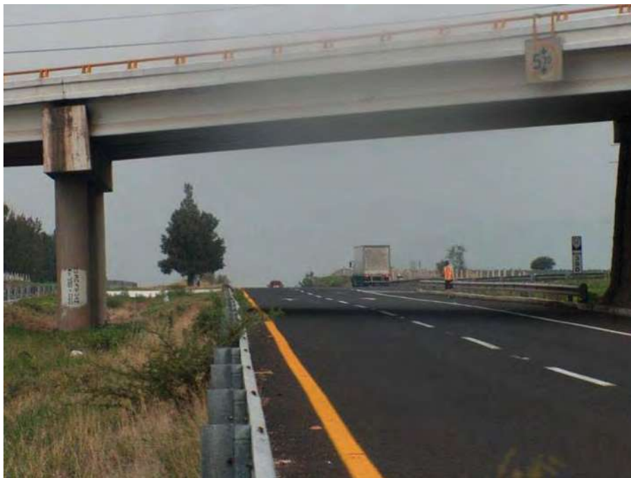
Figura 4.17 Vista del inicio del subtramo del km. 390+000 al km. 391+000
