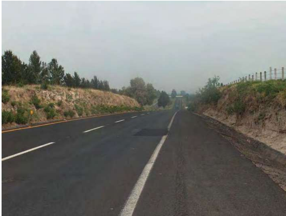
Figura 4.20 Vista del km. 390+300 hacia el km. 391+000
