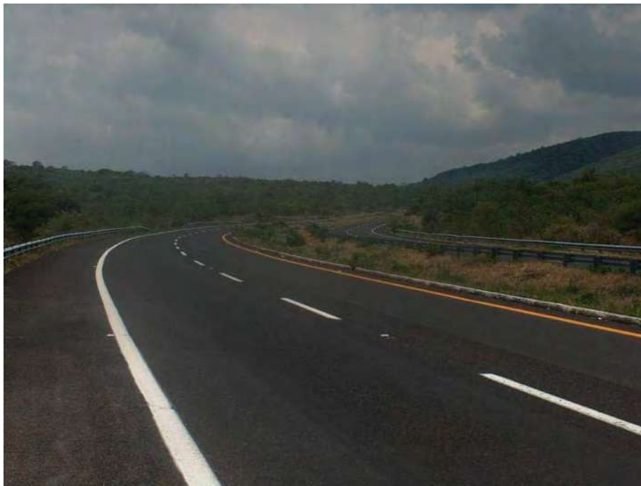
Figura 4.7 Vista del km. 268+000 hacia el km. 269+000.
