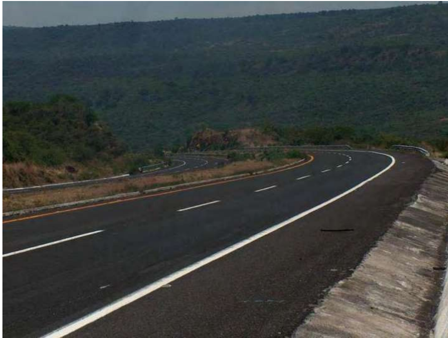
Figura 4.10 Vista del km. 268+400 hacia el km. 268+000
