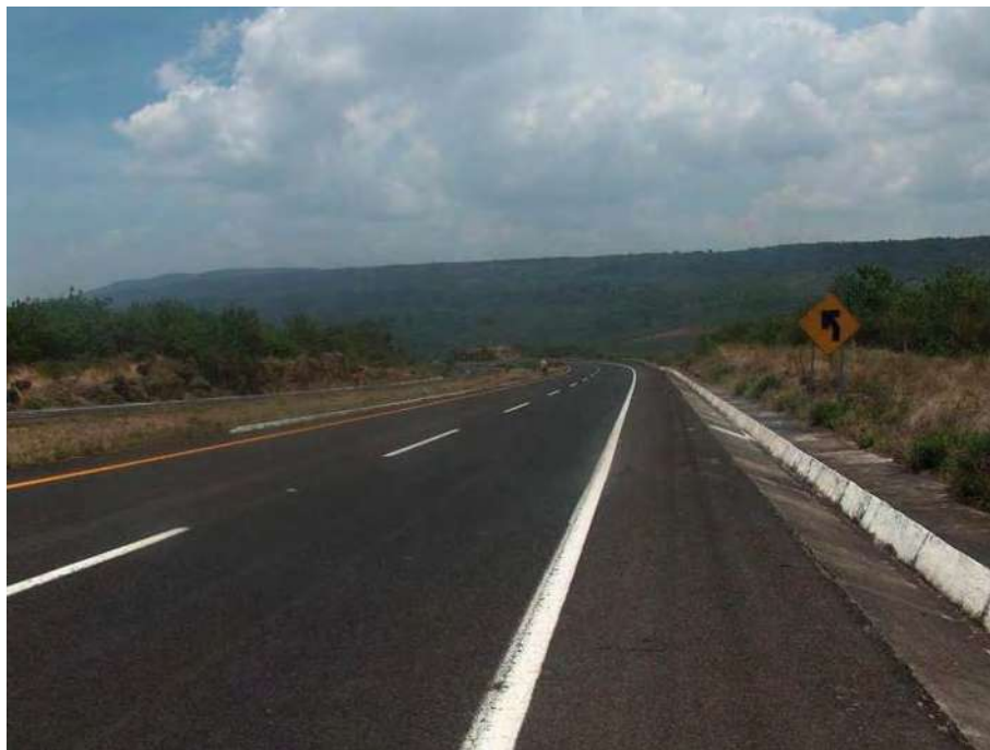
Figura 4.9 Vista general del km. 269+000, hacia el km. 268+000.
