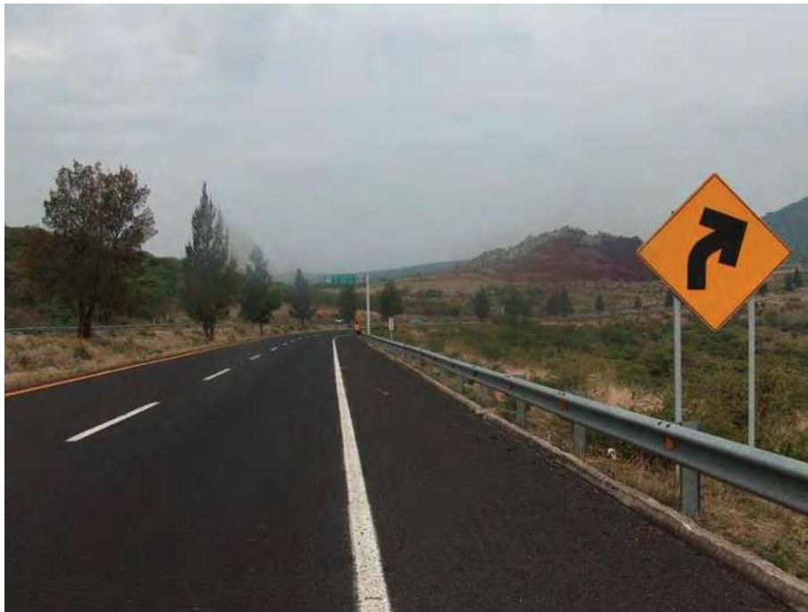
Figura 4.11 Inicio del subtramo, se observa el señalamiento existente.
