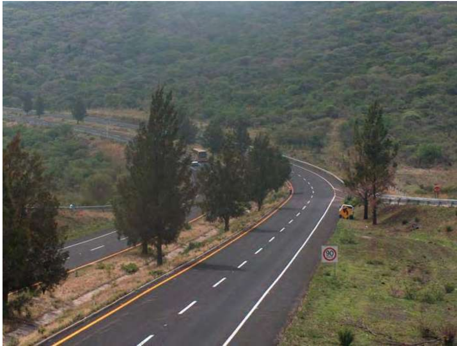
Figura 4.16 Vista del cuerpo izquierdo hacia el km. 377+000.
