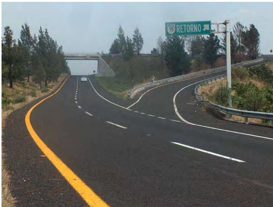
Figura 4.13 Salida hacia el retorno sin carril de cambio de velocidad.
