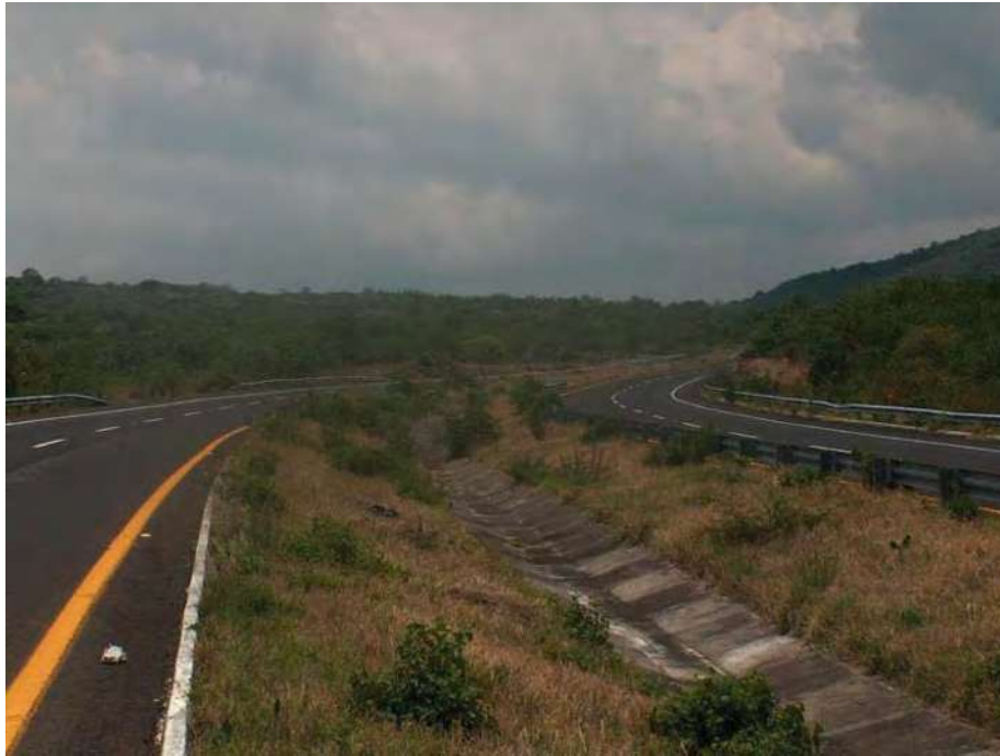
Figura 4.8 Vista general de la curva hacia el km. 269+000
