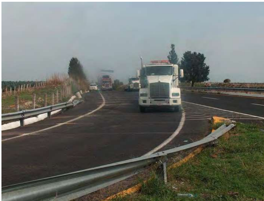
Figura 4.26 Vehículos que circulan por el enlace, efectuando una maniobra de desplazamiento al lado izquierdo para aumentar el radio de giro.
