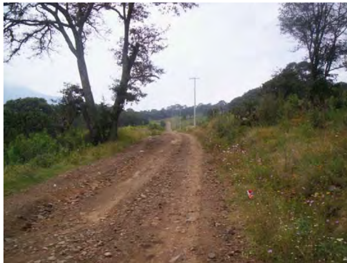
Imagen 4. Km 5+500 Camino Purépero – Caurio de Guadalupe
