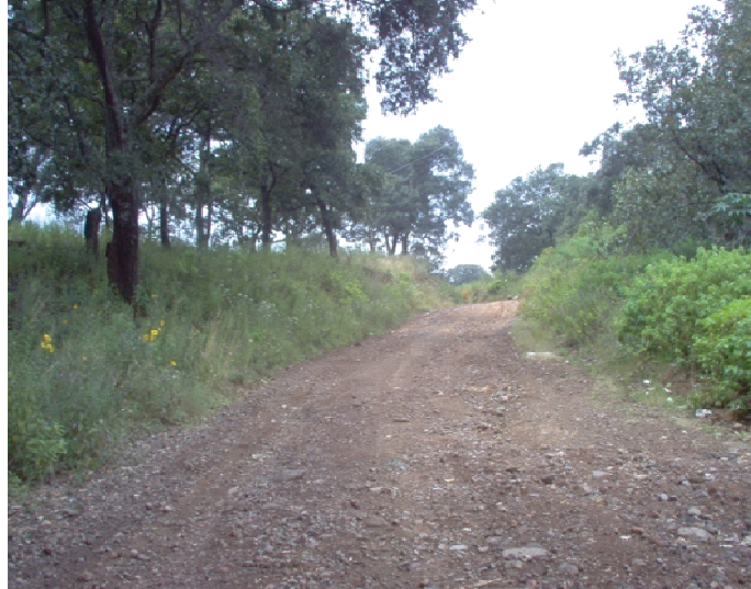
Imagen 3. Km 2+500 Camino Purépero – Caurio de Guadalupe
