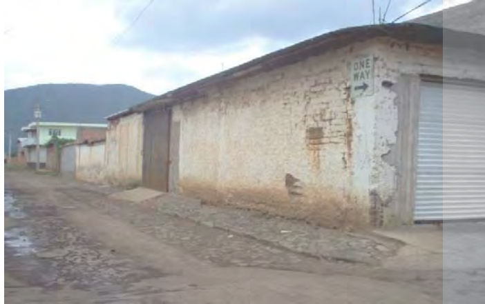
Imagen 1. Km 0+000 Camino Purépero – Caurio de Guadalupe
