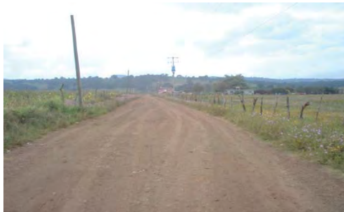
Imagen 2. Km 0+500 Camino Purépero – Caurio de Guadalupe
