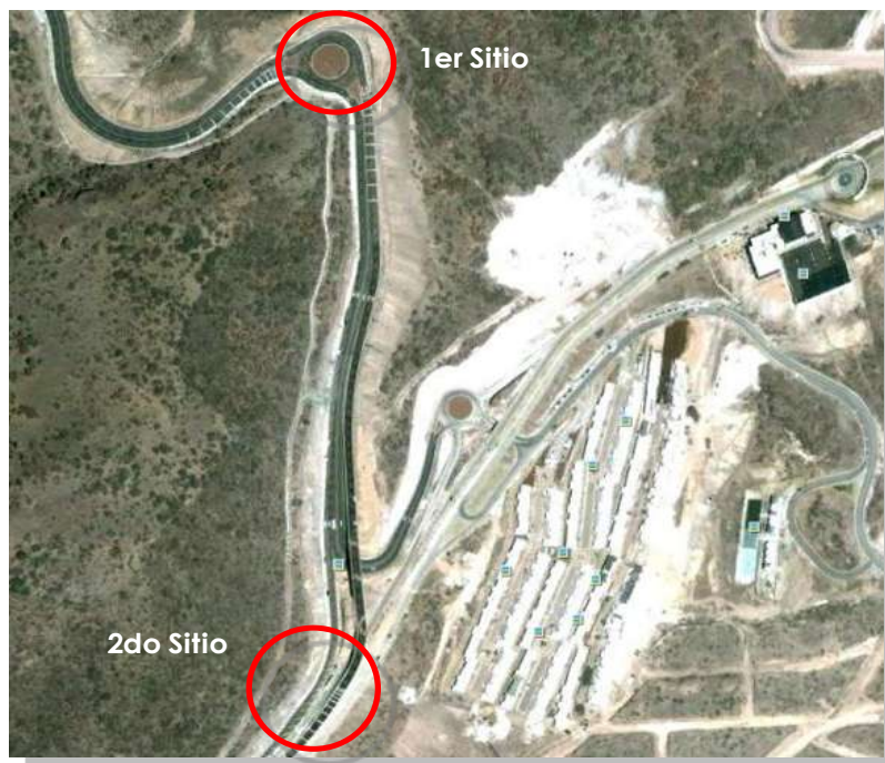
Figura No. 28.- Vista satelital de los accesos a la ciudad de Tres Marías donde se realizaron los muestreos. (Google Earth, 2010).
