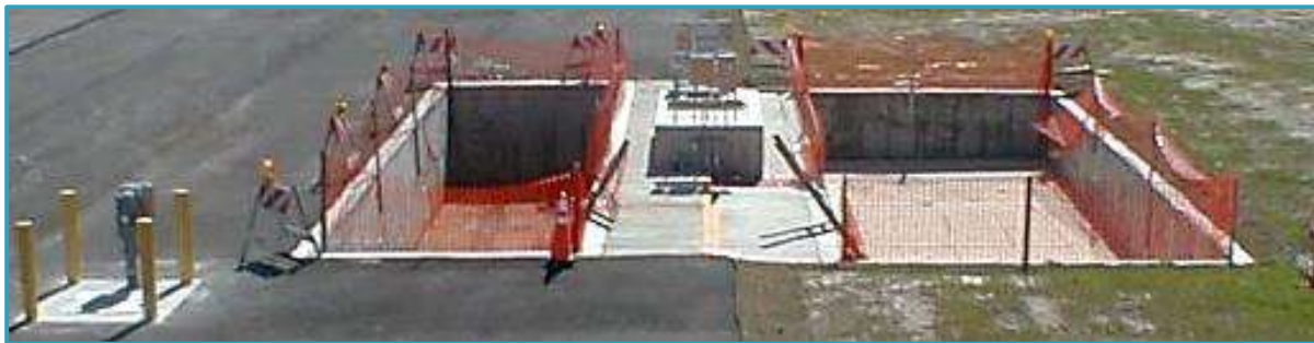
Figura 79 – Geometría de la zanja utilizada en la pista lineal FLORIDA DOT.
