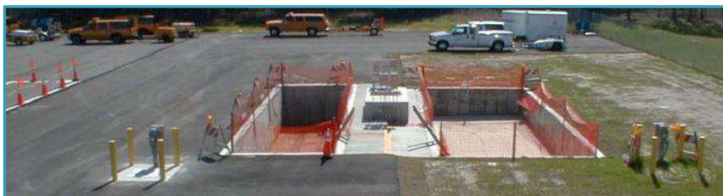
Figura 39 – Zanjas para sección de pavimento.
