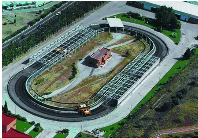
Figura 13 – Instalaciones de CEDEX (Tierra y Tecnología, 2013).
