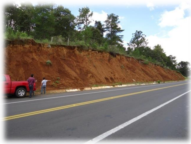
Figura 41 Talud de obtención del material en estudio en el km 65+000
