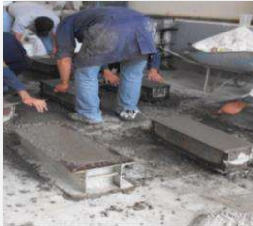
FIGURA 6.1.6.2.2 Llenado de los moldes prismáticos (Fuente J. A. Guzmán Torres)
