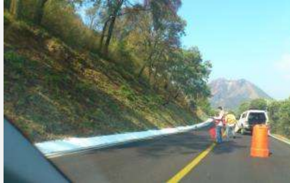
FIGURA 2.3.1 Pavimento flexible carretera Morelia-Quiroga Fuente J. A. Guzmán Torres
