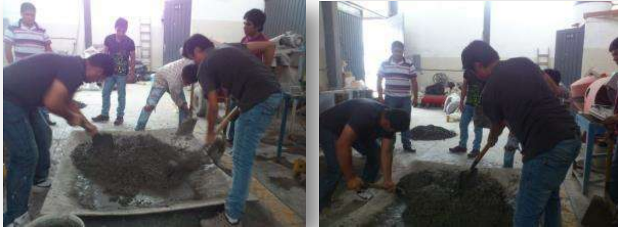
FIGURA 6.1.6.2.1 Elaboración de la mezcla a mano (Fuente J. A. Guzmán Torres)
