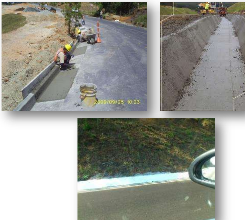
FIGURA 2.3.3 Obras de drenaje de concreto “cunetas” Fuente J. A. Guzmán Torres
