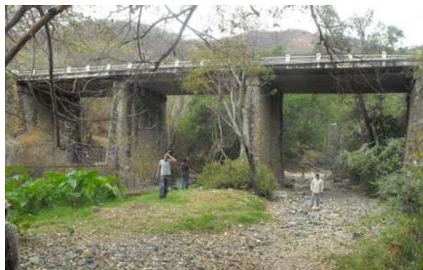
Imagen II-6.- Puente Plaza de Gallos (Estado de México).
