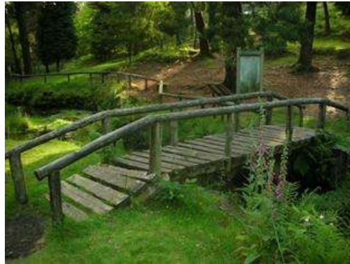
Imagen II-5.- Puente de madera.
