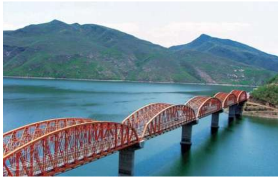
Imagen II-7.- Puente de Infiernillo (Michoacán, México).
