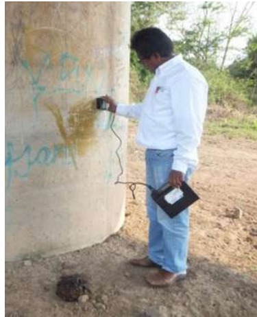
Imagen VII-1.- Ubicación del acero con el pacómetro en las pilas.
