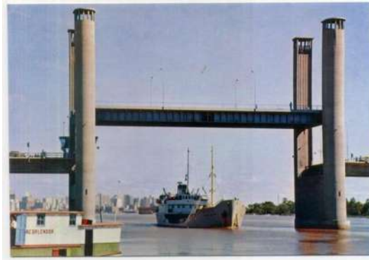
Imagen II-16.- Puente de elevación vertical.
