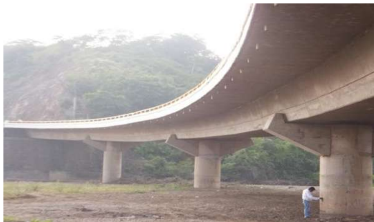
Imagen VI-3.- Vista del puente La Manzanilla
