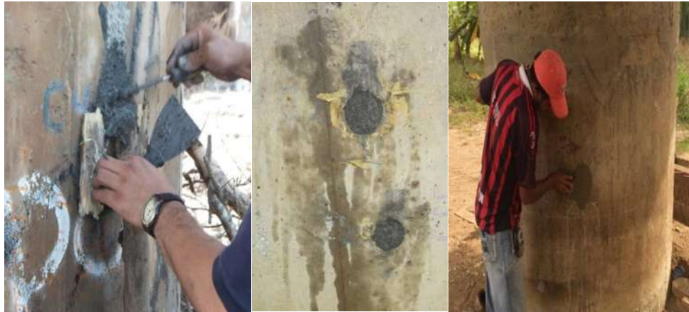
Imagen VII-4.-Proceso de resane de las extracciones de los núcleos de concreto
