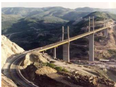
Imagen II-2. Vista general del puente Mezcala.
