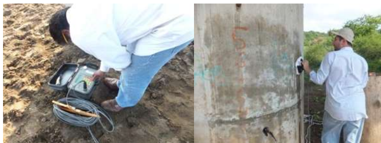
Imagen VIII-1.-Pruebas con el Gecor 6 en el puente la Manzanilla I
