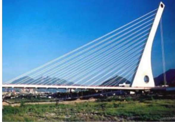
Imagen II-12.- Viaducto la unidad, Monterrey, NL.
