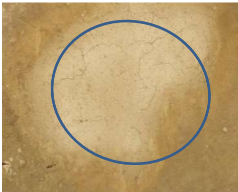
Imagen VI-9.- Reparación agrietada.
