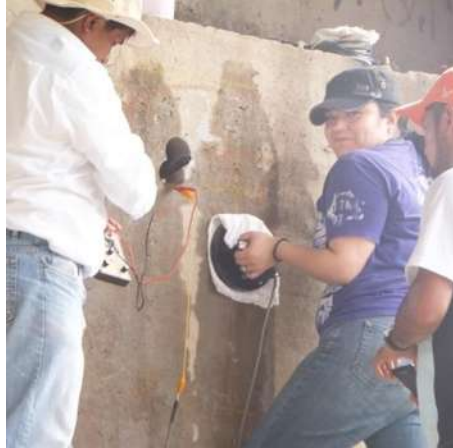
Imagen VII-16.-Pruebas electroquímicas en el puente la Manzanilla I
