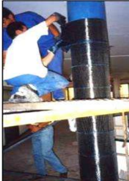
Imagen V-11.-Colocación de hojas preimpregnadas.
