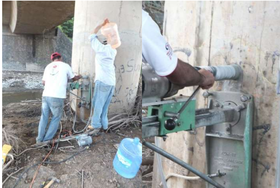
Imagen VII-2.- proceso de extracción de núcleos de concreto en el puente La Manzanilla I
