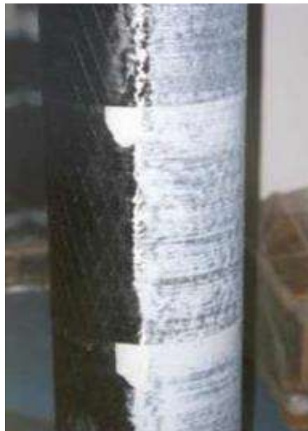
Imagen V-12.-Imprimación con epóxico.
