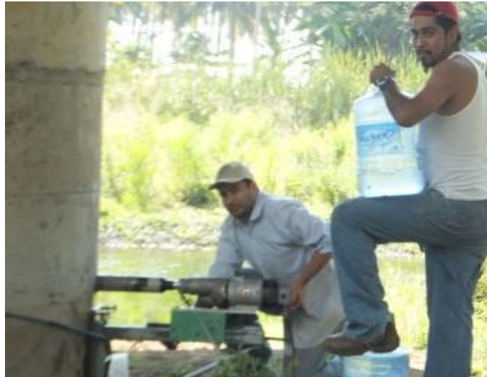
Imagen 22. Extracción de concreto endurecido.
