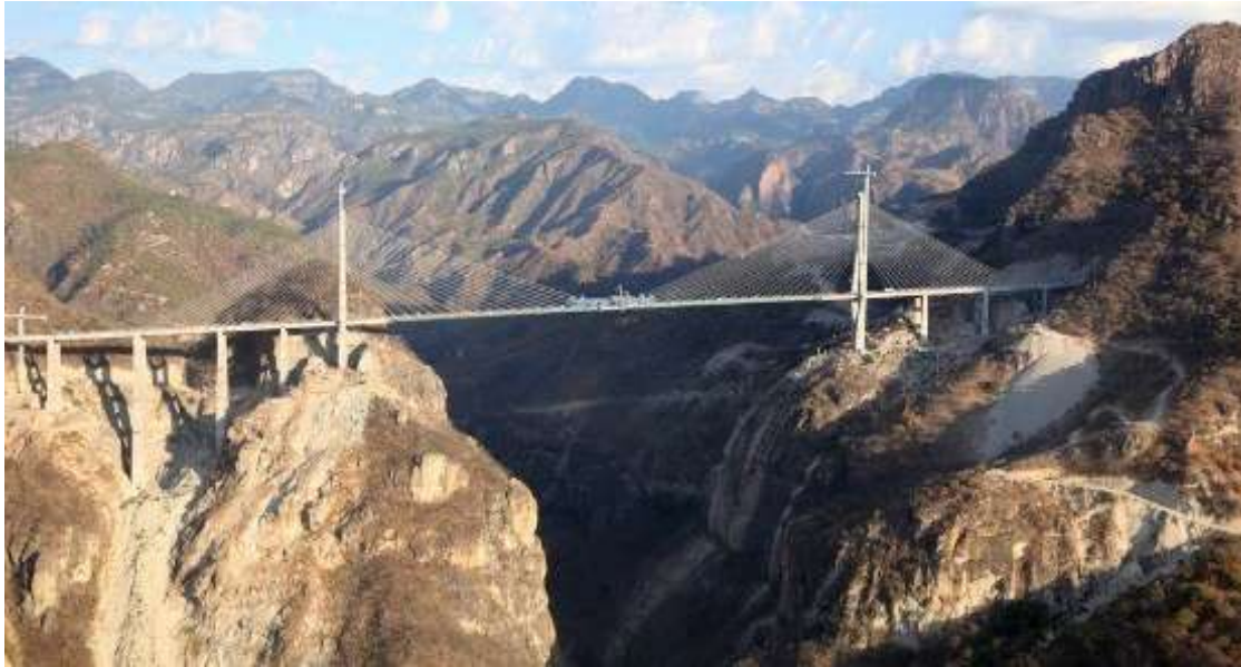
Imagen 8. Puente Baluarte Bicentenario, Durango-Sinaloa, México.
