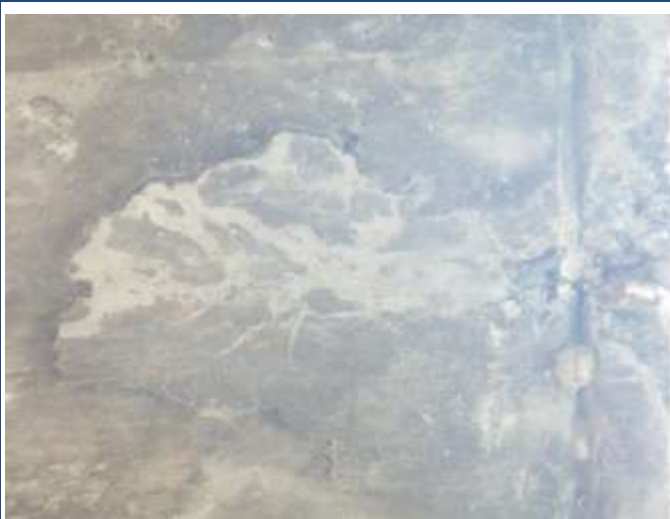
Delaminación (40 x 40 cm) localizada en la orilla del alero izquierdo, entre los 20 y 25 m.
