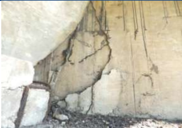
Delaminación (100 x 80 cm) de la parte inferior derecha del estribo (cerca de la base de la trabe).
