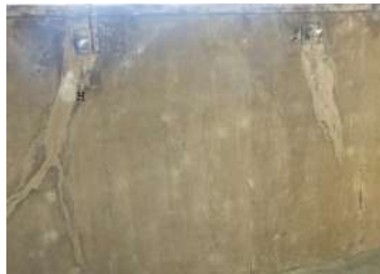
Lixiviación (100 x 20, 80 x 20 cm) con acero expuesto ubicada entre los 5 y 10 m.
