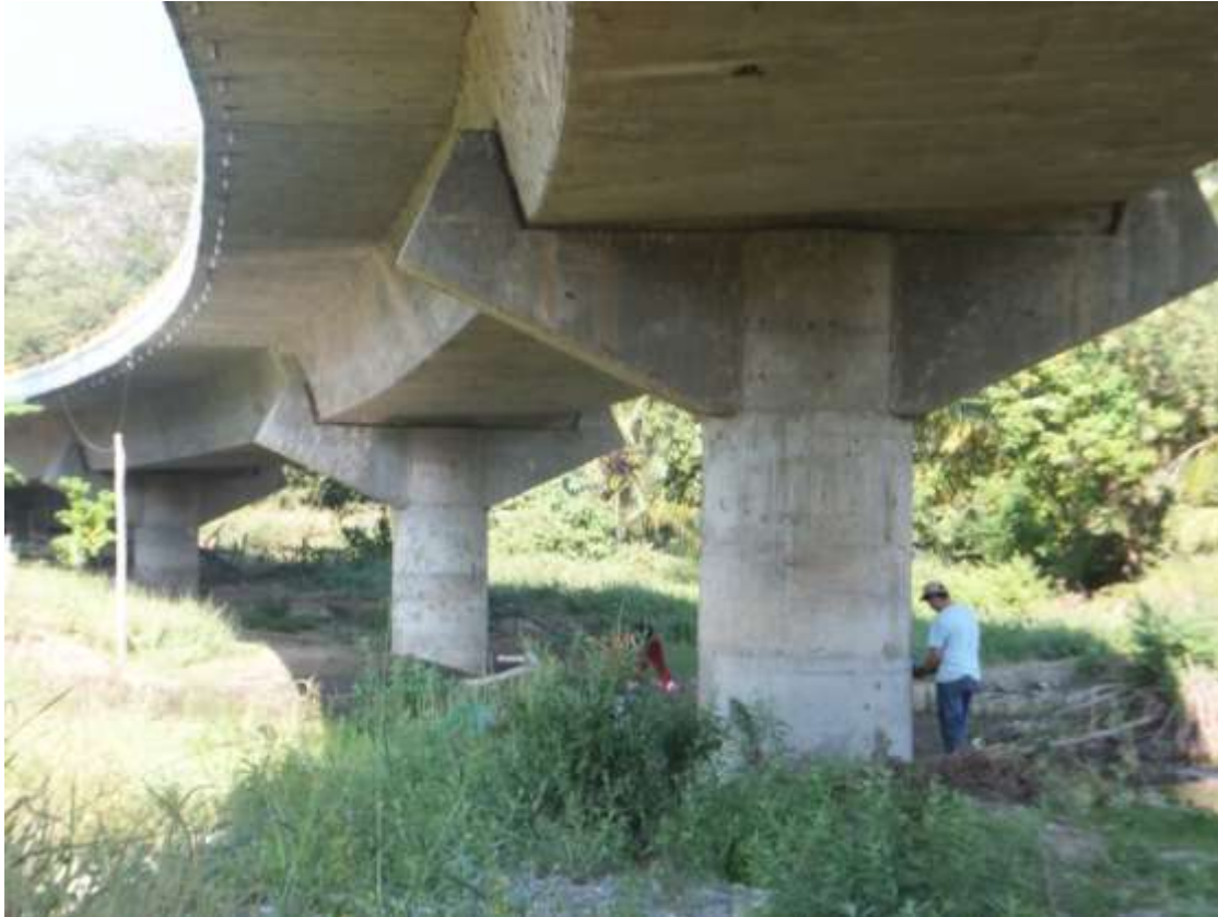
Imagen 1. Aspecto general del puente, 4 columnas, 5 claros, 166m de longitud, 11m de ancho y 38 años de antigüedad.
