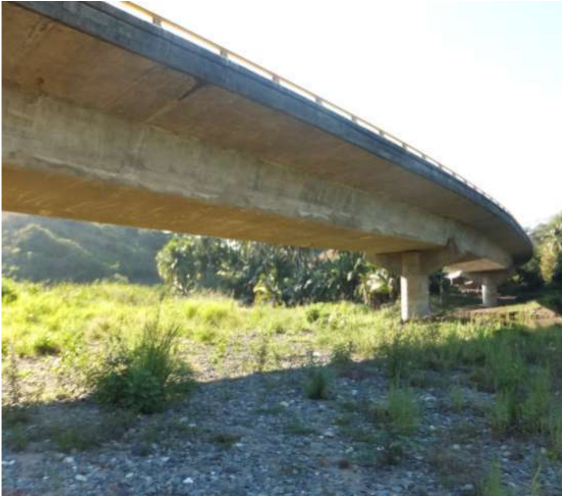
Aspecto del alero frente a tierra correspondiente al claro II.
