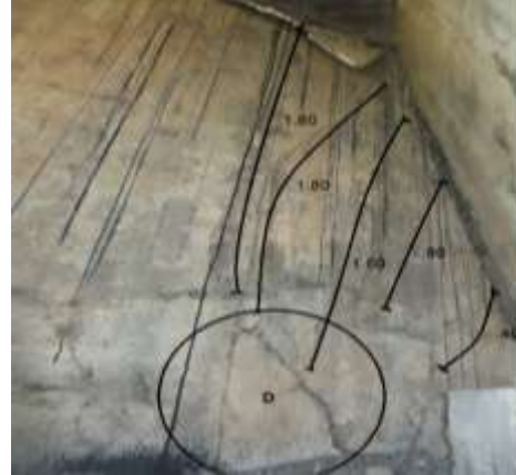
Grietas y delaminación (50 x 30 cm) ubicadas en la parte superior izquierda del estribo (cerca de la trabe y la losa).
