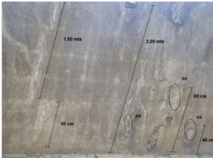
Lixiviación (150 x 20, 50 x 15, 200 x 20, 80 x 20, 40 x 20 cm) y manchas de óxido (20 x 20, 40 x 15, 40 x 20 cm) ubicadas en el alero izquierdo, entre los 20 y 25 m.
