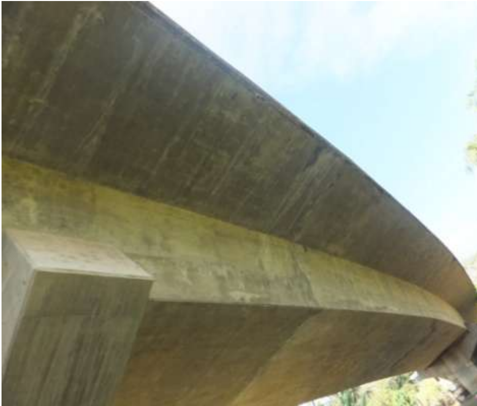
Aspecto del alero frente a tierra correspondiente al claro IV.
