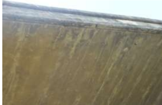
Entre los 5 y 10 m se ubican manchas de humedad (4 de 150 x 40 cm). Por escurrimiento.
