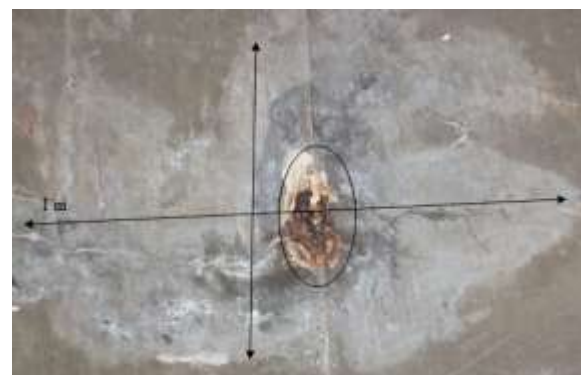
Entre los 10 y 15 m se ubica una lixiviación (100 x 80 cm) y óxido (30 x 30 cm) con acero expuesto.
