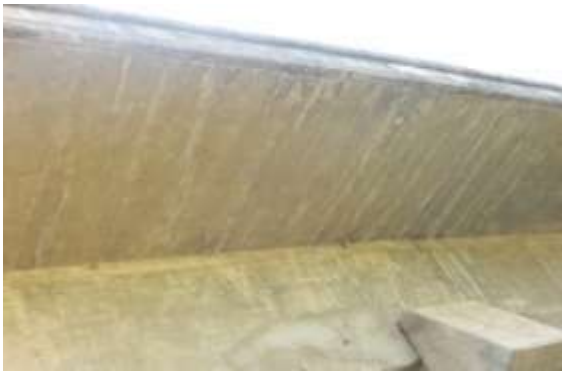
Manchas de humedad (6 de 200 x 20 cm). Por escurrimiento entre los 5 y 10 m.
