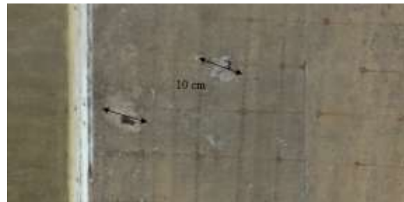
Entre los 10 y 15 m se ubica acero expuesto y manchas de humedad (10 x 10, 10 x 10 cm)
