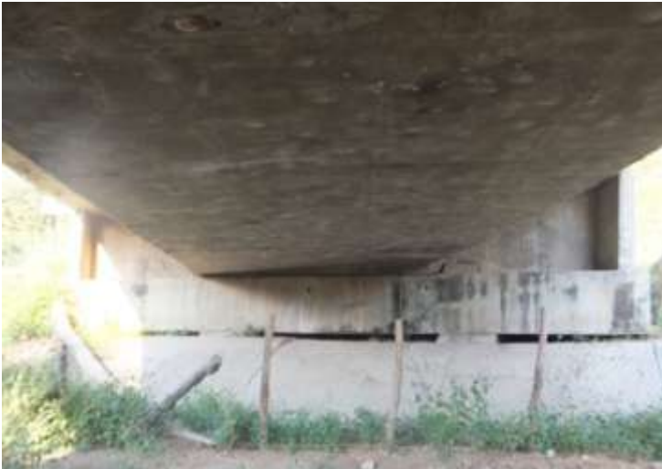
Aspecto del estribo 2.
