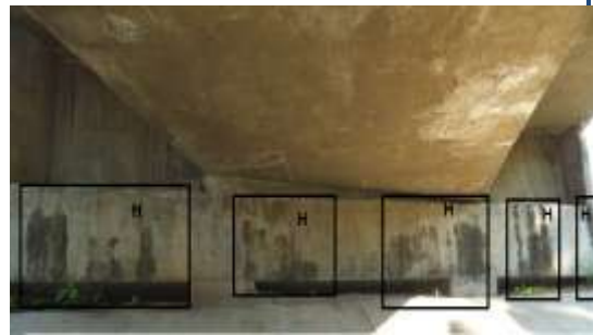
Grietas y delaminación (50 x 30 cm) ubicadas en la parte superior izquierda del estribo (cerca de la trabe y la losa).
