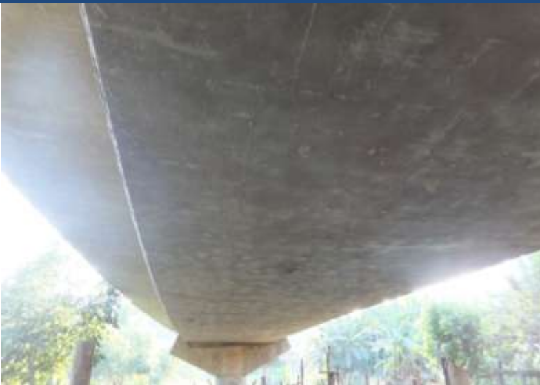
Manchas de lixiviación (100 x 100 cm) y grietas, ubicadas entre los 15 y 20 m.
