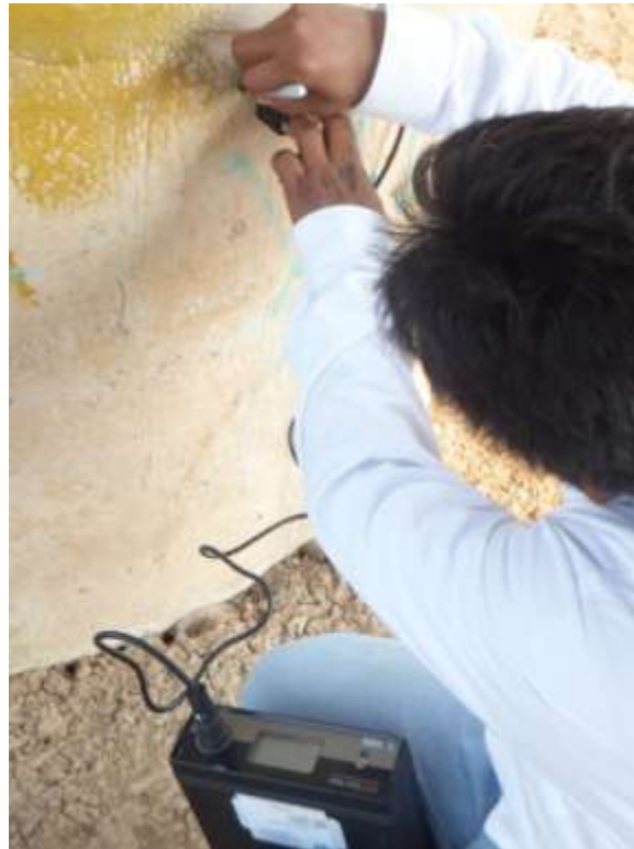
Imagen 19. Localización del acero estructural.
