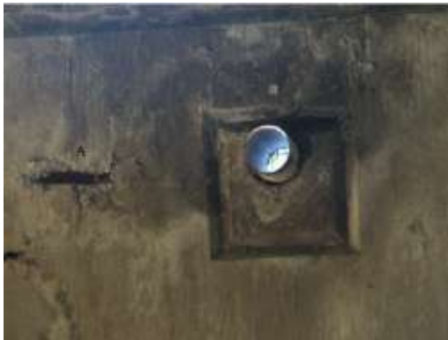
Desprendimiento (30 x 20 cm) con acero expuesto y delaminación (30 x 30 cm) ubicada entre los 5 y 10 m.
