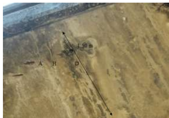
Manchas de humedad (150 x 40 cm) y acero expuesto, por escurrimiento ubicados entre los 5 y 10 m.
