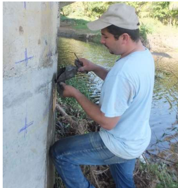
Imagen 23. Reparación del hueco producto de la extracción.
