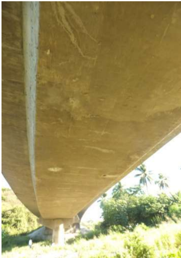
Manchas de lixiviación (185 x 30, 110 x 15 cm) con grietas ubicadas entre los 25 y 30 m.
