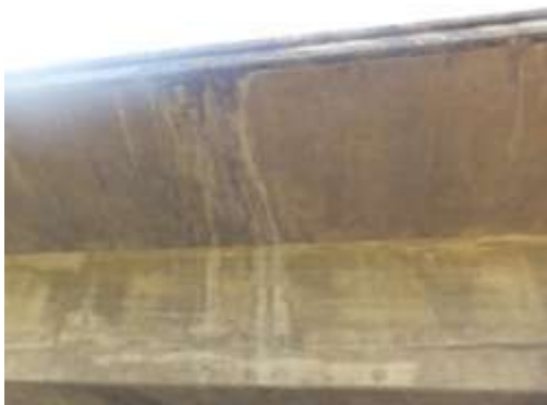
Mancha de humedad de 300 x 100 cm. Por escurrimiento, ubicada entre los 25 y 30 m.
