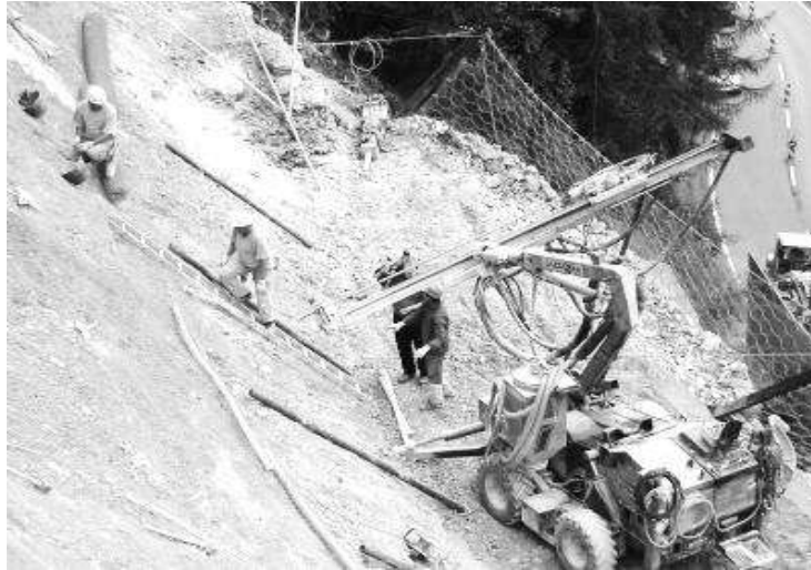
Figura 4.35.- Colocación de malla triple torsión anclada con bulones (Geobrugg).
