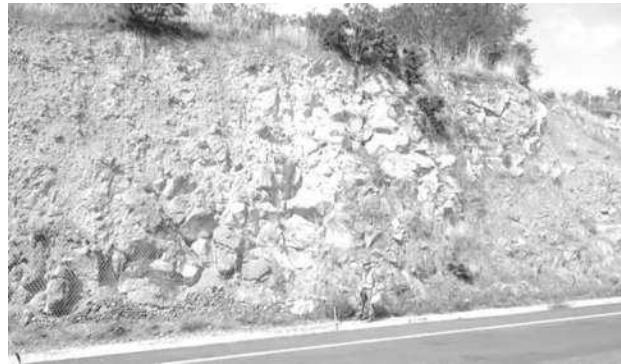
Figura 5.14.- Clasificación visual de los diferentes materiales como son roca y brecha volcánica que componen el lado izquierdo del talud ubicado en km 237+000 de la autopista México – Guadalajara.
