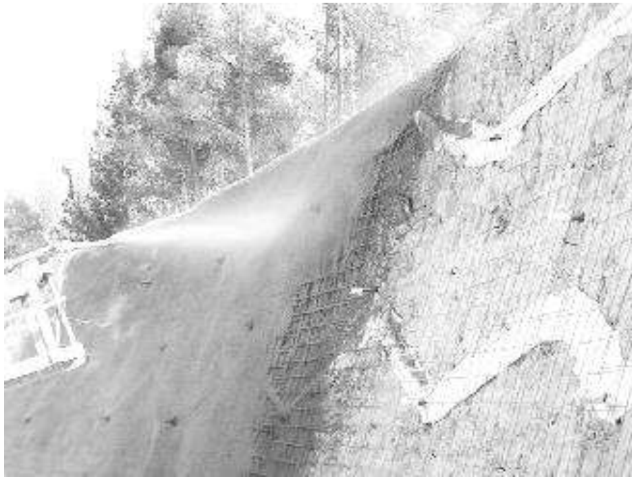
Figura 4.34.- Gunitado de taludes (Geobrugg).
