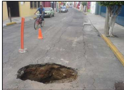
Figura 1 Falla y deformación permanente en un pavimento reconstruido con una arena limosa (SM).
