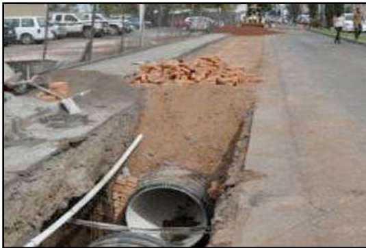
Figura 2 Utilización del material SM como base.
