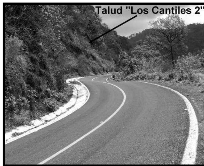
Figura 6.24.- Trazo carretero en la zona del talud “Los Cantiles 2”.
