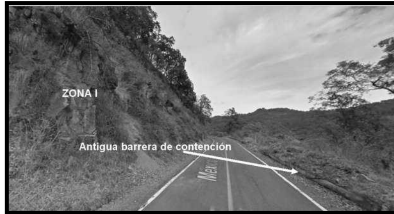
Figura 6.49.- Panorámica del talud “Los Cantiles 2”.
