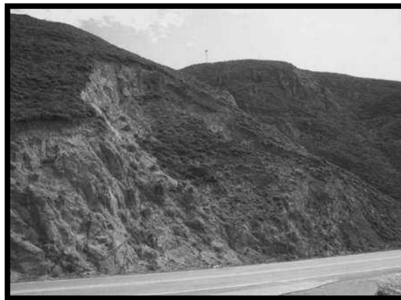
Figura 2.19.- Rotura circular en talud de roca granítica altamente erosionada, ubicado en la autopista 1, cerca del deslizamiento del diablo, Pacifica, California (Hoek & Bray, 1981).
