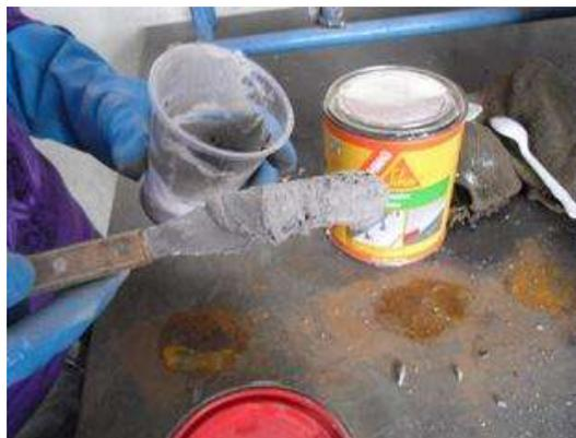
*Ilustración 41 Elaboración de la mezcla del epóxico.*
