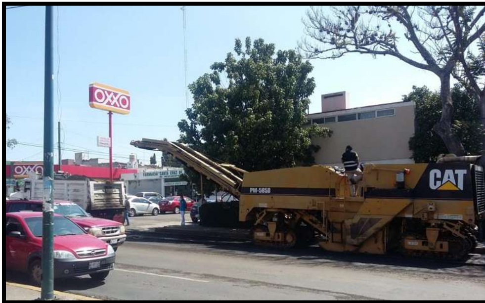
Figura 2.1. Máquina recuperadora de pavimento asfáltico, Av. Ventura Puente.
