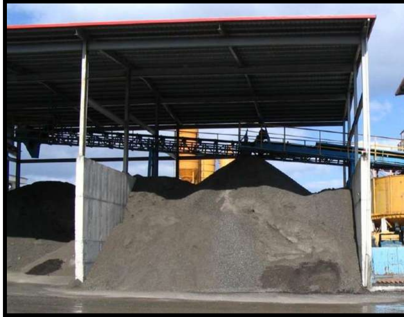
Figura 2.6. Acopio cubierto con una estructura para impedir el acceso del agua a través de la lluvia.
