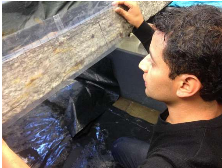
Figura 4.7. Medición de longitud de grietas.
