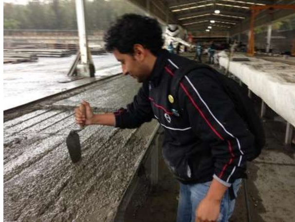
Figura 4.2. Colado de las vigas utilizadas en esta investigación.
