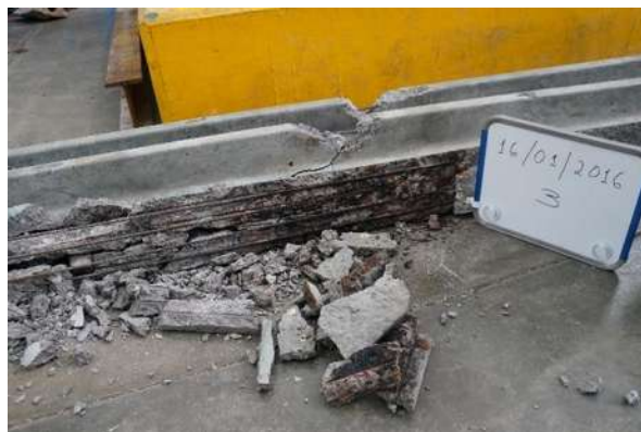
Figura 5.6. Remoción del concreto para caracterización del acero.
