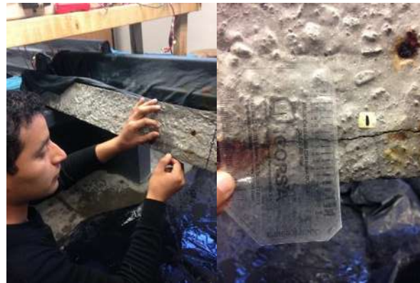
Figura 5.2. Medición de anchos de grieta.
