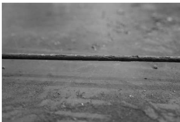
Figura 6.8. Estado de varilla extraída después de haber llevado a cabo la prueba de tensión.
