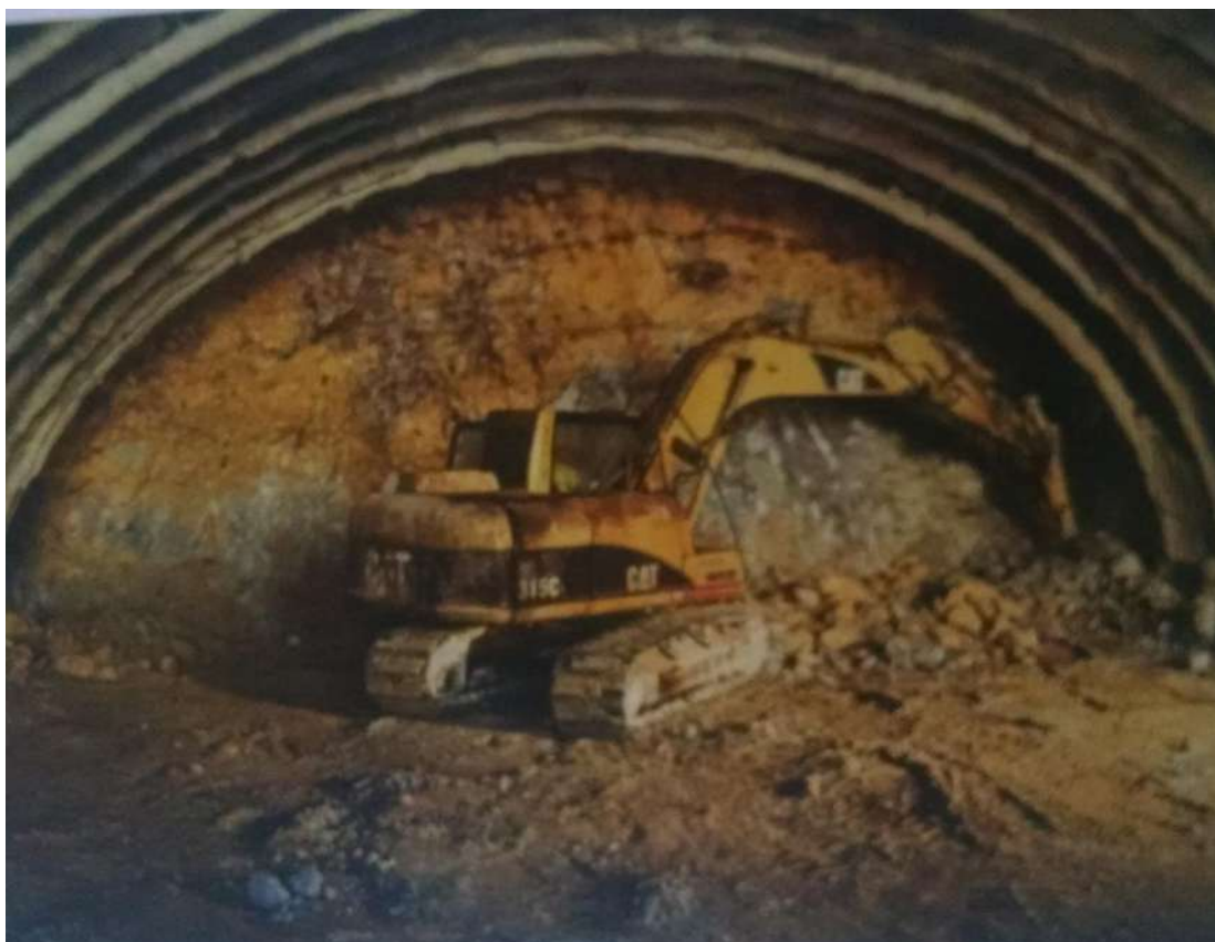
Figura 2.13.- Técnica modernas en la construcción de túneles en la autopista Durango – Mazatlán. Frente de excavación del túnel Piedra Colorada, ademada con perfiles metálicos TH (AMITOS, 2012).
