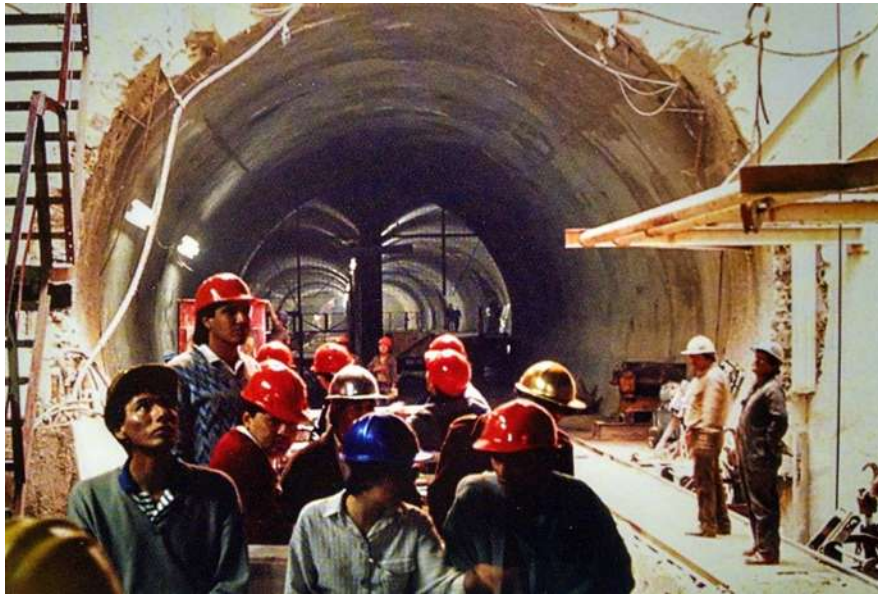
Figura 2.12.- Construcción de una estación en la Línea 7 del Metro. Portal de salida de túneles paralelos (AMITOS, 2012).
