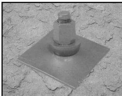
Figura 3.6.- Ancla de Tensión (Kolymbas, 2008).
