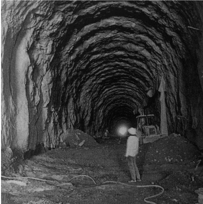
Figura 2.11.- Túnel de conducción de la hidroeléctrica Zimapán (AMITOS, 2012).
