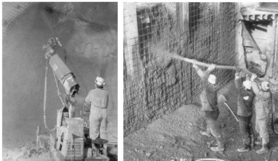
Figura 3.5.- Concreto rociado – Modo Mezcla Húmeda. (Kolymbas, 2008)
