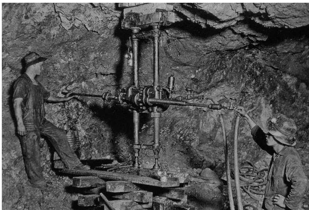
Figura 2.10.- Fotografía de una barrenadora de aire comprimido del tipo empleado en la excavación del Túnel Atarasquillo – Dos Ríos. Archivo Histórico y Museo de Minería, AC. (AMITOS, 2012).
