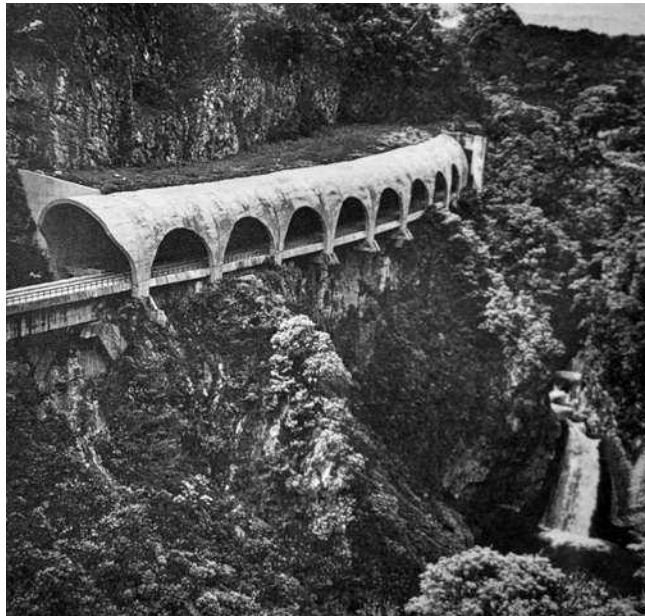
Figura 2.8.- Túnel Falso El Pensil. Línea México – Veracruz (AMITOS, 2012)
