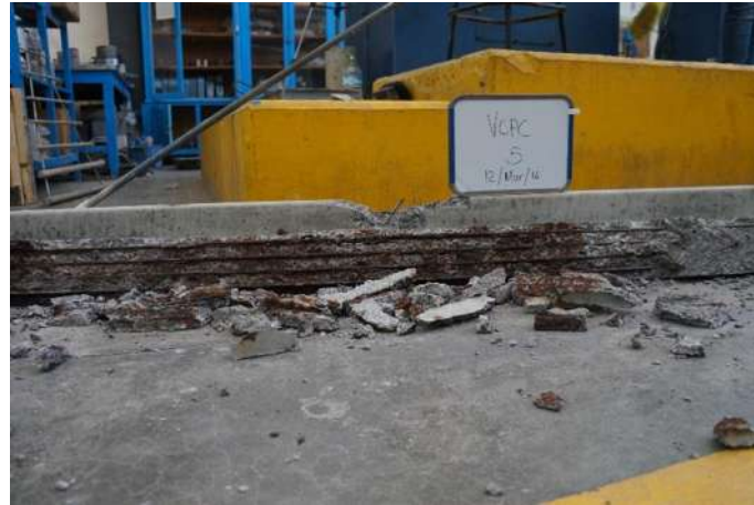
Figura 26. Extracción del acero de pre-esfuerzo
