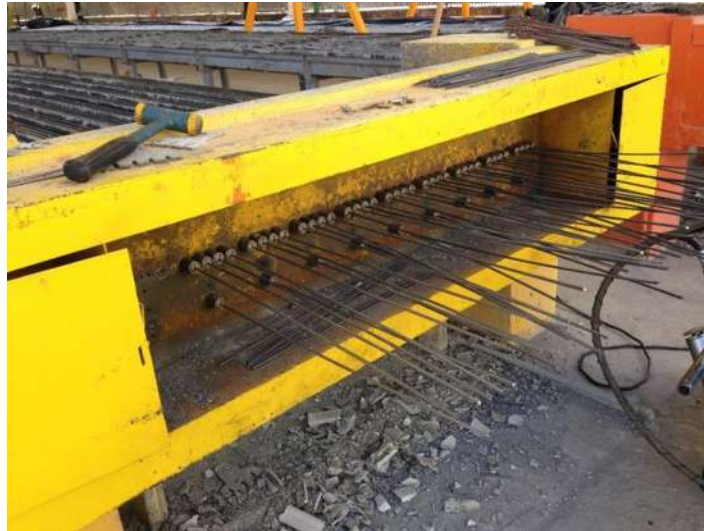
Figura 3. Mesa de pre-tensado para viguetas investigadas
