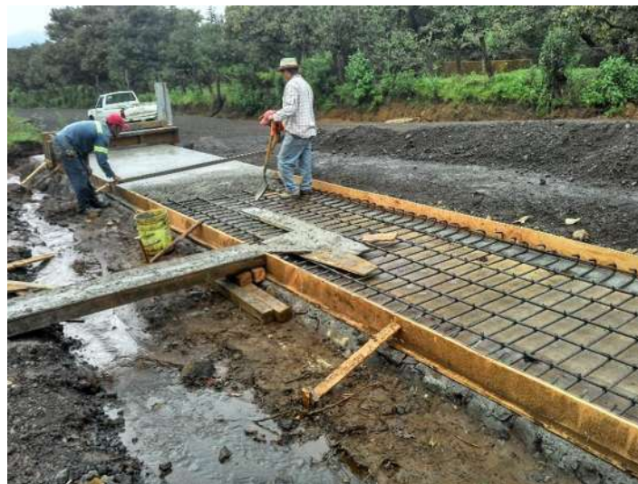
Figura 2. Alcantarilla de losa de concreto reforzado
