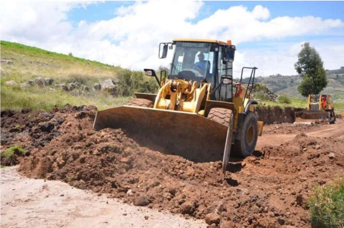
Figura 1.4 Despalme y movimiento de tierras.
