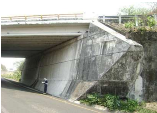
Fotografía 3.19 Estribo con aleros rectos de concreto reforzado.
