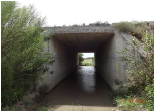
Fotografía 4.1 Alcantarilla formada por losa maciza de concreto y Estribos con aleros a 30°.
