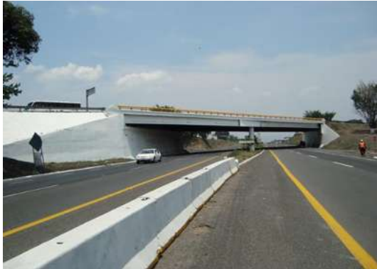
Fotografía 3.6 P.I.V. Formado con Estribos de concreto reforzado con aleros a 30° en los extremos y Caballete intermedio.
