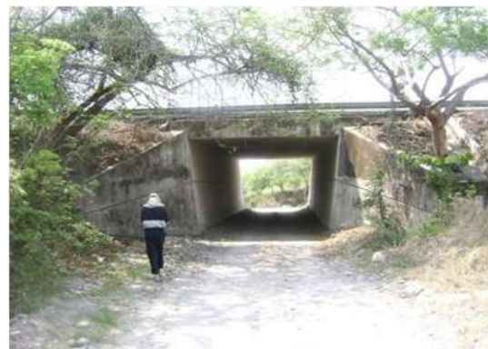
Fotografía 3.20 P.S.V. Formado por losa maciza de concreto y Estribos con aleros a 30°.
