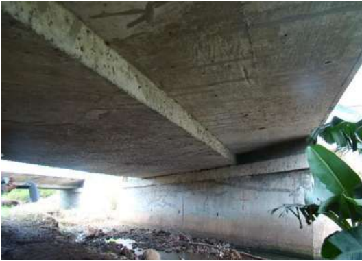
Fotografía 3.25 Losa díptera de concreto reforzado.
