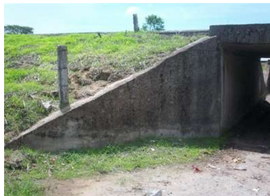
Fotografía 3.16 Estribo de concreto ciclópeo.
