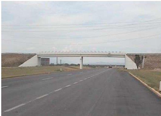
Fotografía 4.4 P.I.V. Formado con Estribos de concreto reforzado con aleros a 30° en los extremos y Caballete intermedio.
