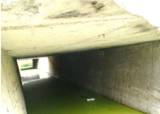
Fotografía 4.22 Estribo con aleros en "U" de concreto reforzado.
