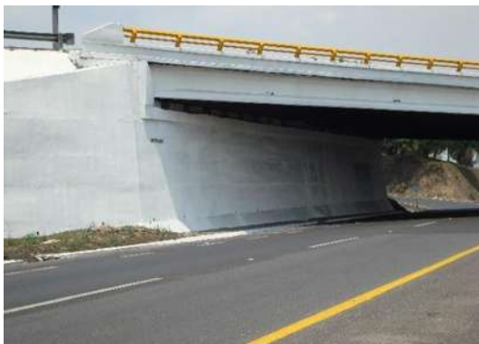
Fotografía 3.8 Estribo con aleros a 30° de concreto reforzado.
