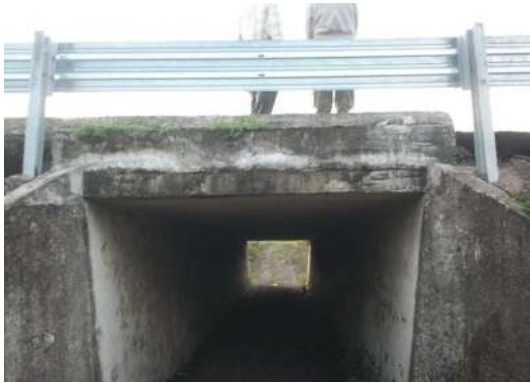
Fotografía 3.21 Losa de concreto reforzado.
