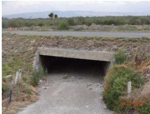
Fotografía 5.7 Vista panorámica del Puente Sin Nombre Cpo. B, km. 31+300
