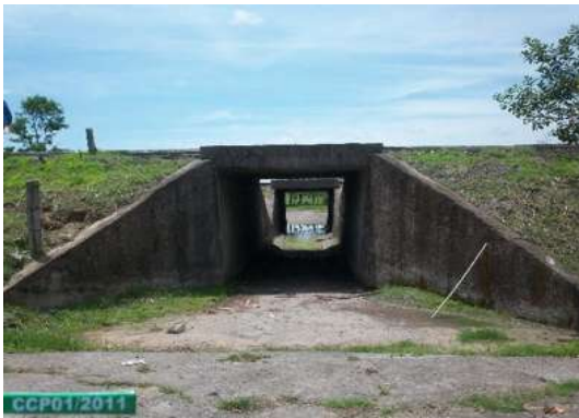
Fotografía 3.14 P.S.G. formada por losa maciza de concreto y Estribos con aleros a 30°.
