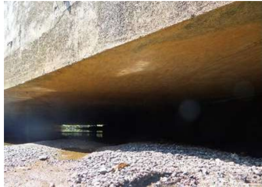
Fotografía 3.24 Losa maciza de concreto reforzado.
