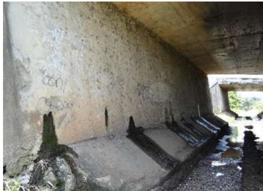
Fotografía 3.3 Estribo de concreto ciclópeo
