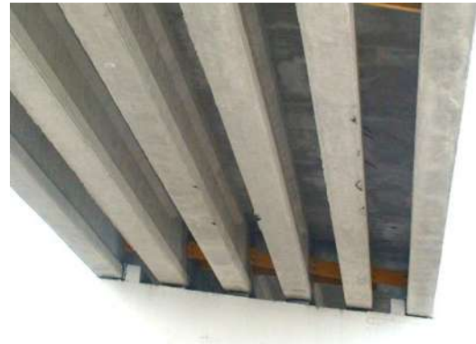
Fotografía 4.9 Superestructura formada por losa de concreto reforzado en colaboración con vigas de concreto presforzado.
