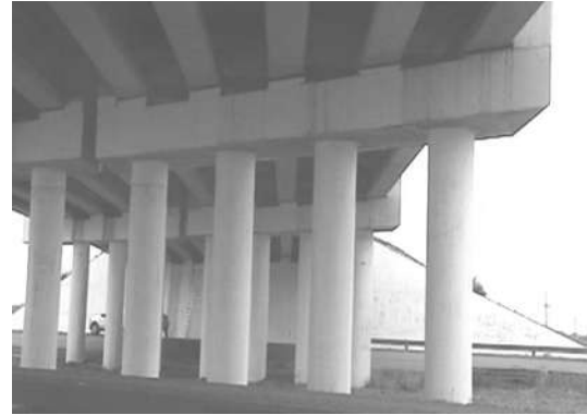
Fotografía 4.7 Caballete intermedio con cabezal de concreto reforzado.
