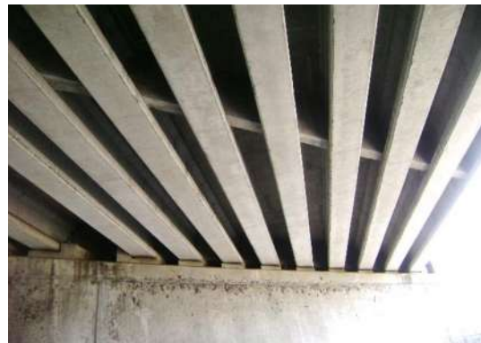
Fotografía 3.18 Superestructura formada por vigas de concreto presforzado.
