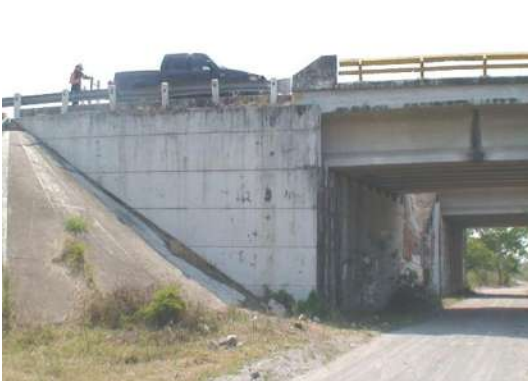
Fotografía 3.27 Estribo con aleros en "U" de concreto reforzado.
