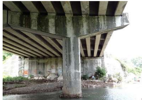
Fotografía 3.30 Pila intermedia formada por una columna y cabezal en doble volado de concreto reforzado.
