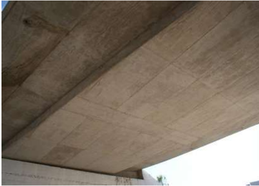
Fotografía 4.20 Losa díptera de concreto reforzado.
