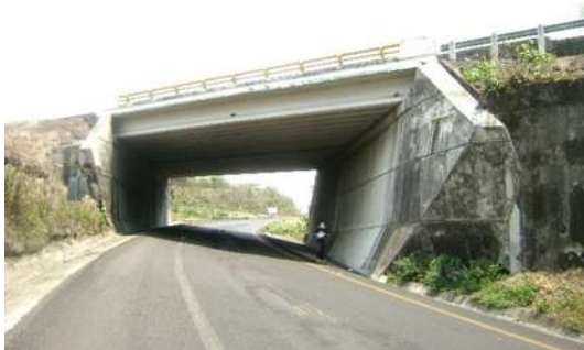
Fotografía 3.17 P.S.V. Formado con Estribos de concreto reforzado con aleros rectos.
