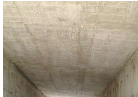
Fotografía 4.16 P.S.V. Formado por losa maciza de concreto reforzado.
