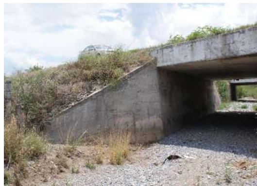
Fotografía 4.14 Estribo de concreto ciclópeo.
