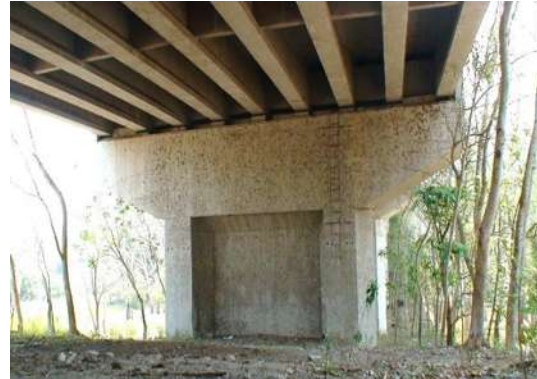
Fotografía 3.32 Pila intermedia formada por un marco y pantalla de concreto reforzado.
