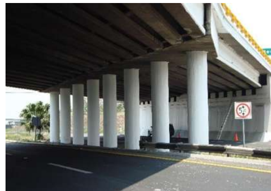
Fotografía 3.9 Caballete intermedio con cabezal de concreto reforzado.
