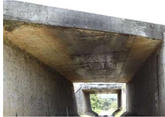
Fotografía 3.2 Losa maciza de concreto reforzado.
