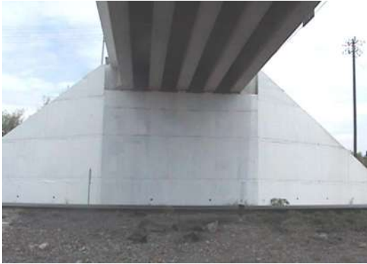
Fotografía 4.6 Estribo con aleros a 30° de concreto reforzado.
