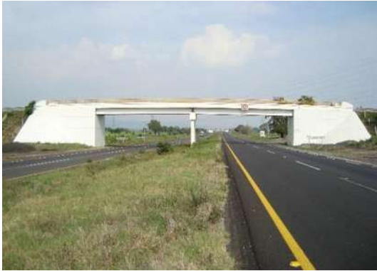
Fotografía 3.10 Formado con Estribos de concreto reforzado con aleros en "U" en los extremos y Pila con sección rectangular intermedia.
