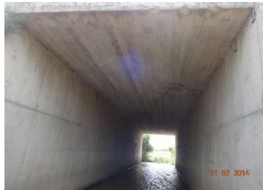
Fotografía 4.2 Losa maciza de concreto reforzado.
