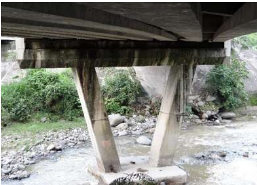
Fotografía 3.29 Pila intermedia en forma de "V" de concreto reforzado.
