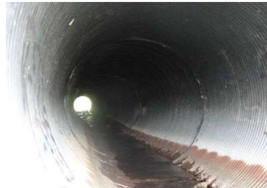
Fotografía 3.5 Interior de la Alcantarilla.
