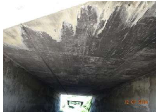
Fotografía 4.13 Losa maciza de concreto reforzado.
