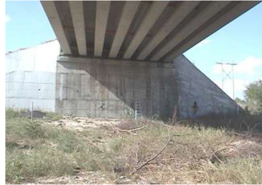
Fotografía 4.21 Estribo con aleros a 30° de concreto reforzado.
