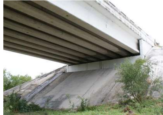
Fotografía 4.23 Caballete de concreto reforzado.
