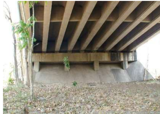
Fotografía 3.28 Caballete de concreto reforzado.
