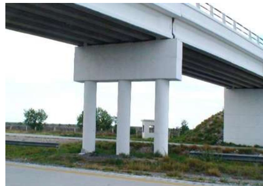
Fotografía 4.11 Pila intermedia de sección rectangular con cabezal de concreto reforzado.
