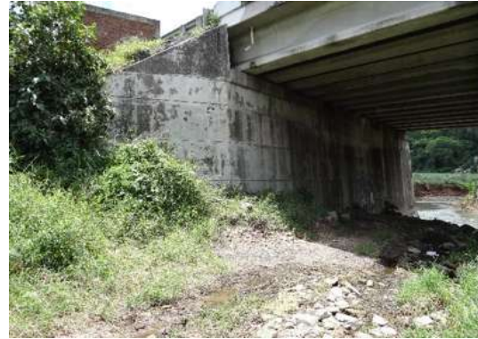
Fotografía 3.26 Estribo con aleros a 30° de concreto reforzado.
