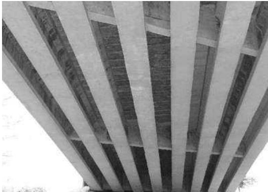
Fotografía 3.23 Losas de concreto reforzado en colaboración con vigas de concreto presforzado.
