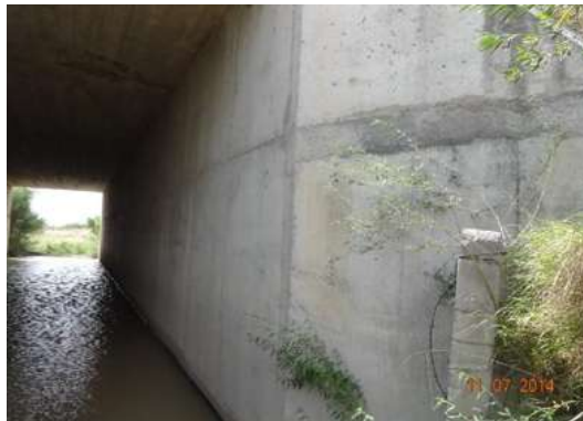
Fotografía 4.3 Estribo de concreto ciclópeo.
