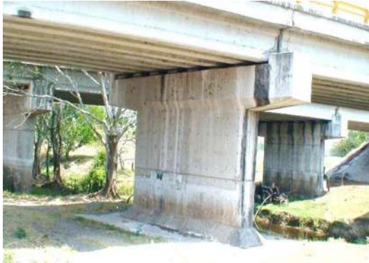
Fotografía 3.31 Pila intermedia formada por una columna rectangular de concreto reforzado.
