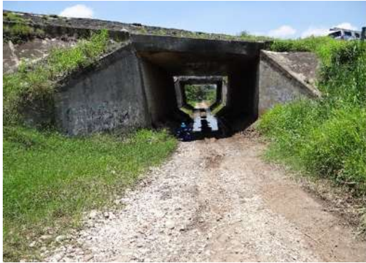
Fotografía 3.1 Alcantarilla formada por losa maciza de concreto y Estribos con aleros a 30°
