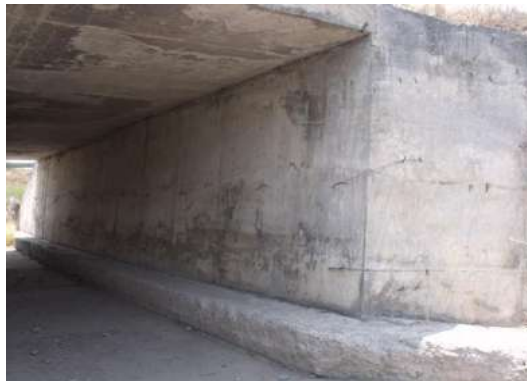
Fotografía 4.17 Estribo con aleros a 30° de concreto reforzado.
