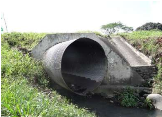
Fotografía 3.4 Alcantarilla formada por tubo de lámina apoyada en los extremos en cabezote de concreto reforzado.
