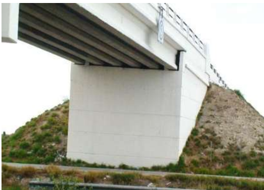
Fotografía 4.10 Estribo con aleros en "U" de concreto reforzado.
