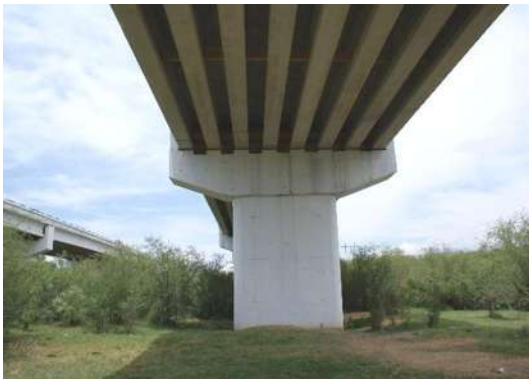
Fotografía 4.24 Pila intermedia formada por una columna de sección constante de concreto reforzado.
