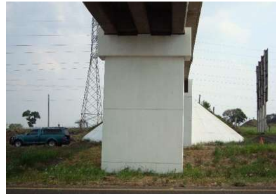
Fotografía 3.13 Pila intermedia de sección rectangular con cabezal de concreto reforzado.
