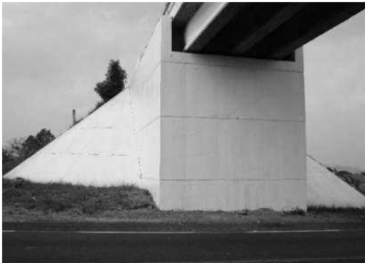
Fotografía 3.12 Estribo con aleros en "U" de concreto reforzado.
