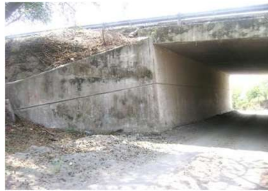
Fotografía 3.22 Estribo de concreto ciclópeo.
