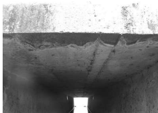
Fotografía 3.15 Losa maciza de concreto reforzado.
