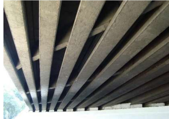
Fotografía 3.7 Superestructura formada por losa de concreto reforzado en colaboración con vigas de concreto presforzado.
