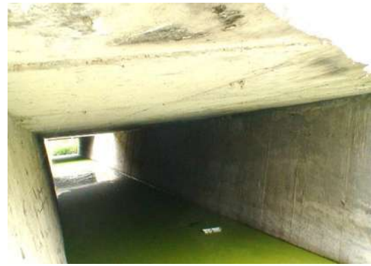
Fotografía 4.19 Losa maciza de concreto
