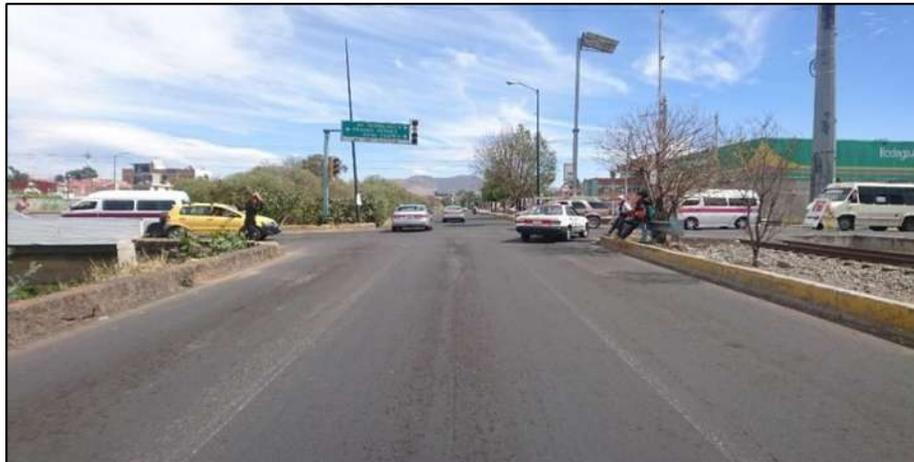
Figura 5.1.3.5 Avenida División del Norte (Oeste – Este), señalamiento horizontal poco visible
