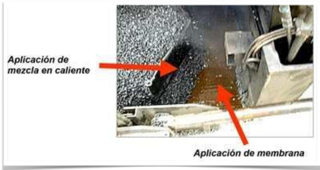
Figura 9 Detalles de la aplicación de la membrana asfáltica y la mezcla CASAA. (Fuente: SCT, 2014)
