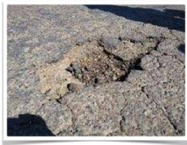
*Figura 30. Desprendimiento de agregado (bache)*
