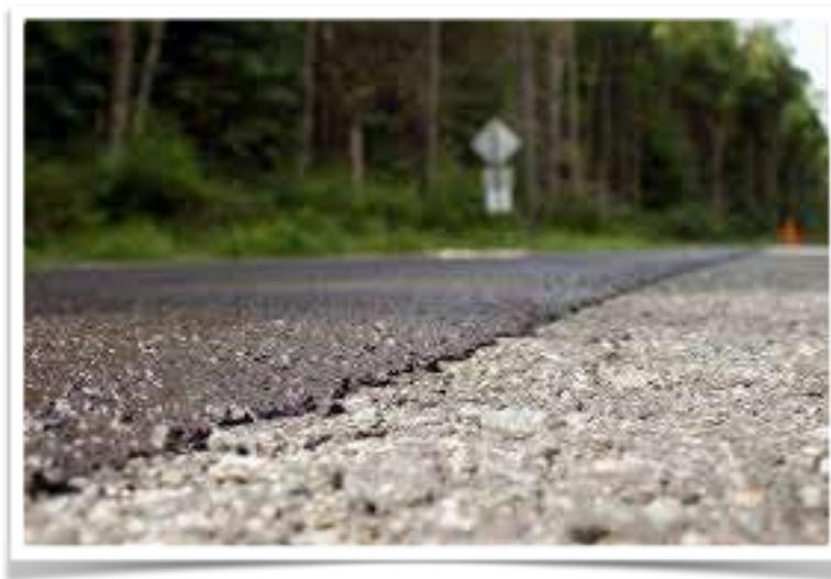
*Figura 13 Aspecto del Slurry Seal. (Fuente: SCT, 2014)*
