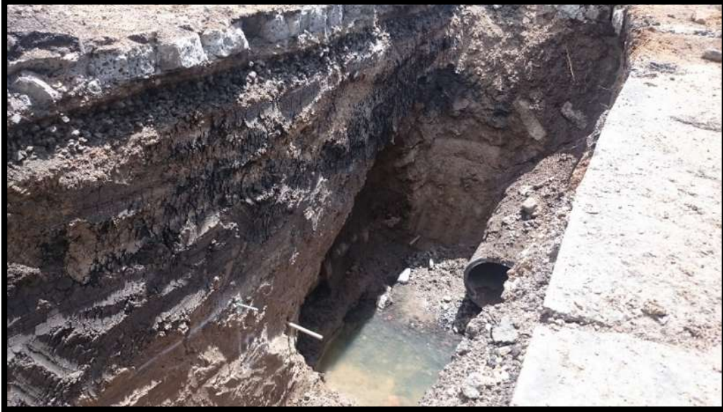
Figura 3.2. Excavación en el Sitio de Estudio
