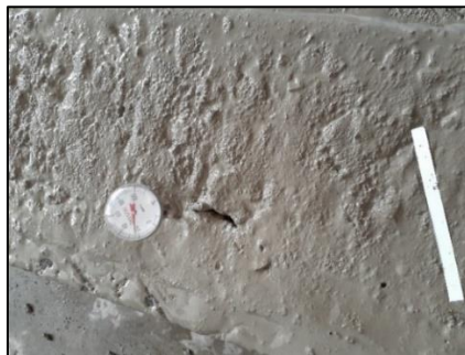
Figura 104. Indicador de pH puesto en contacto con la mezcla de concreto fresco. Fuente: propia.
