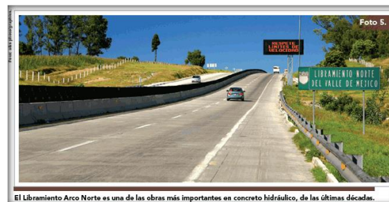
Figura 5. Libramiento Arco Norte, México. Fuente: imcyc.
