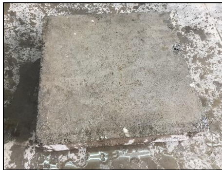
Figura 65. Humedecimiento de la losa de concreto. Fuente: propia.
