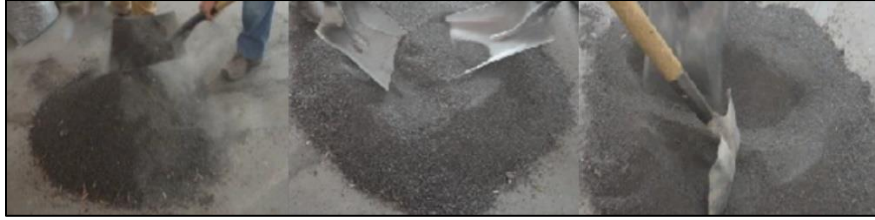
Figura 40. Cuarteo del agregado fino por el método "B". Fuente: propia.
