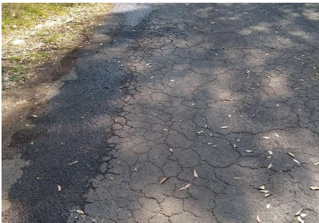
Fig. 4-4 Agrietamiento por fatiga en la Antigua Carretera Morelia-Pátzcuaro
