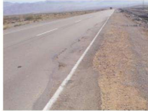
Fig. 2-6 Agrietamiento de Borde (Dirección de vialidad, 2003)
