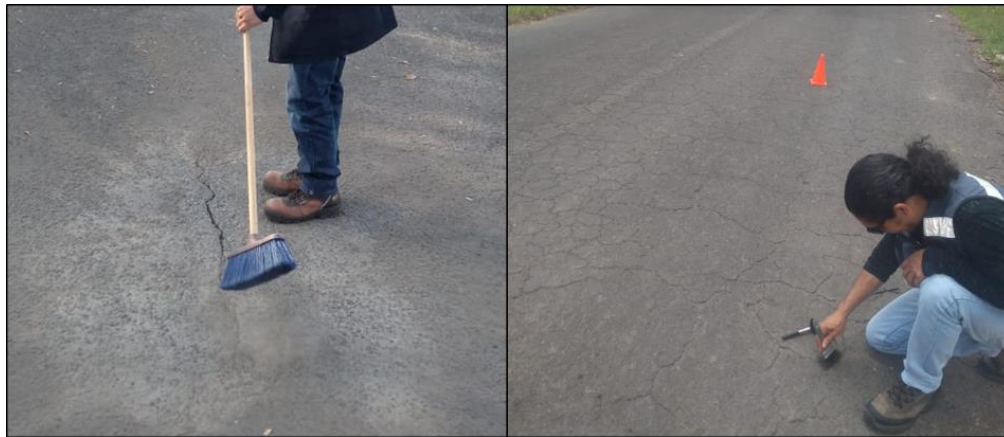
Fig. 3-25 Preparación y limpieza de la superficie
