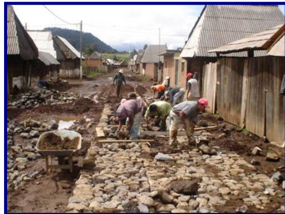
Empedrado No.2 Imagen 7.2 Foto: Leónides Luviano En esta imagen podemos observar la colocación de los empedrados en las calles.
