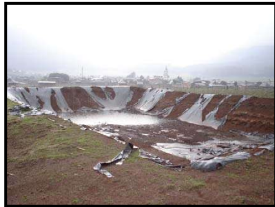
Olla de Captación No. 1. Imagen 3.11 Foto: Leónides Luviano Se puede observar actual deterioro
