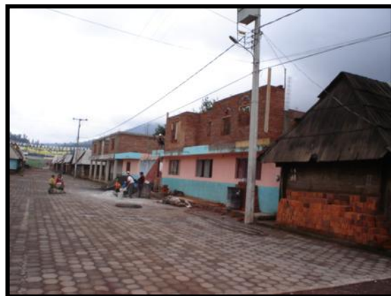
Calle de adocreto. Imagen 3.5 Foto: Leónides Luviano Se observa la calle de adocreto alrededor de la plaza.
