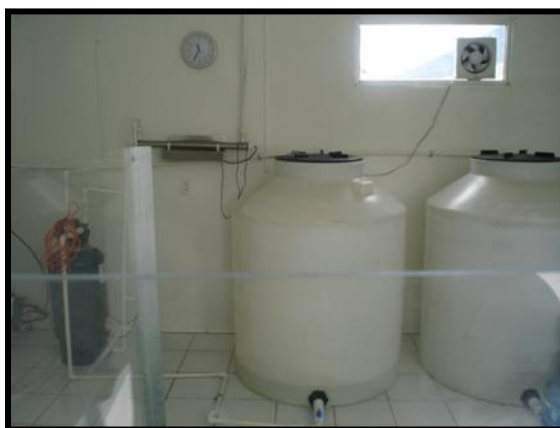
Interior de la planta de captación. Imagen 3.15 Foto: Leónides Luviano
