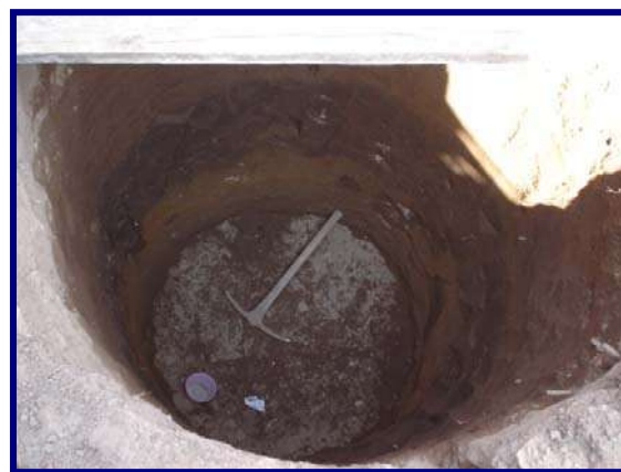
Elaboración Noria. Ficha 05,12. Imagen 5.2 Foto: Leónides Luviano Se observa la excavación de una noria
