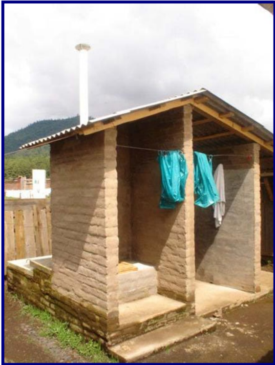
Propuesta No.1 de Unidad Hidro-sanitaria. Ficha 13,03. Imagen 7.7 Foto: Leónides Luviano
