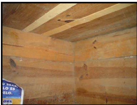
Muros de Troje-Habitación Ficha 01,01,01,02. Imagen 5.9 Foto: Leónides Luviano
