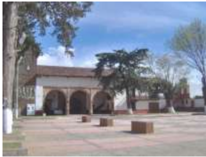
Imagen 54: Colocación de adoquín y empedrado en el atrio del Conjunto.
