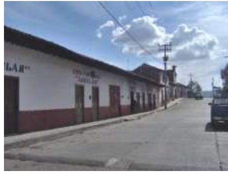
Imagen 51: Cambio de material tradicional por concreto hidráulico en las calles.
