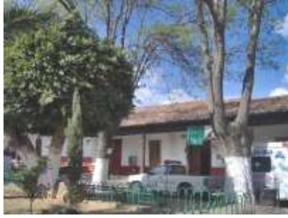
Imagen 52: Cambio de uso de suelo de tienda de raya a Presidencia Municipal.
