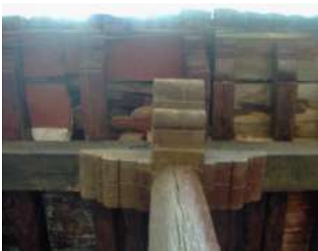
Imagen 73: Estado de deterioro de las cubiertas. Fuente: Foto de Citlali Carrillo.
