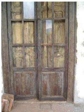
Imagen 16. Detalle de puerta de madera en portal perimetral. Foto: Rafael López Morales
