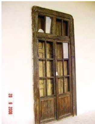
Imagen 16. Detalle de ventana de madera en portal perimetral. Foto: Rafael López Morales
