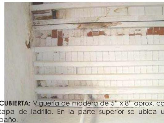
**CUBIERTA:** Vigería de madera de 5" x 8" aprox. con tapa de ladrillo. En la parte superior se ubica un baño.
