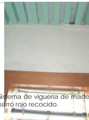
**CUBIERTA:** Sistema de vigería de madera y tapa de ladrillo de barro rojo recocido.
