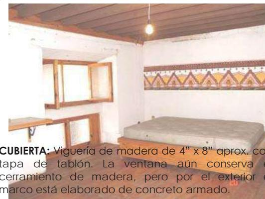
**CUBIERTA:** Viguería de madera de 4" x 8" aprox. con tapa de tablón. La ventana aún conserva el cerramiento de madera, pero por el exterior el marco está elaborado de concreto armado.
