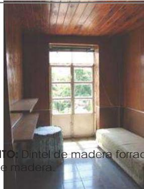
**CERRAMIENTO:** Dintel de madera forrado con chapa de triplay de madera.
