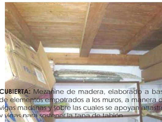
**CUBIERTA:** Mezanine de madera, elaborado a base de elementos empotrados a los muros, a manera de vigas mdrinas y sobre las cuales se apoyan arrastres y vinas para sostener la tapa de tablón
