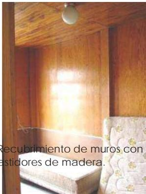
**APOYOS:** Recubrimiento de muros con hojas de triplay y bastidores de madera.
