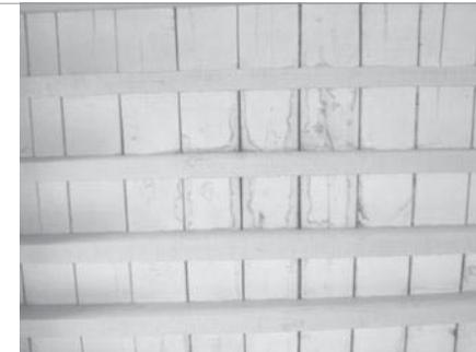
**CUBIERTA:** Vigería de madera de 5"x8" aprox. con tapa de tablón, estructura de madera a tres aguas con teja de barro rojo recocido.
