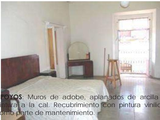
**APOYOS:** Muros de adobe, aplanados de arcilla y pintura a la cal. Recubrimiento con pintura vinilica como parte de mantenimiento.
