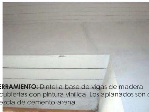
**CERRAMIENTO:** Dintel a base de vigas de madera recubiertas con pintura vinílica. Los aplanados son de mezcla de cemento-arena.
