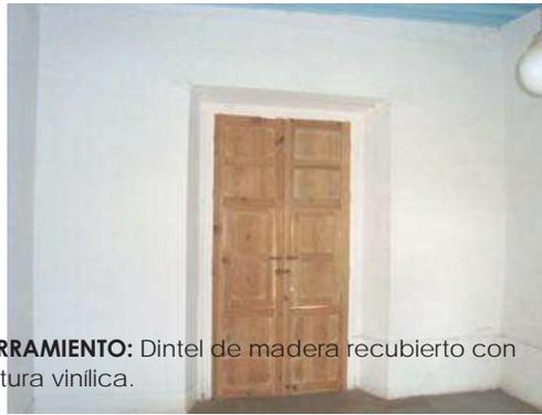
**CERRAMIENTO:** Dintel de madera recubierto con pintura vinilica.
