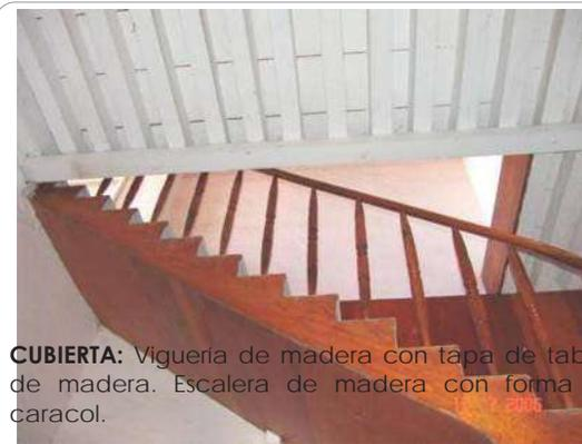
**CUBIERTA:** Viguería de madera con tapa de tablón de madera. Escalera de madera con forma de caracol.
