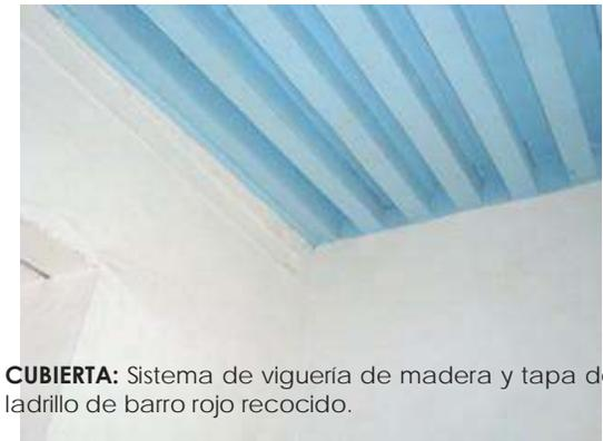
**CUBIERTA:** Sistema de vigería de madera y tapa de ladrillo de barro rojo recocido.
