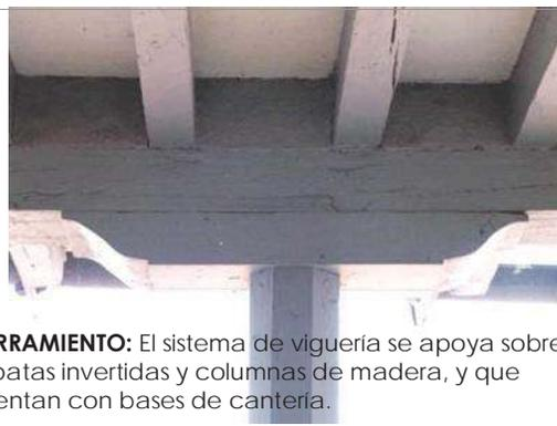
**CERRAMIENTO:** El sistema de viguería se apoya sobre zapatas invertidas y columnas de madera, y que cuentan con bases de cantería.
