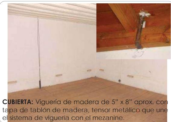
**CUBIERTA:** Vigería de madera de 5" x 8" aprox. con tapa de tablón de madera, tensor metálico que une el sistema de vigería con el mezanine.
