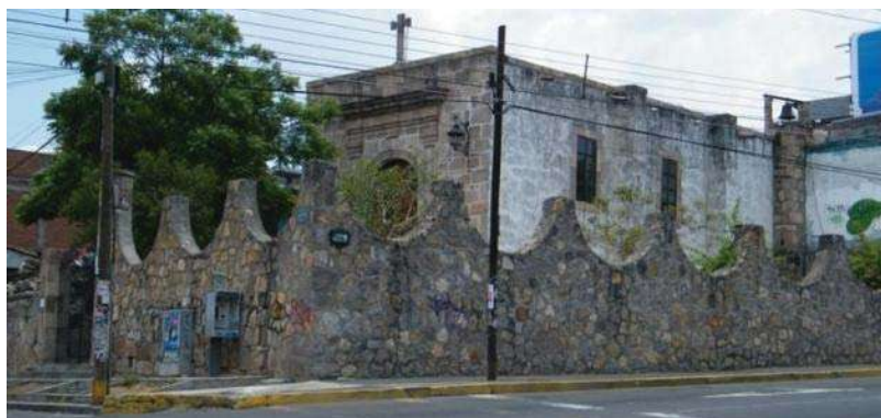
ESTADO ACTUAL DE LA CAPILLA DE SANTIAGUITO UBICADA EN LA COLONIA SANTIAGUITO FOTO ARQ. ANA CECILIA TORRES GUDIÑO 2009
