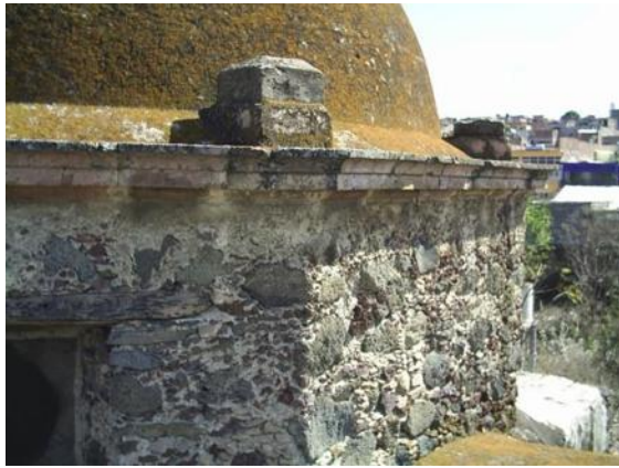
Fotografía del material de construcción del muro
