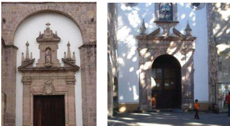
Fig. 54, 55 Elementos de cantería de portadas lateral (izquierda) principal (derecha), foto Alejandra Murillo García
