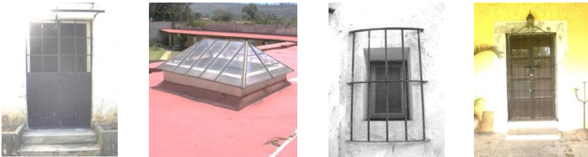
Imagen 78. Elementos de herrería identificados en la casa; de izquierda a derecha, puerta, domo, protecciones y rejas. Fotos: Eder García.
