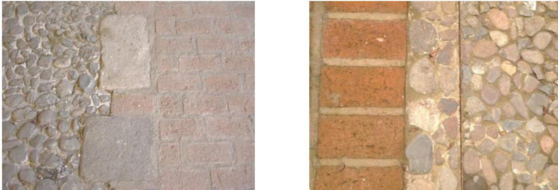
Imagen 63. Ejemplos de acabados compuestos en pisos con materiales como loseta de piedra, ladrillo y piedra de canto rodado, ubicados en el pórtico y corredores. Fotos: Eder García
