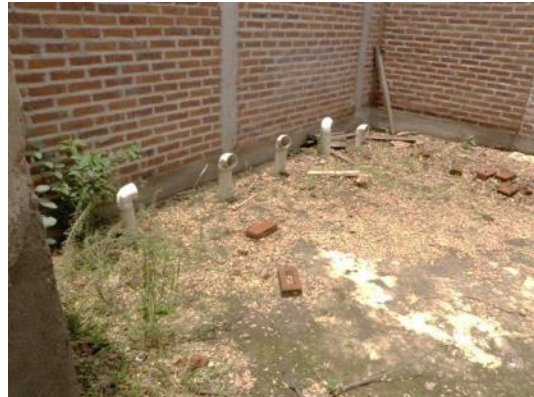
Imagen 56. Fotos de los espacios EXT-02 y EXT-03 donde se conjugan los antiguos muros de adobe con cimientos de mampostería de piedra, y los nuevos muros de ladrillo que subdividieron el espacio sobre cimientos de concreto armado. Fotos: Eder García.
