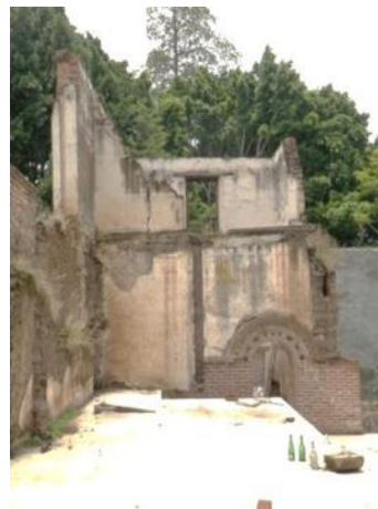
Imagen 93. Fotografía del estado actual de la habitación noreste, el espacio de mayor deterioro de la casa y foco de atención en el proceso de restauración debido a los problemas de la estructura por la falta del refuerzo que brindan las cubiertas. Fotos y croquis: Eder García
