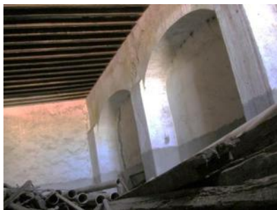
Imagen 87. A pesar de la falta de mantenimiento y el descuido que presenta, la bodega es otro de los espacios que conservan más elementos originales, incluyendo su cubierta de viguería y bovedilla de ladrillo, Fotos: Eder García.
