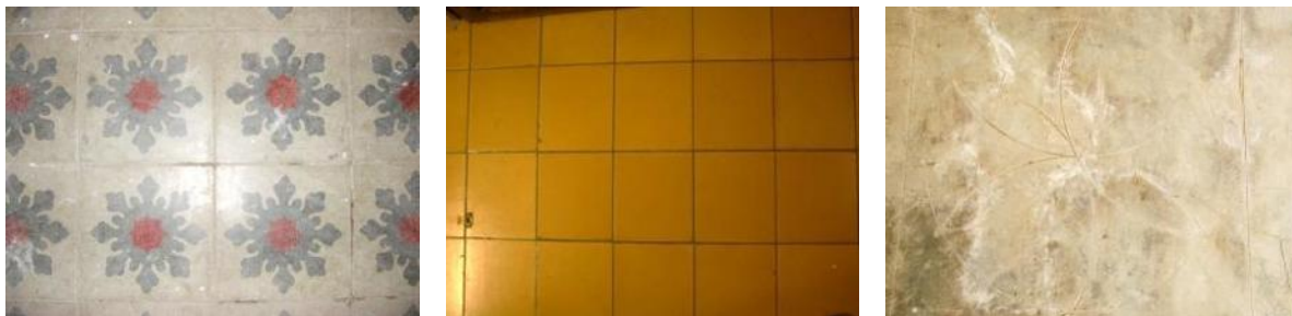
Imagen 62. Algunos tipos de acabados en piso, concreto (derecha), loseta cerámica (centro) y piso de pasta (izquierda). Fotos: Eder García.
