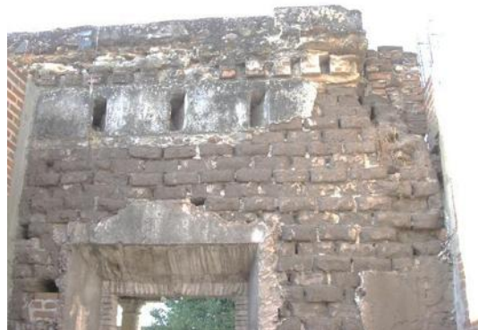
Imagen 52. Fotografías de los tipos de apoyos en la Casa del Hacendado, aislados con columnas de piedra (izquierda) y corridos con muros de adobe (derecha) como sistema original que ha sufrido modificaciones en algunos espacios.
