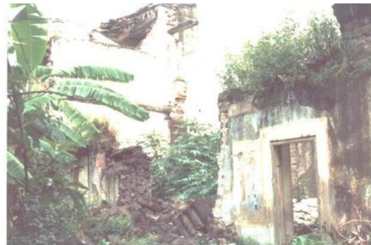
Imagen 38. Fotografías del estado en que se encontraba la Casa del Hacendado alrededor de 1990, en donde se puede observar la falta de los corredores oriente y norte conservando aún los tambores que conformaban las columnas (izquierda), y las habitaciones del corredor norte, donde actualmente se tiene un estrado y los restos de dichas habitaciones se han perdido (derecha). Fotos: Archivo personal de Jaime Alberto Vargas Chávez.
