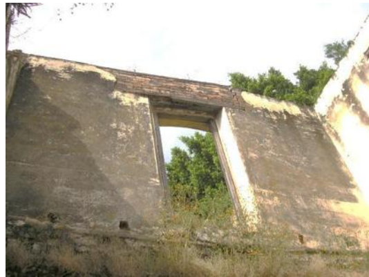
Imagen 54. La zona noreste es la más dañada de la casa, la falta de cubierta y la altura de los muros carentes de soportes ha derivado en la pérdida de algunas áreas de ellos y el desplome causando grietas. Fotos: Eder García.
