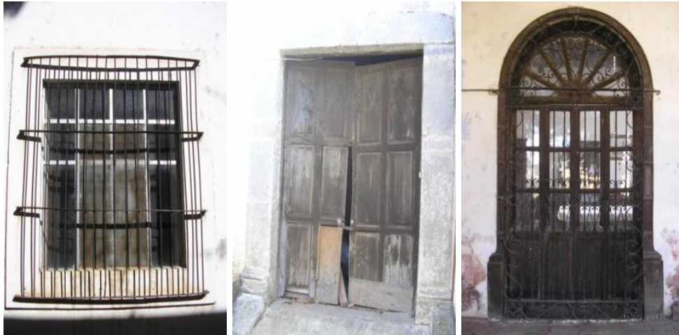
Imagen 47. Tipos de vanos en el pórtico de la casa; de izquierda a derecha, simple con marcos y protecciones de herrería, puerta de madera y marco de cantería, puerta y marco de madera tallada con protecciones de herrería. Fotos: Eder García.
