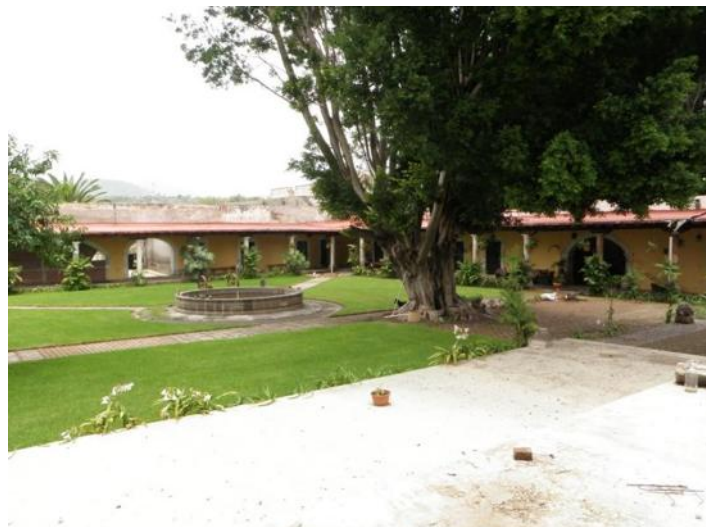
Imagen 6. La Casa del Hacendado contiene diversos trabajos de intervención previos cuya permanencia será valorada así como la consolidación de la estructura general que garantice la permanencia del edificio. Foto: Eder García.
