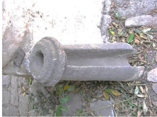
Imagen 99. Algunos ejemplos de elementos deteriorados y fuera de su posición original, y que podrán ser utilizados como modelos para las integraciones, como el fuste de una de las columnas del corredor o una de las gárgolas del pórtico. Fotos: Eder García.
