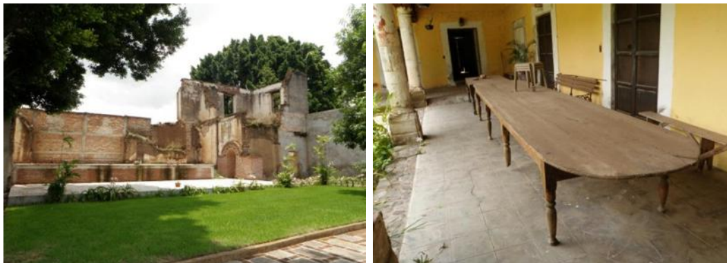
Imagen 7. La Casa del Hacendado actualmente es rentada como salón de fiestas por lo que para ese nuevo uso fue necesario hacer algunas adecuaciones que van desde el equipamiento de mobiliario (derecha) hasta la creación de nuevos espacios que alteran significativamente el edificio como son sanitarios y un estrado (izquierda). Fotos: Eder García.
