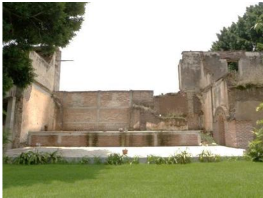
Imagen 54. La zona noreste es la más dañada de la casa, la falta de cubierta y la altura de los muros carentes de soportes ha derivado en la pérdida de algunas áreas de ellos y el desplome causando grietas. Fotos: Eder García.
