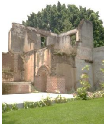
Imagen 93. Fotografía del estado actual de la habitación noreste, el espacio de mayor deterioro de la casa y foco de atención en el proceso de restauración debido a los problemas de la estructura por la falta del refuerzo que brindan las cubiertas. Fotos y croquis: Eder García
