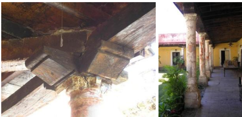
Imagen 50. Corredor poniente, a la izquierda el detalle del acomodo de las zapatas, la gualdra y las vigas de concreto, a la derecha la distribución de la columnata. Fotos: Eder García.
