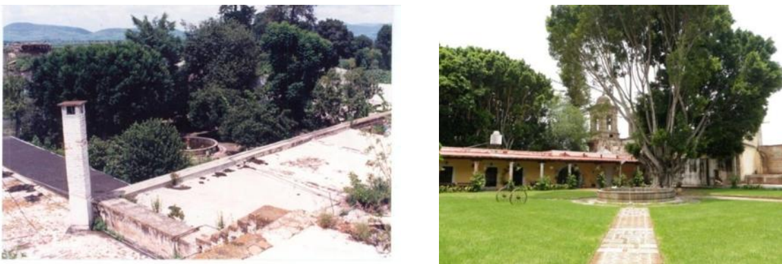
Imagen 79. Foto de estado en que se encontraba el patio de la casa y cómo se encuentra en la actualidad tras el proceso de remodelación de jardinería. Fotoantigua: Archivo personal de Jaime Alberto Vargas Chávez. Foto actual: Eder García.
