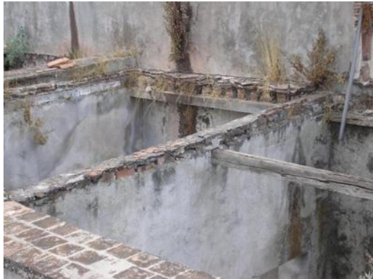
Imagen 98. Las integraciones de cubiertas (izquierda) y pisos (derecha) son dos de las actividades que más se emplearán en el proyecto de restauración; en el caso de la primera se optarán en su totalidad por materiales y técnicas tradicionales, en el caso de la segunda se podrán utilizar materiales contemporáneos que armonicen con los existentes. En ambos casos se denotará y dejará constancia que se trata de una intervención posterior para evitar falsificaciones. Fotos: Eder García.
