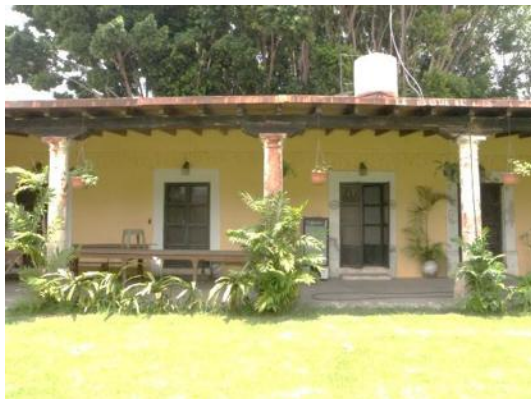
Imagen 52. Fotografías de los tipos de apoyos en la Casa del Hacendado, aislados con columnas de piedra (izquierda) y corridos con muros de adobe (derecha) como sistema original que ha sufrido modificaciones en algunos espacios.
