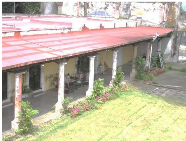
Imagen 17. Fotografía de la columnata del corredor poniente de la casa del hacendado, tomada desde la azotea de la casa durante el reconocimiento del contexto interior de la hacienda. Foto: Eder García.
