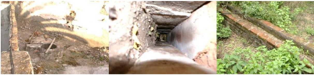
Imagen 73. Elementos que conformaban la antigua instalación hidráulica de la casa, el pozo (izquierda), su conducto (centro) y la acequia (derecha). Fotos: Hugo Pedraza y Eder García.
