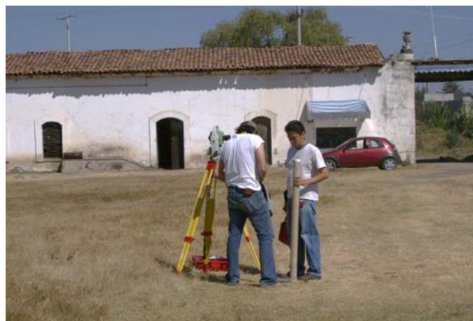
Imagen 23. Fotografía que muestra la preparación del equipo (estación total y estadal con prisma) para realizar el levantamiento arquitectónico en la casa del hacendado. Foto: Ángeles Muñoz.
