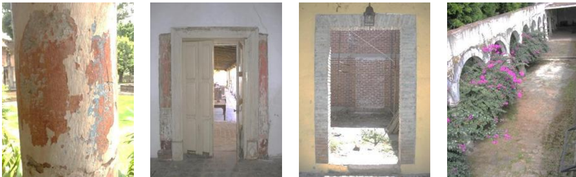
Imagen 36. Algunos de los aspectos que denotan modificaciones a la casa durante el siglo XIX son la construcción del pórtico de acceso con la tipología constructiva decimonónica, el uso de marcos de ladrillo en vanos característicos del pueblo y uso mismo del ladrillo como material, la transformación en las proporciones de las puertas y la carpintería de la época, y las capas de pintura características de diversas épocas que se observan en muros y columnas.
