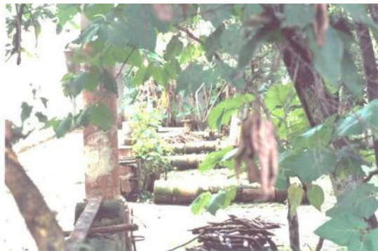
Imagen 38. Fotografías del estado en que se encontraba la Casa del Hacendado alrededor de 1990, en donde se puede observar la falta de los corredores oriente y norte conservando aún los tambores que conformaban las columnas (izquierda), y las habitaciones del corredor norte, donde actualmente se tiene un estrado y los restos de dichas habitaciones se han perdido (derecha). Fotos: Archivo personal de Jaime Alberto Vargas Chávez.
