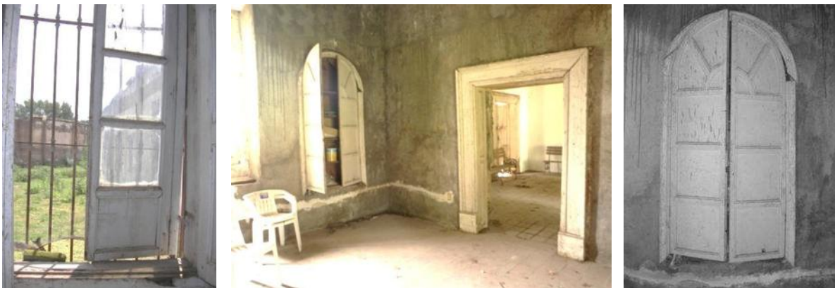
Imagen 76. La mayoría de los elementos de carpintería conservaban el mismo diseño, puerta doble en los vanos exteriores (izquierda), simple en los interiores (centro), e incluso los elementos adicionales armonizaban con el resto (derecha).
