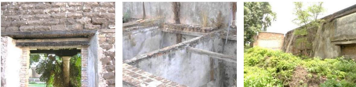
Imagen 82. Ejemplos de deterioro por agentes antrópicos: incendio (izquierda) con la presencia de dinteles de madera calcinados, demolición (centro) con la pérdida de cubiertas, e incuria (derecha) con el descuido y la falta de mantenimiento. Fotos: Eder García.
