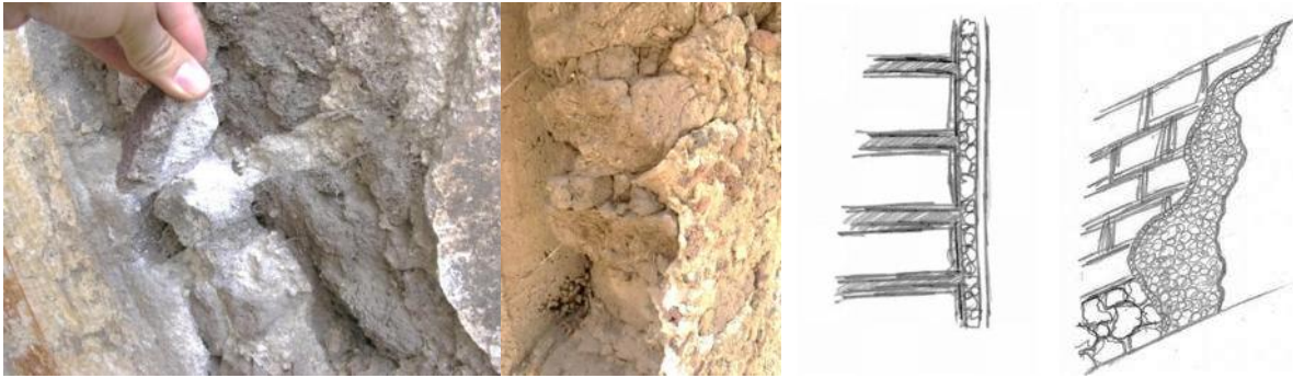
Imagen 65. Estructura de la capa de piedras pequeñas colocadas sobre los muros de adobe para poder recibir los aplados sin dañar el material base. Fotos: Eder García.
