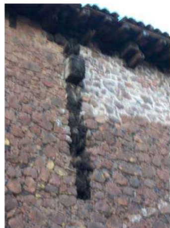
Imagen 114 Cabezas de las vigas del arco
