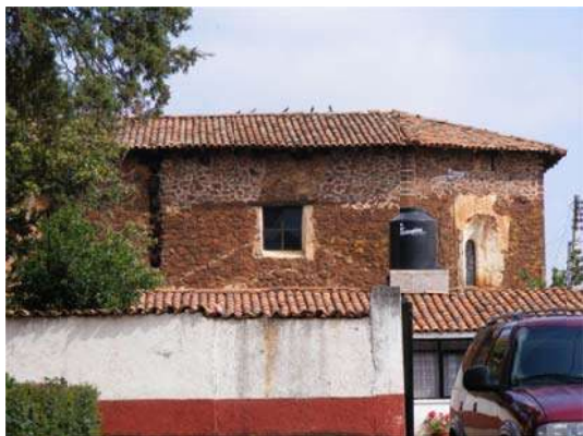
Imagen 33 Fachada sur, donde se observa la techumbre Foto: tomada por el autor
