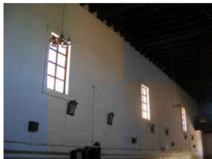
Imagen 5 Muro interior del templo Foto: tomada por el autor
