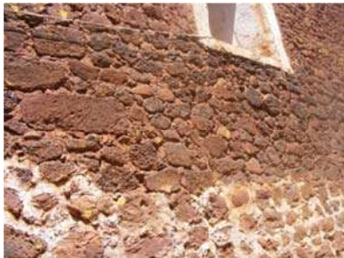
Imagen 104 Mortero en las juntas
