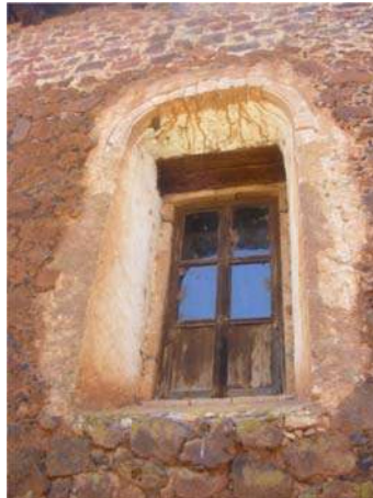
Imagen 66 Capialzado terminado en un arco deprimido
