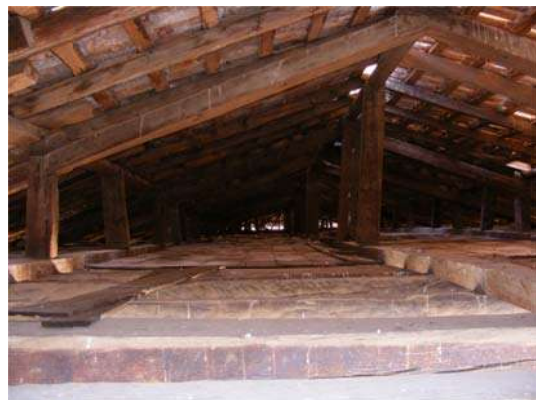
Imagen 34 Armadura de la cubierta de madera Foto: Hugo Alejandro Pedraza Marrón
