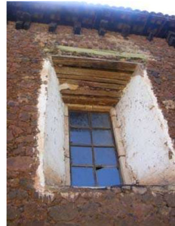
Imagen 67 Cerramiento de madera formando el capialzado
