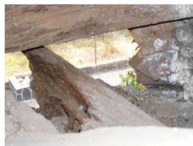
Imagen 117 Vigas a la intemperie
