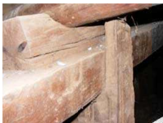
Imagen 57 Larguero q se apoya sobre tornapunta entre ellos un durmiente con asiento.
