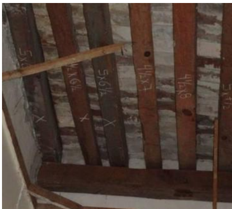
Figura 30.- Medidas marcadas en vigería. Foto Alelí Cortés Vargas.
