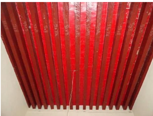
Figura 75.- Cubierta de vigería. Foto: Alelí Cortes
