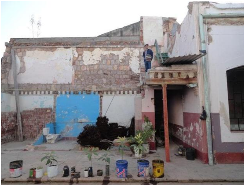
Figura 96.- Locales demolidos en torno al segundo patio. Foto: Alelí Cortés.
