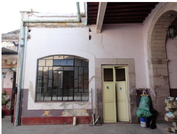
Figura 29.- Local 11 del segundo patio con arco escarzano. Foto: Alelí Cortés Vargas.
