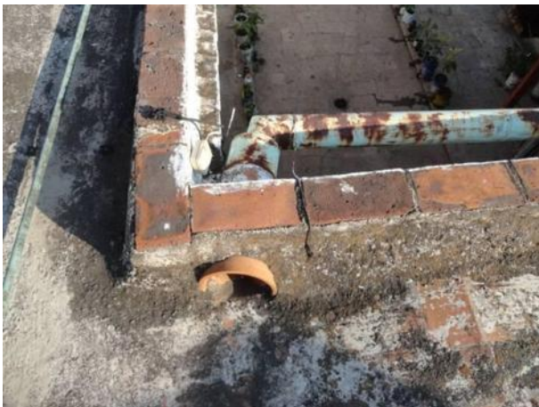
Figura 78.- Bajada de aguas pluviales. Foto: Alelí Cortes
