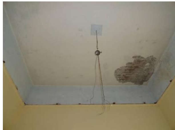
Figura 79. Instalación eléctrica visible. Foto: Alelí Cortes
