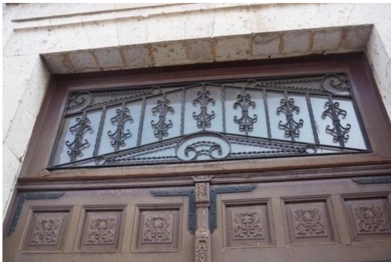
Figura 55.- Detalle del fijo de herrería del portón de acceso. Foto: Juan Antonio Tapia Romero.
