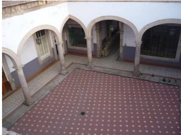
Figura 7.- Vista superior del patio donde se aprecian los arcos cruzados en esquina. Foto: Juan Antonio Tapia Romero
