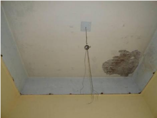
Figura 92.- Local donde se sustituyó la vigería por losa de Concreto. Foto: Alelí Cortés.
