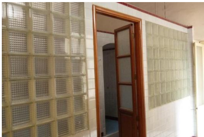
Figura 58.- Empleo de muros divisorios de vitrobloc. Foto Juan Antonio Tapia Romero.
