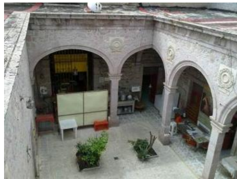
Fig. 26 El patio se convierte en el elemento principal para la incidencia ambiental en la vivienda, ya que es donde fluyen las ventilaciones principales así como los asoleamientos que regulan el confort térmico de los espacios. Foto: Elvia Gutiérrez.
