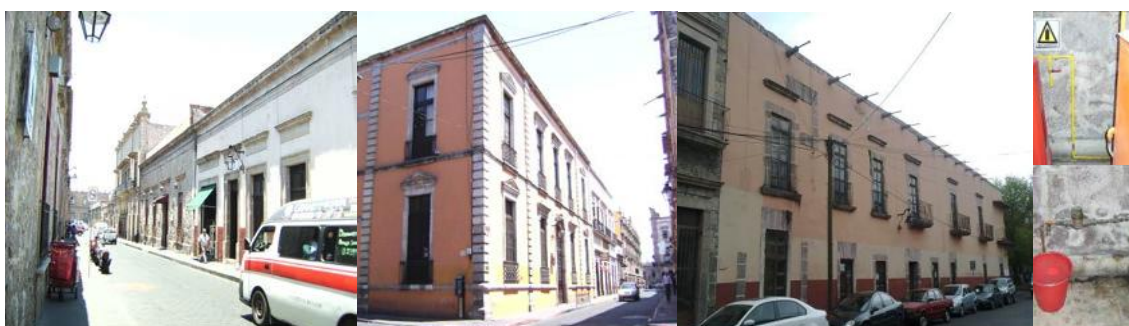
Fig. 22 Infraestructura, de izquierda a derecha vistas: 1. Alumbrado y transporte y aseo público, adoquinado de calle, 2. Cableado de luz eléctrica, banquetas con rampas para discapacitados. 3. Poste v cableado de teléfono. 4. Servicio de agua potable v gas. Fotos: Elvia Gutiérrez.
