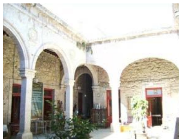
Fig. 43 Imagen del patio central y corredores, espacio distribuidor de la casa, con los elementos que lo delimitan, el sistema de cubierta a base de vigería de madera y terrado, pilares, arcada y cornisa. Foto: Elvia Gutiérrez.
