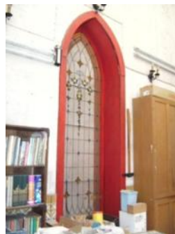
Fig. 44 Vitral en vano de arco ojival en el comedor, que da al gimnasio y bodega. Foto: Elvia Gutiérrez.
