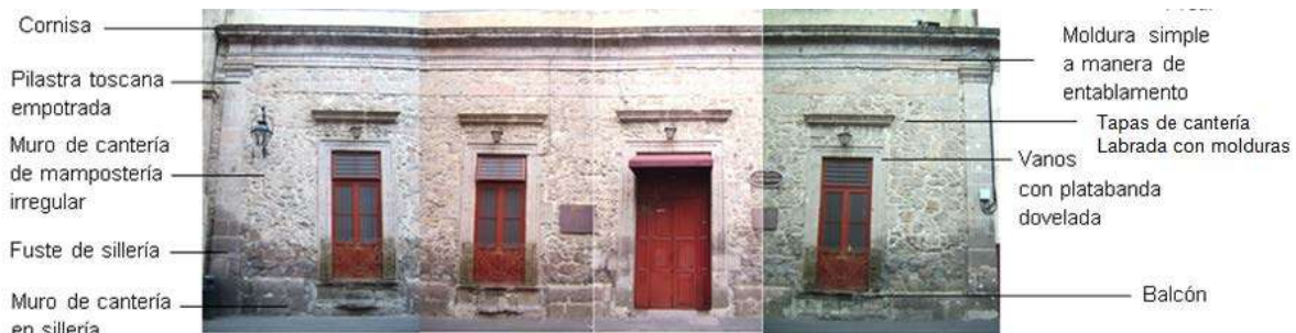
Fig. 41. Composición de la fachada del inmueble con los cuatro elementos que enmarcan el cuerpo y la distribución de los vanos. Foto: Elvia Gutiérrez.
