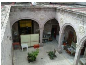
Fig. 40 El patio se convierte en el elemento principal para la incidencia ambiental en la vivienda, ya que es donde fluyen las ventilaciones principales así como los asoleamientos que regulan el confort térmico de los espacios. Foto: Elvia Gutiérrez.
