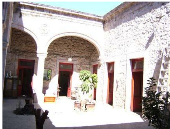
Fig. 28 Vista del patio central de la casa, uno de los primeros contactos con el inmueble. Foto: Elvia Gutiérrez.
