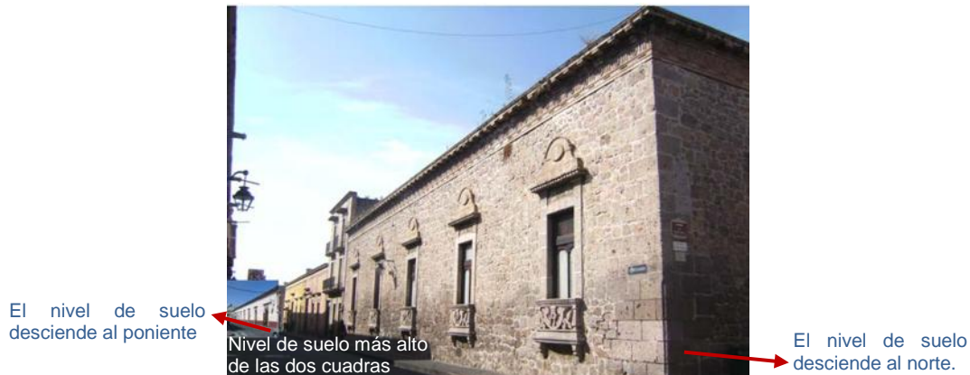
Fig. 10 Morfología y topografía de los frentes sur de las manzanas 12 y 15 ubicadas en la vialidad Melchor Ocampo. Foto y adecuación: Elvia Gutiérrez. [12/05/2012].
