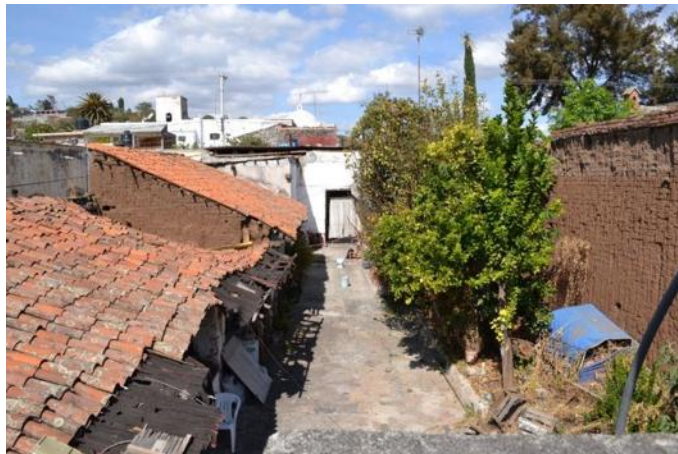
Fotografía 11: Vista del solar hacia el zaguán, en que se observan cubiertas de teja y muros de adobe.
