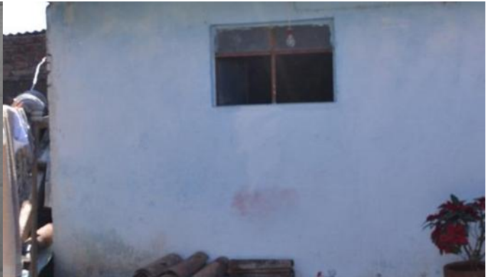
Fotografía 104: Vista del aplanado a base de cemento-arena en los muros del baño.
