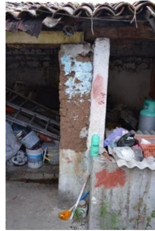
Fotografía 89: Vista de uno de los pilares que dan soporte a la cubierta de los nuevos hornos. Autor: Andoni Quezada M.
