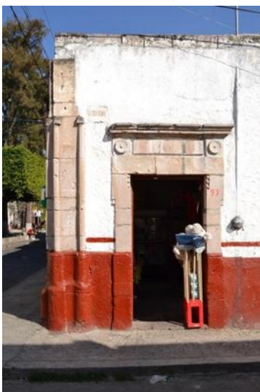
Fotografía 69: Detalle del enmarcamiento de la única puerta de la fachada oeste.
