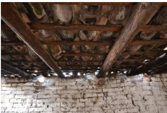
Fotografía 90: Vista inferior de una de las cubiertas a un agua a base de vigería de madera. Autor: Andoni Quezada M.
