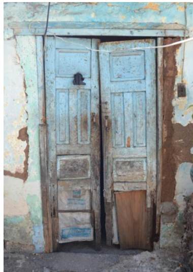
Fotografía 111: Vista de una puerta, muestra de la carpintería del sitio.
