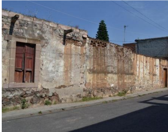
Fotografía 80: Vivienda tradicional de adobe, con enlucido de cal, marcos labrados en piedra de cantería, ventanas y puertas de madera tallada y sobrecimientos de mampostería de piedra volcánica. Nótese el predominio de paramento sobre vano. Autor: Andoni Quezada M.
