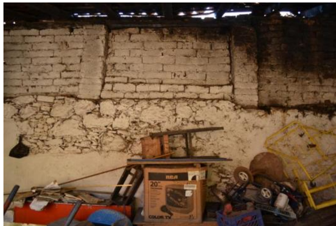
Fotografía 43: Vista del muro colindante con la calle Melchor Ocampo donde se observan dos tipos de aparejos: en la parte baja uno elaborado con mampostería de cantera y en la parte superior otro elaborado con mampostería de adobe.
