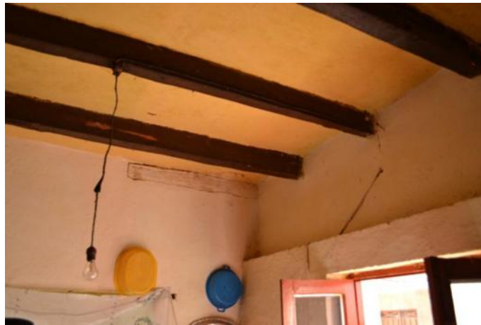
Fotografía 47: Cubierta en cocina y comedor. Autor: Andoni Quezada M.
