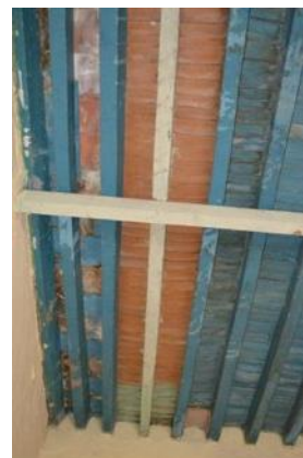
Fotografía 96: Cubierta en habitación. Autor: Andoni Quezada M.
