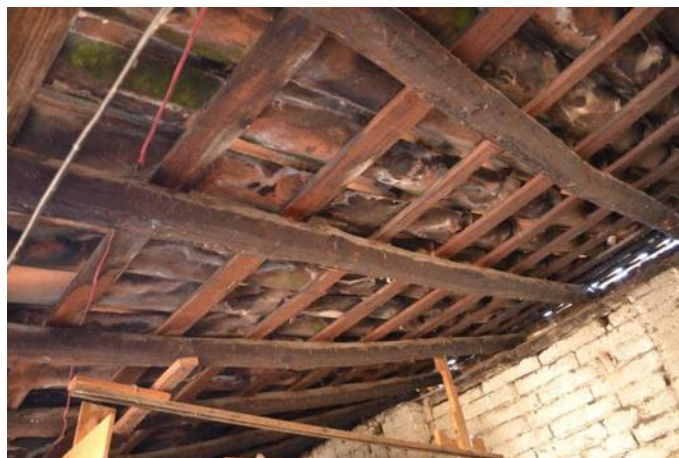
Fotografía 48: Cubierta en nave de antiguo horno panadero. Autor: Andoni Quezada M.
