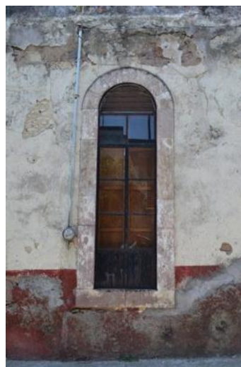
Fotografía 68: Detalle de la fachada norte Autor: Andoni Quezada
