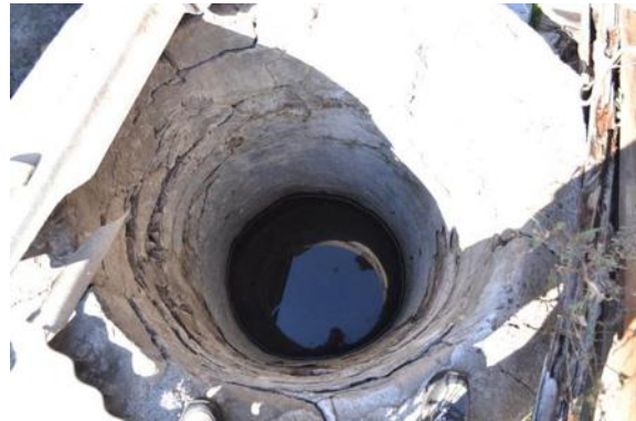
Fotografía 110: Vista de la antigua noria que abastecía de agua a la vivienda.
