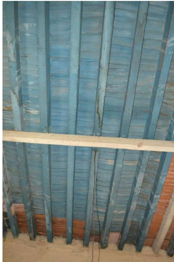
Fotografía 9: Cubierta de vigerías y tapas de tejamanil y ladrillo.
