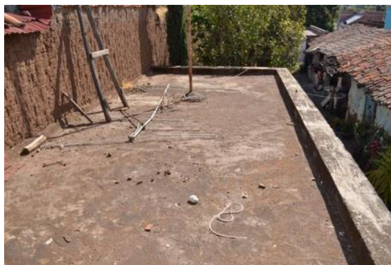
Fotografía 91: Vista de la azotea correspondiente a la cubierta de la cocina y el comedor. Autor: Andoni Quezada M.
