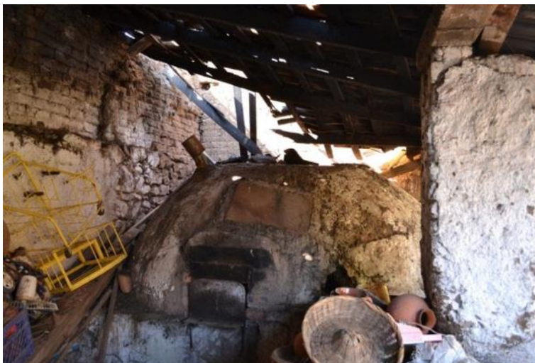
Fotografía 72: PRIMERA ETAPA Local con el horno de barro
