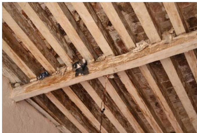
Fotografía 44: Cubierta localizada en el zaguán
