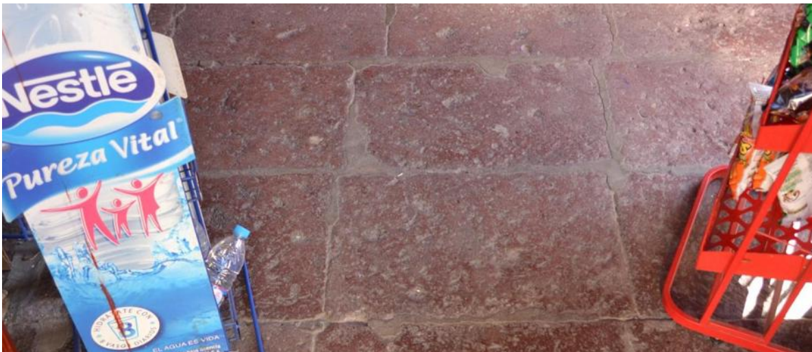
Fotografía 58: Detalle del piso colocado en la tienda de abarrotes. Nótese que las piezas se encuentran completas lo mismo que no presentan humedades.
