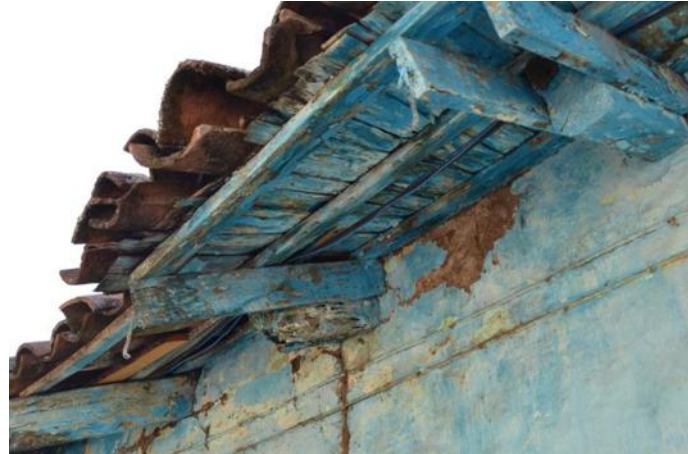
Fotografía 46: Cubierta correspondiente a la actual panadería. Autor: Andoni Quezada M.
