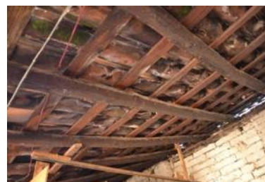
Fotografía 99: Cubierta en nave de antiguo horno panadero. Autor: Andoni Quezada M.
