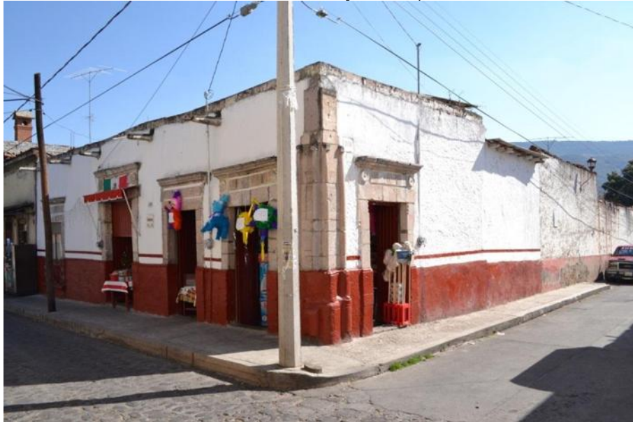
Fotografía 66: Vista de las dos fachadas en su intersección, donde se aprecian la presencia de discretos elementos ornamentales en la cadena de ángulo, tapas y enmarcamientos de los vanos.
