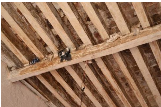
Fotografía 95: Cubierta localizada en el zaguán. Autor: Andoni Quezada M.
