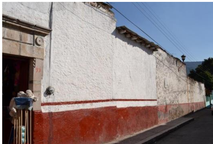
Fotografía 13: Muro oeste de la vivienda, donde se advierte la cromática del guardapolvos y la pared junto con los tonos rosáceos del marco de cantera del vano.
