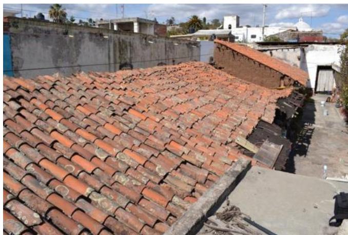
Fotografía 28: Vista parcial de las cubiertas existentes. Autor: Andoni Quezada M.
