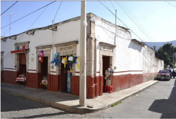
Fotografía 81: Iluminación natural sobre la fachada norte y poniente Autor: Andoni Quezada Morales
