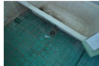
Fotografía 102: Vista del acabado del piso en el baño.
