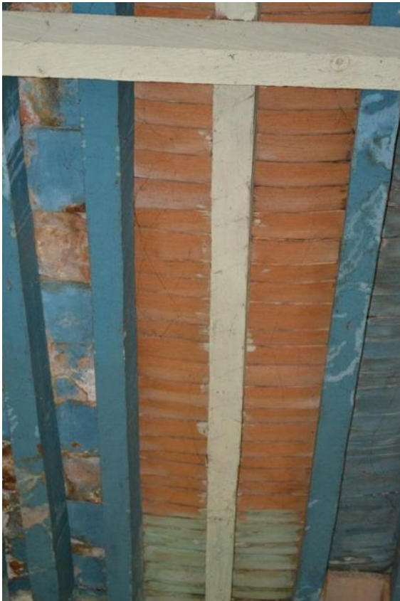
Fotografía 8: Cubierta de vigería y tapas de ladrillo.
