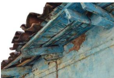
Fotografía 97: Cubierta correspondiente a la actual panadería. Autor: Andoni Quezada M.
