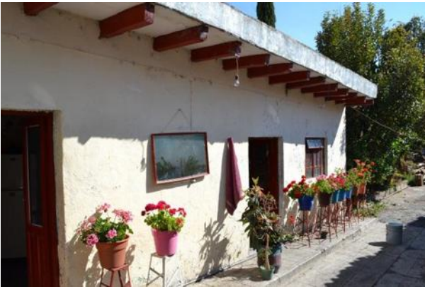
Fotografía 88: Vista de la estructura que compone la cocina y el comedor. Autor: Andoni Quezada M.
