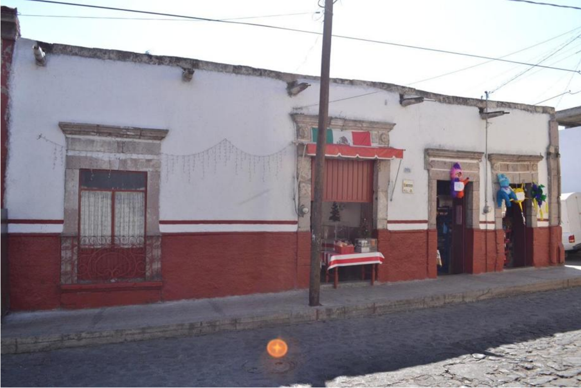
Fotografía 6: Vista de la fachada norte donde se aprecian los cuatro vanos descritos, el de la parte central corresponde al acceso al zaguán. Autor: Andoni Quezada Morales
