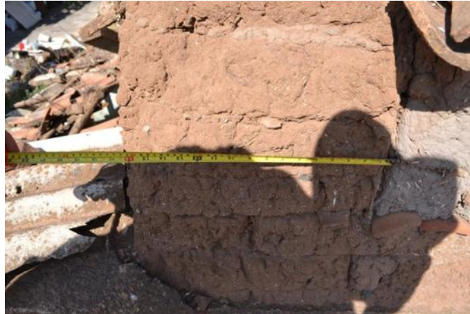
Fotografía 42: Vista de un muro cuyo aparejo está conformado por sillares de adobe al máximo discontinuo.
