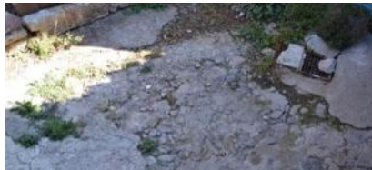
Fotografía 101: Vista del piso de concreto en una sección del patio.
