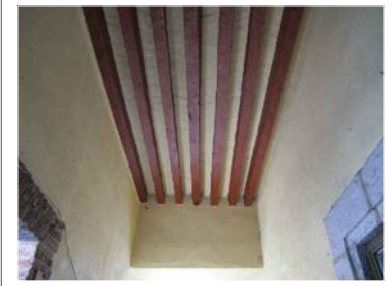
Viguería de madera con tapa de tejamanil y terrado.
