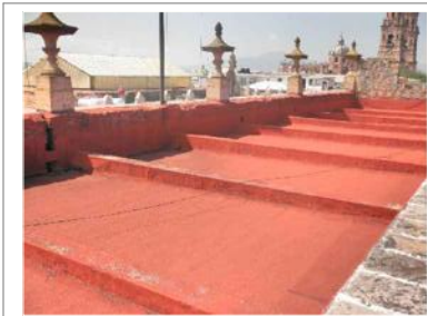
Losa de azotea de concreto armado sobre vigas de concreto armado.
