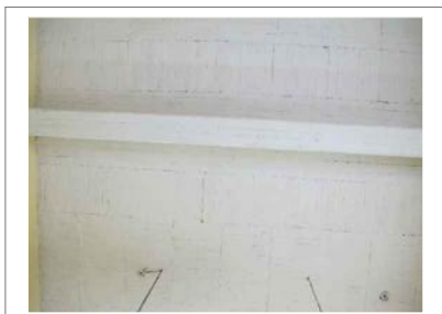
Losa maciza de concreto armado aparente acabado final con pintura vinilica color blanco sobre traves de concreto armado acabado final con pintura vinilica color blanco.
