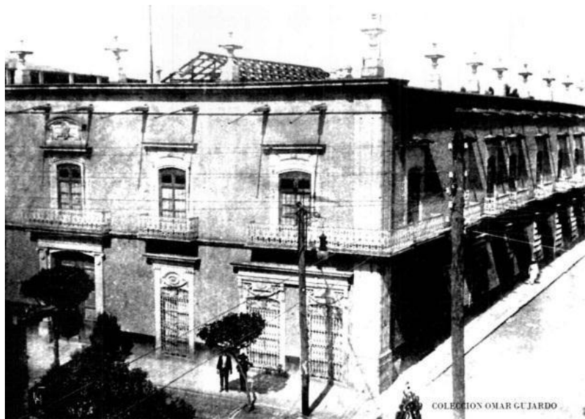
Figura 5. Perspectiva del edificio durante la primera mitad del siglo XX.
