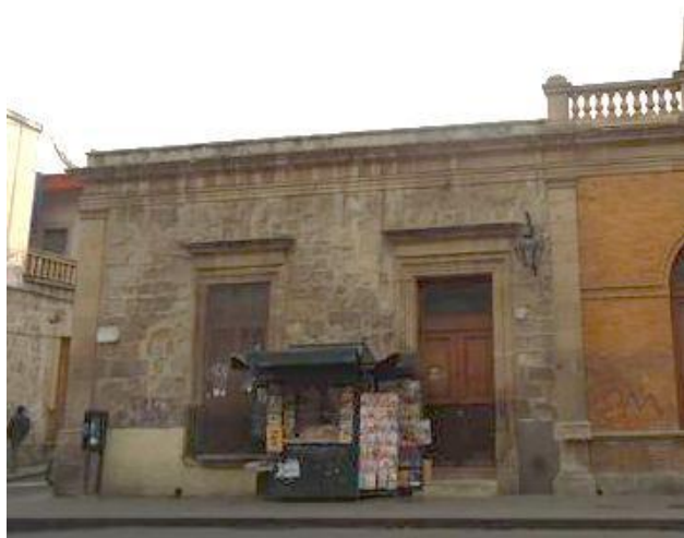
FIG. 2: FACHADA PRINCIPAL AV. MADERO # 380
