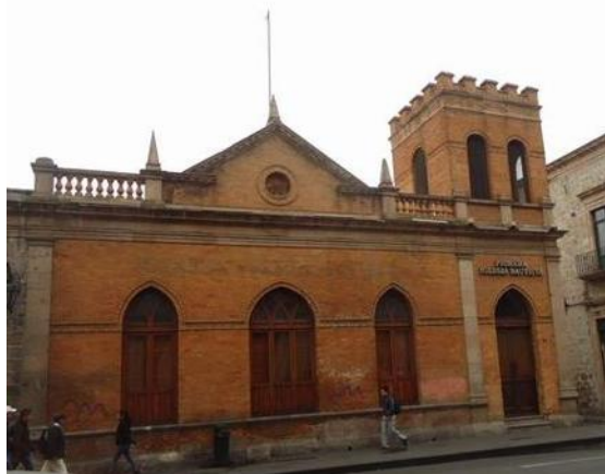
Fig. 1. Fachada Av. Madero # 350
