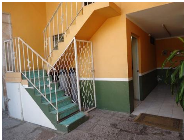
Imagen 49: escalera de acceso al salón 05. Fuente: Arq. E. Gabriela Rodríguez Romero
