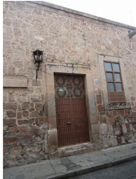
Imagen 100.- Vista parcial de la fachada poniente . Fuente: Arq. E. Gabriela Rodríguez Romero
