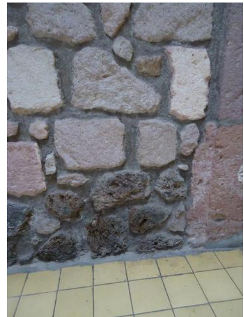
Imagen 21: Detalle de cambio de material en mampostería. Fuente: Arq. E. Gabriela Rodríguez Romero
