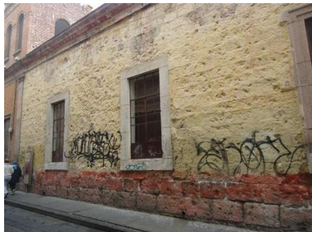
Imagen 101.- Vista parcial de la fachada poniente . Fuente: Arq. E. Gabriela Rodríguez Romero
