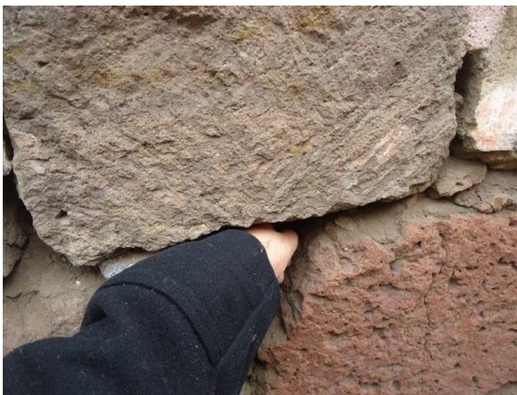
Imagen 106.- Detalle de disgregación del material de la fachada oriente. Fuente: Arq. E. Gabriela Rodríguez Romero
