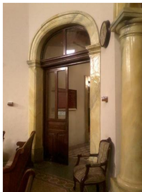
Imagen 31: Detalle de arco y columna. Fuente: Arq. E. Gabriela Rodríguez Romero
