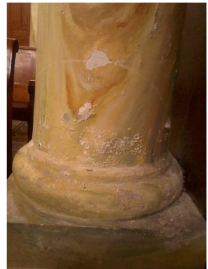
Imagen 19: Detalle de las columnas de la nave central. Fuente: Arq. E. Gabriela Rodríguez Romero
