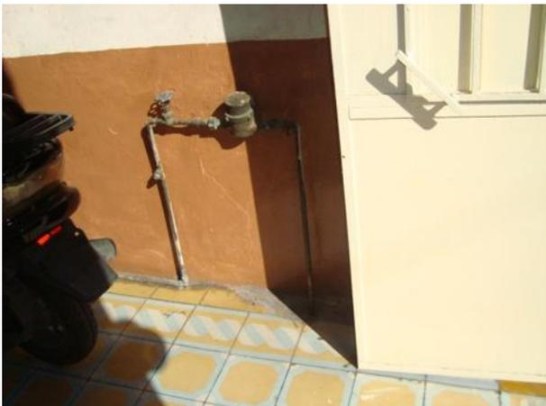
Fig. 41 Medidor de la instalación hidráulica.
