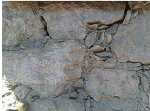
La cubierta es soportada sobre muros de mampostería de piedra irregular y de ladrillo rojo recocido con un aplanado de mortero cemento-arena y un acabado de pintura blanca.
