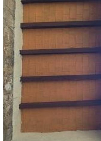
En este espacio se tienen apoyos continuos hecho de adobe con mampostería de piedra con un acabado de mortero cal-arena y pintura como terminado final. La cimentación es continua a los muros.
