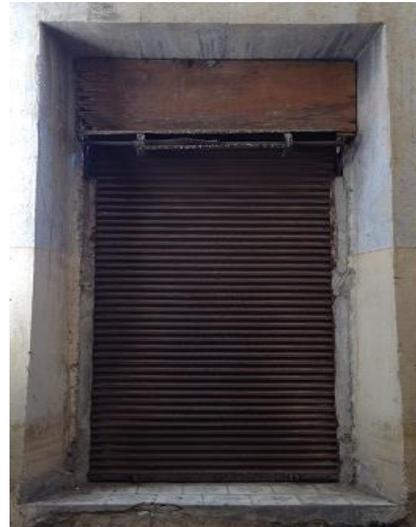
Figura 31 Detalle de derrame en ventana
