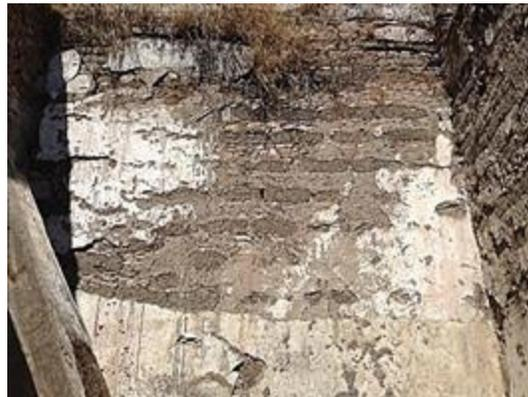
El sistema de muros varía; formado de muros de adobe, piedra irregular y otros de ladrillo rojo recocido. Cuentan con un sistema de cimentación continua.
