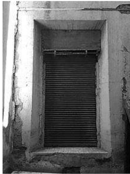
En este espacio se tienen apoyos continuos hecho de adobe con mampostería de piedra con un acabado de mortero cemento-arena y pintura como terminado final, así como muros de ladrillo rojo recocido. La cimentación es continua a los muros.
