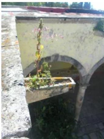
Figura 37. G3rgolas con presencia de microflora. Foto tomada por Aldo Zamudio P3rez
