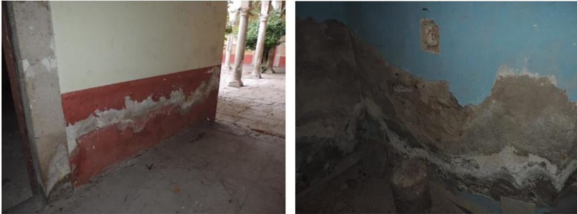
Figura 145-146: Presencia de humedad en los apoyos continuos y en los pisos. Fotos tomadas por Aldo Zamudio P3rez
