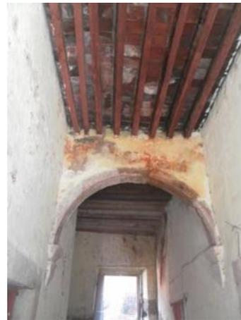
Figura 36. Humedad en cubierta y apoyos. Foto tomada por A.Z.P.
