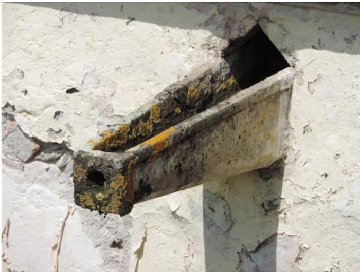
Figura 77. Detalle de las descargas pluviales. Foto tomada por Aldo Zamudio P3rez
