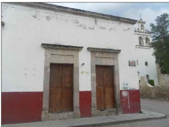
Las puertas de la tienda son de madera en base a puerta abatible de doble hoja, marcos de cantería labrada compuesta por jambas, platabanda y guardapolvos con acabado aparente.
