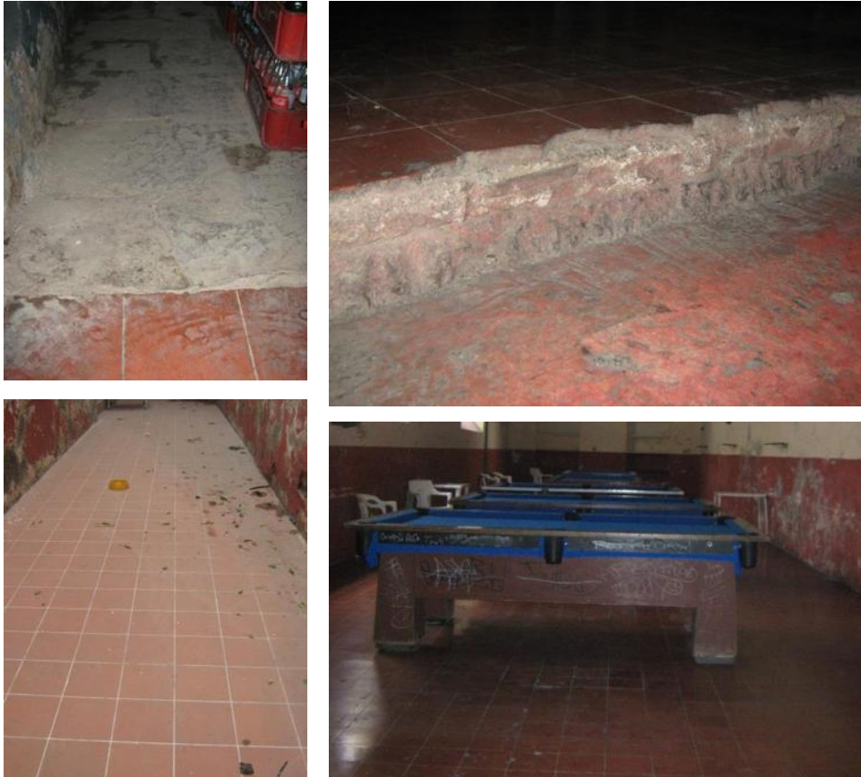
Imágenes 43, 44, 45, 46. Pisos en el patio principal y vestigios de presencia de baldosa de cantería en lo que era el corredor transversal poniente. Fuente: ABG.
