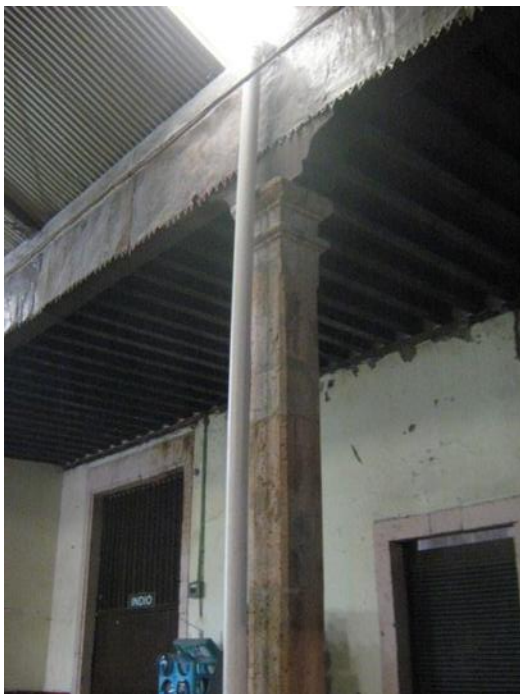
Imágenes 51. 52 Apoyos aislados de cantería. Fuente: ARG
