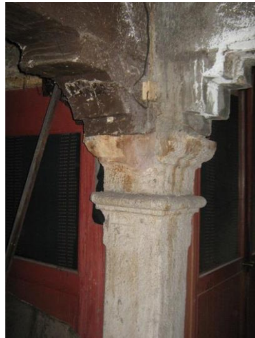
Imágenes 51. 52 Apoyos aislados de cantería. Fuente: ARG
