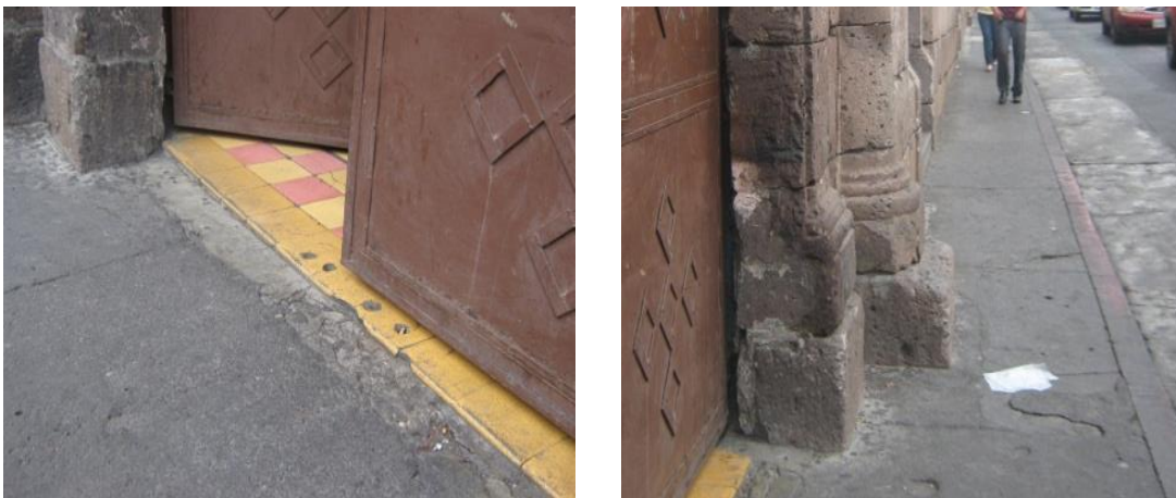
Imágenes 37, 38. Pisos en el acceso al inmueble. Fuente: ABG.
