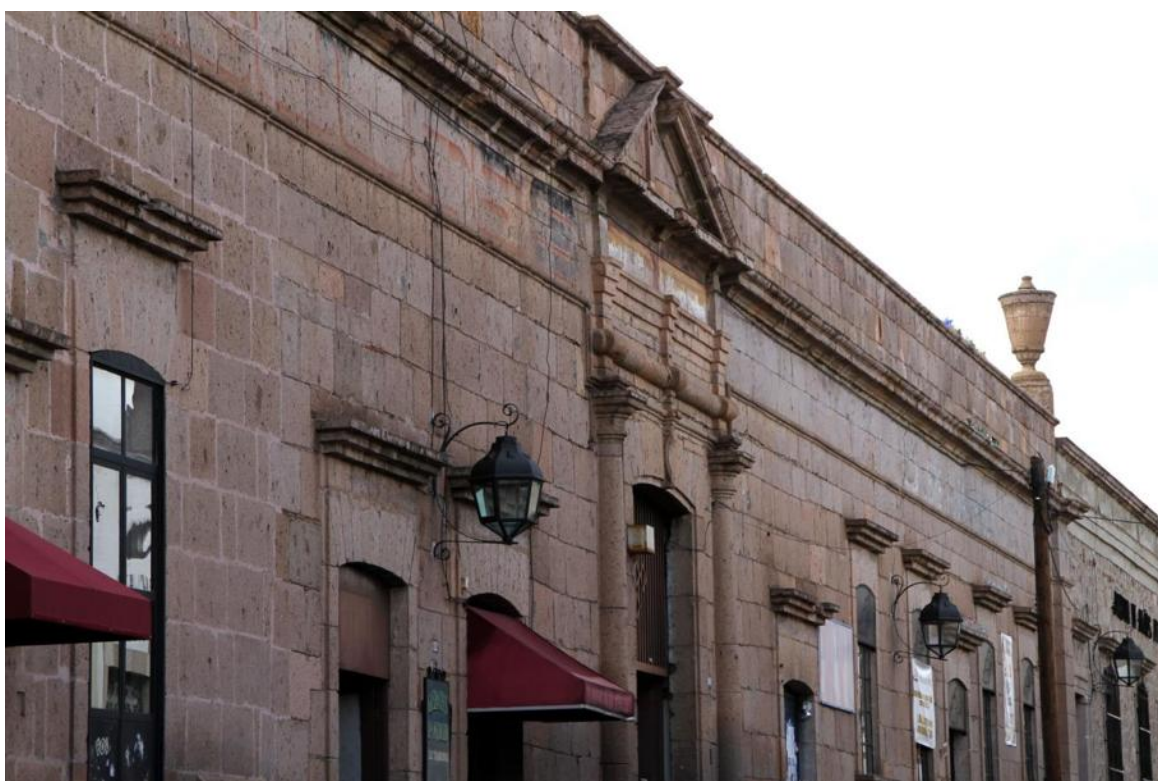
Imagen 22. Fachada de la propiedad, detalle del acceso de mayor jerarquía que corresponde al inmueble con el #186, catalogado como monumento histórico en la declaratoria de 1990. Fuente: Fotografía tomada por Ariadna Bautista González.
