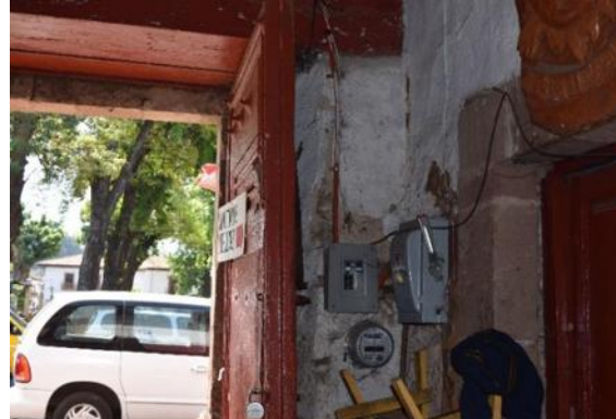
Imagen 47 y 48. Instalaciones eléctricas inadecuadas Fotos: Perdomo/Tello Marzo 2015
