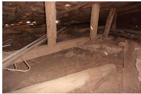
Imagen 39 y 40. Tablado con pérdida de terrado y peso adicional por pesencia de desperdicios Fotos: Perdomo/Tello Marzo 2015
