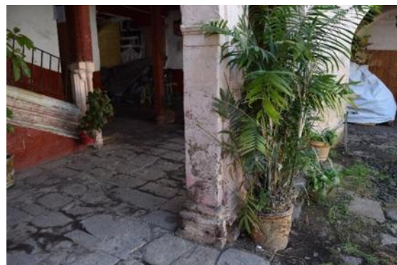
Imagen 43 y 44. Guardapolvo a base de pintura vinílica, marcos y arquería de cantera con recubrimiento de pintura. Fotos: Perdomo/Tello Marzo 2015
