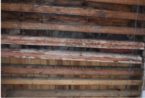
Imagen 37y 38. Vigería con humedad y tablado con evidente deterioro. Fotos: Perdomo/Tello Marzo 2015
