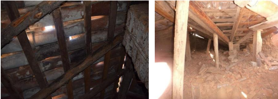
Imágenes 25 y 26. Fotografías cubierta vista interior. Fuente: Perdomo/Tello Marzo 2015
