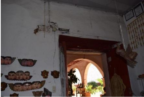
Imagen 47 y 48. Instalaciones eléctricas inadecuadas Fotos: Perdomo/Tello Marzo 2015
