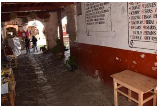
Imagen 43 y 44. Guardapolvo a base de pintura vinílica, marcos y arquería de cantera con recubrimiento de pintura. Fotos: Perdomo/Tello Marzo 2015
