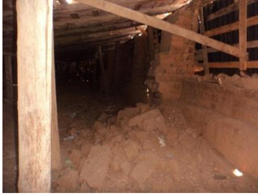
Imagen 41 y 42. Disgregación de adobe en elementos de apoyo de cubierta y reparaciones de nivelación (arrastres) inadecuados. Fotos: Perdomo/Tello Marzo 2015
