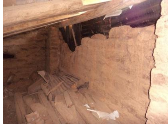
Imagen 41 y 42. Disgregación de adobe en elementos de apoyo de cubierta y reparaciones de nivelación (arrastres) inadecuados. Fotos: Perdomo/Tello Marzo 2015
