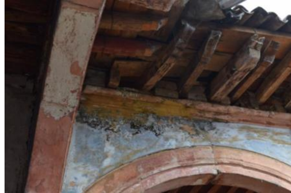
Imagen 37y 38. Vigería con humedad y tablado con evidente deterioro. Fotos: Perdomo/Tello Marzo 2015
